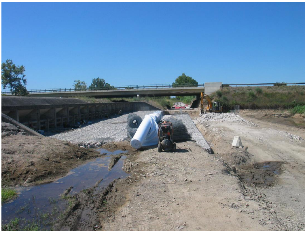
Estrutura de proteção do descarregador de cheias ECC 3 Execução dos gabiões e escavação da zona da vala de drenagem
