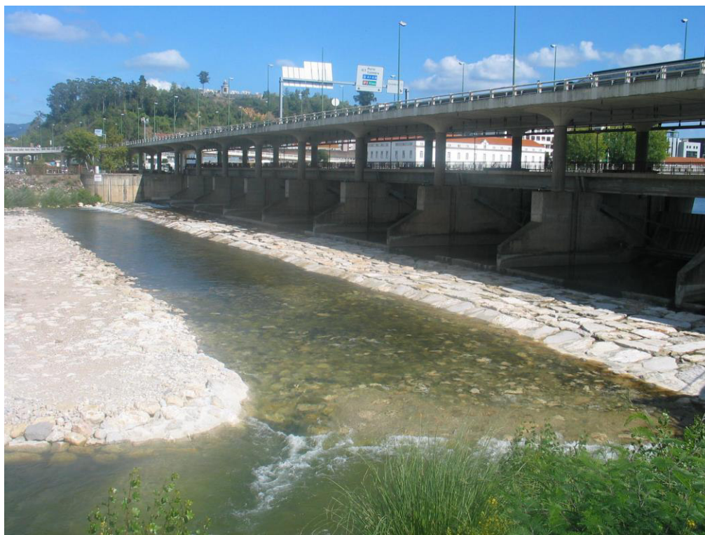
Reabilitação da soleira de proteção dos descarregadores do Açude de Coimbra concluída. Vista da zona de montante
