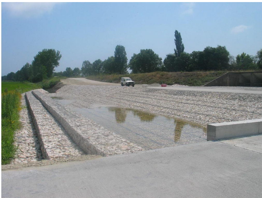
Estrutura de dissipação do descarregador ECC 1 concluída Zona a montante da passagem hidráulica de ligação ao caminho rural
