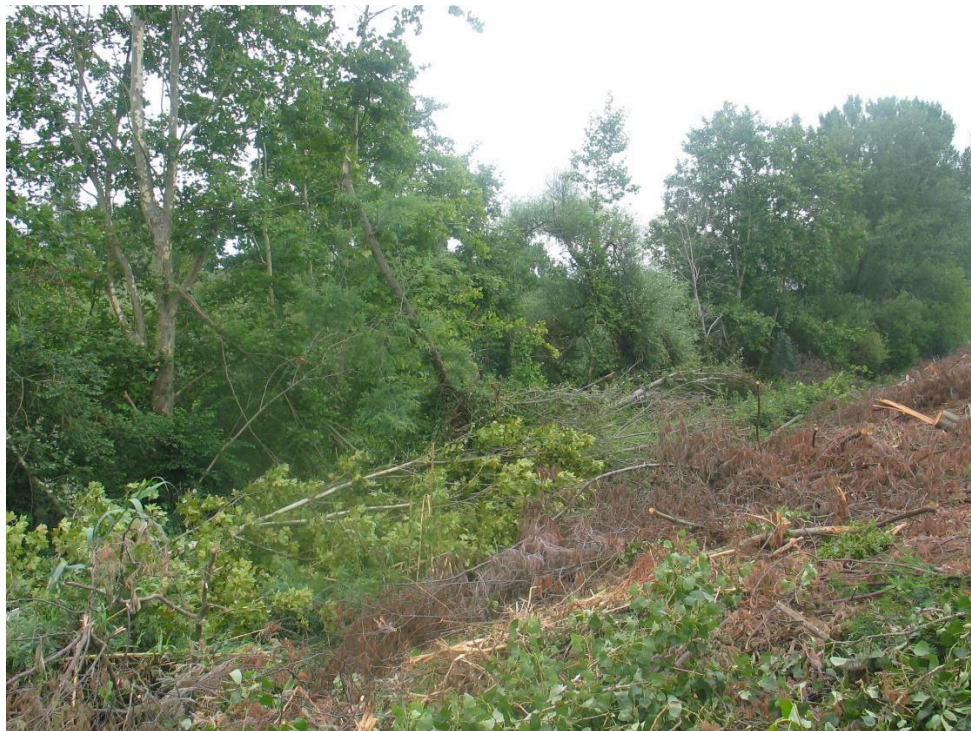
Início da limpeza de vegetação no coroamento do dique da margem esquerda, na zona entre Taveiro e Arzila Aspecto da vegetação antes da limpeza
