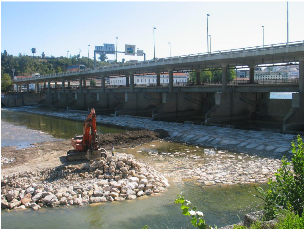
Reabilitação da soleira de proteção dos descarregadores do Açude- Ponte de Coimbra Pormenor da regularização e colocação de enrocamento pesado na zona de descarga lateral da soleira de proteção
