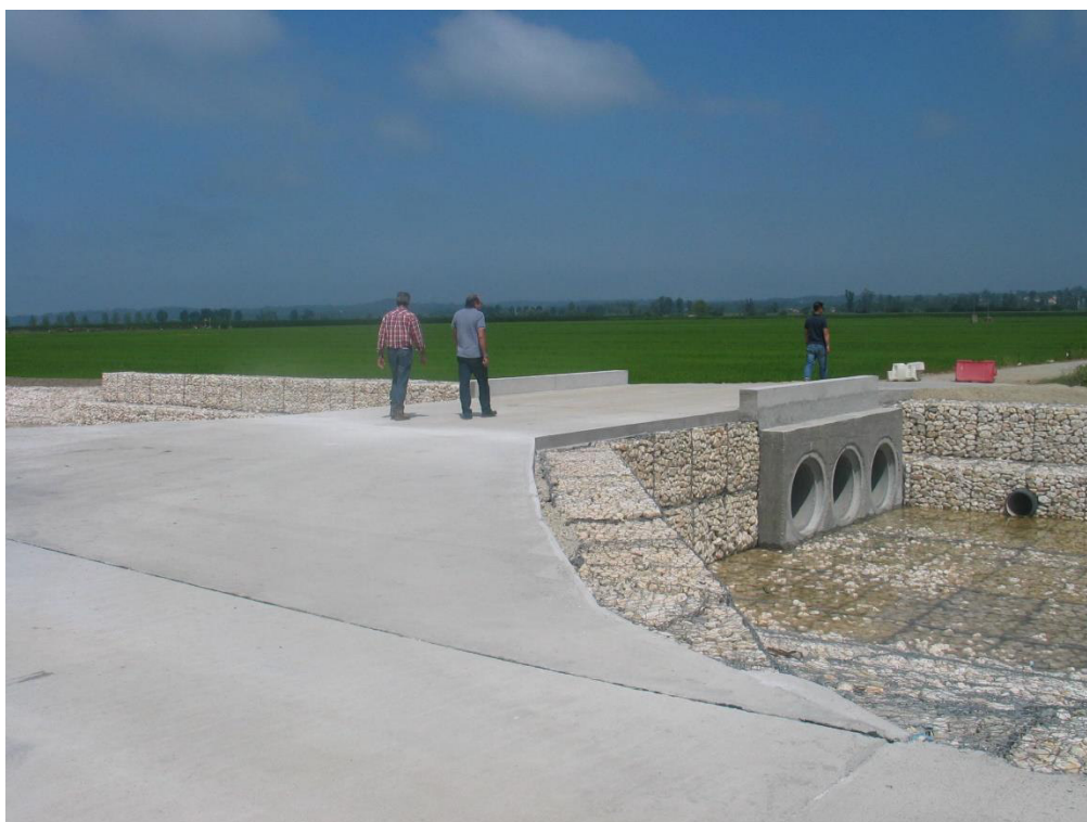
Estrutura de dissipação do descarregador ECC 1 concluída Zona da passagem hidráulica de ligação ao caminho rural
