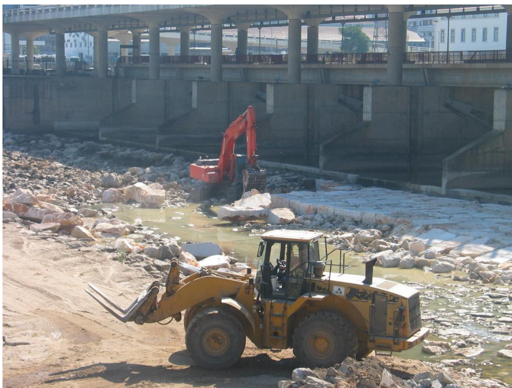
Reabilitação da soleira de proteção dos descarregadores do Açude- Ponte de Coimbra Execução do enrocamento arrumado com face plana
