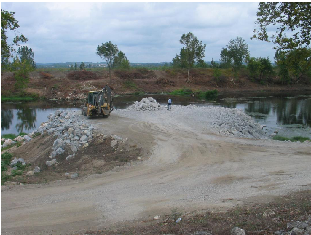
Reabilitação da soleira de fixação do fundo com desnível ao P 115 Início da colocação de enrocamento no esporão da margem esquerda
