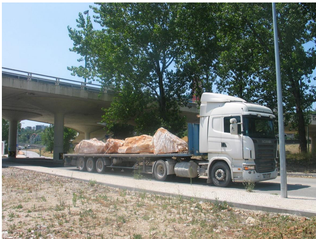
Reabilitação da soleira de proteção dos descarregadores do Açude- Ponte de Coimbra Transporte de enrocamento de grande dimensão
