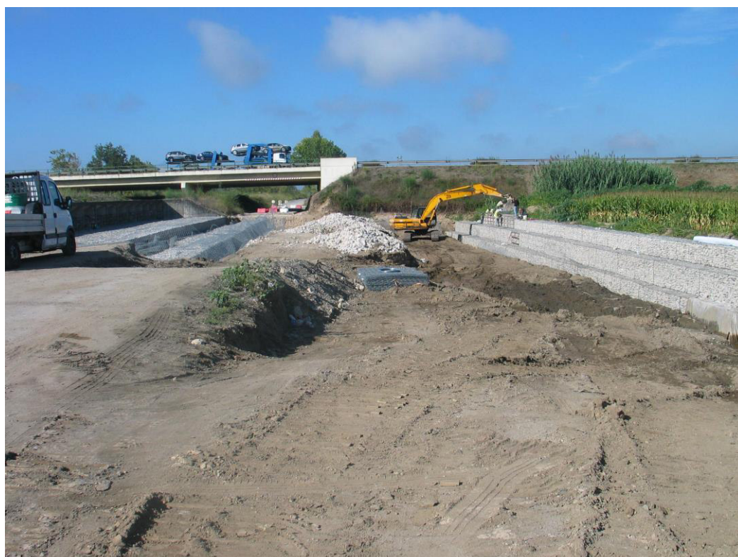
Estrutura de proteção do descarregador de cheias ECC 3 Execução dos gabiões de topo no final da estrutura de dissipação
