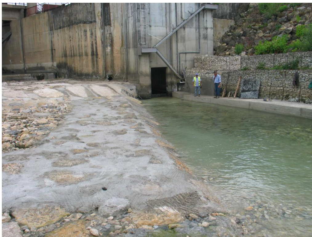
Idem. Betonagem dos interstícios do enrocamento na zona de descarga lateral da soleira de proteção em enrocamento
