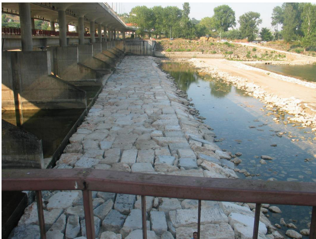
Reabilitação da soleira de proteção dos descarregadores do Açude- Ponte de Coimbra Colocação do enrocamento de proteção concluído
