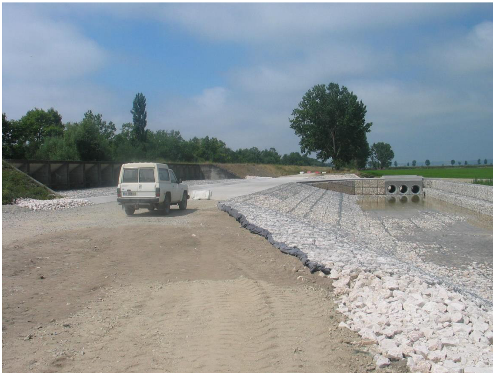
Estrutura de dissipação do descarregador ECC 1 concluída
