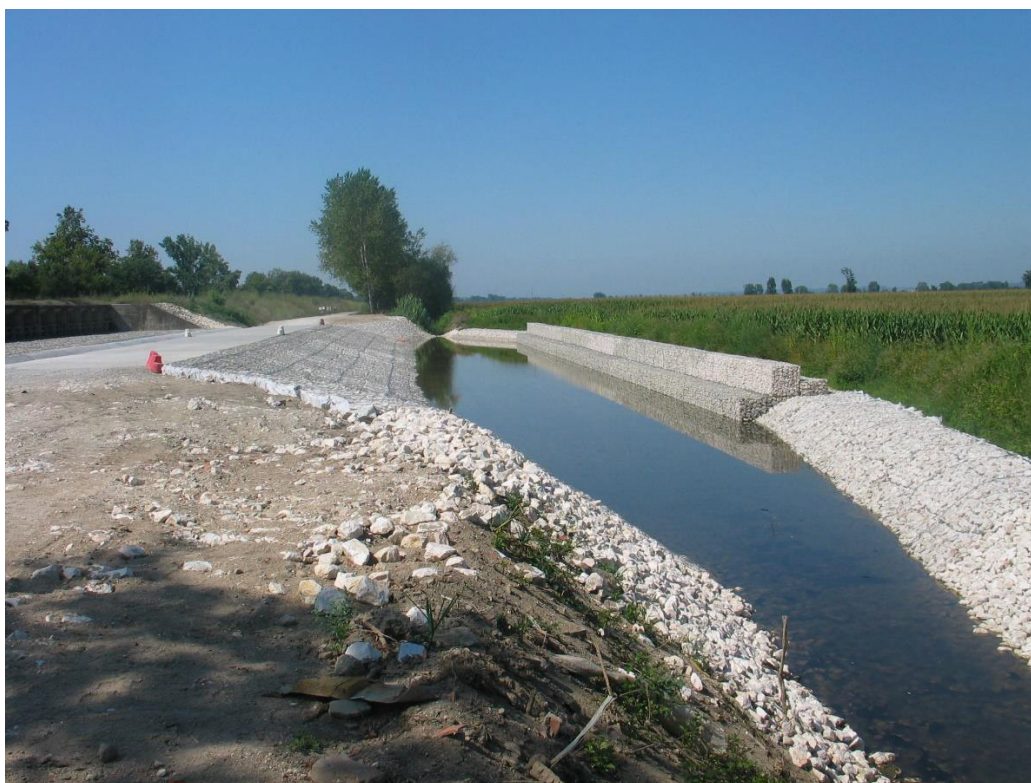
Estrutura de dissipação de energia do descarregador ECC 2 concluída Pormenor da vala de drenagem
