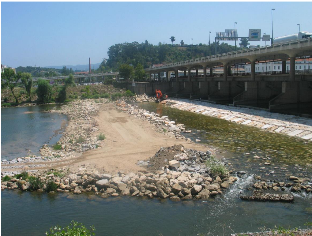
Reabilitação da soleira de proteção dos descarregadores do Açude- Ponte de Coimbra Execução do enrocamento de proteção à erosão, em fase avançada
