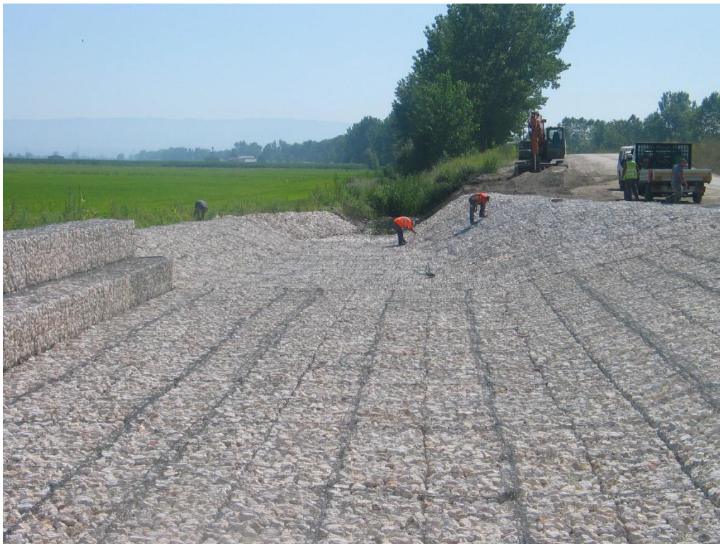
Execução dos colchões Reno na vala de drenagem da estrutura de dissipação do descarregador ECC 1
