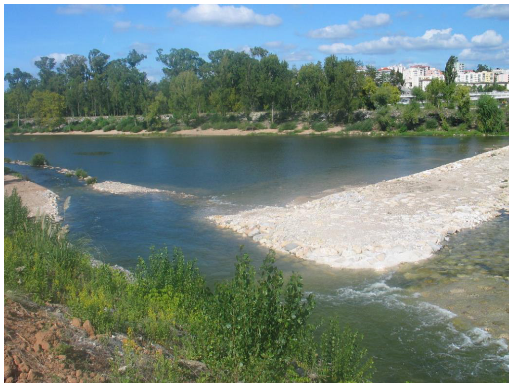
Reabilitação da soleira de proteção dos descarregadores do Açude de Coimbra concluída. Vista da zona de jusante
