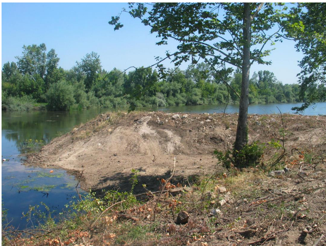
Reabilitação da soleira de fixação do fundo com desnível ao P 115 Estado inicial do leito e esporão da margem esquerda
