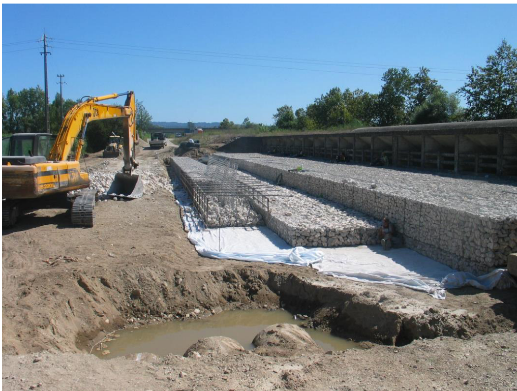
Estrutura de proteção do descarregador de cheias ECC 3 Evolução da execução dos gabiões junto à saída do descarregador
