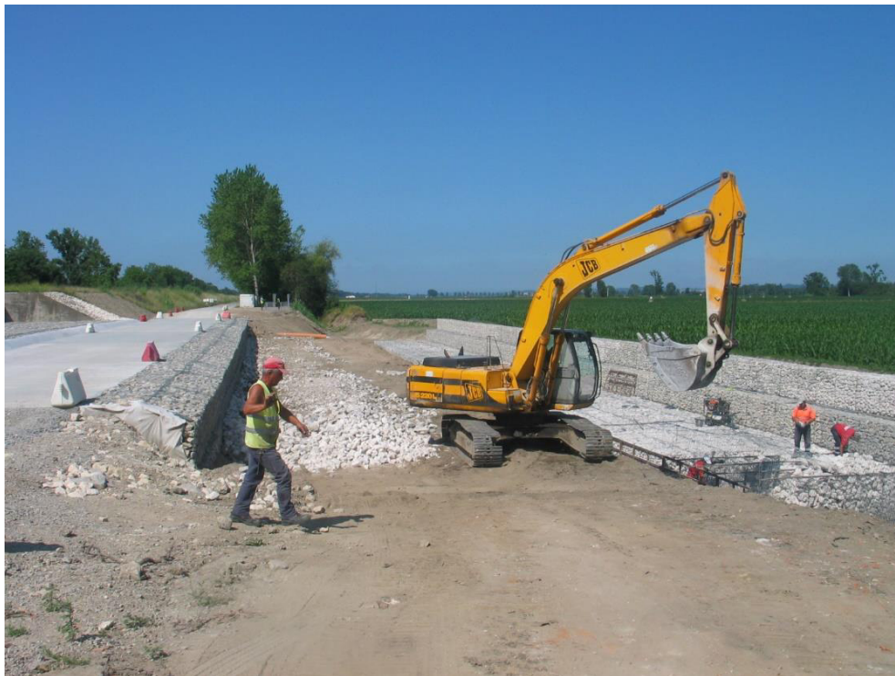
Execução dos gabiões na vala da estrutura de dissipação do descarregador ECC 2
