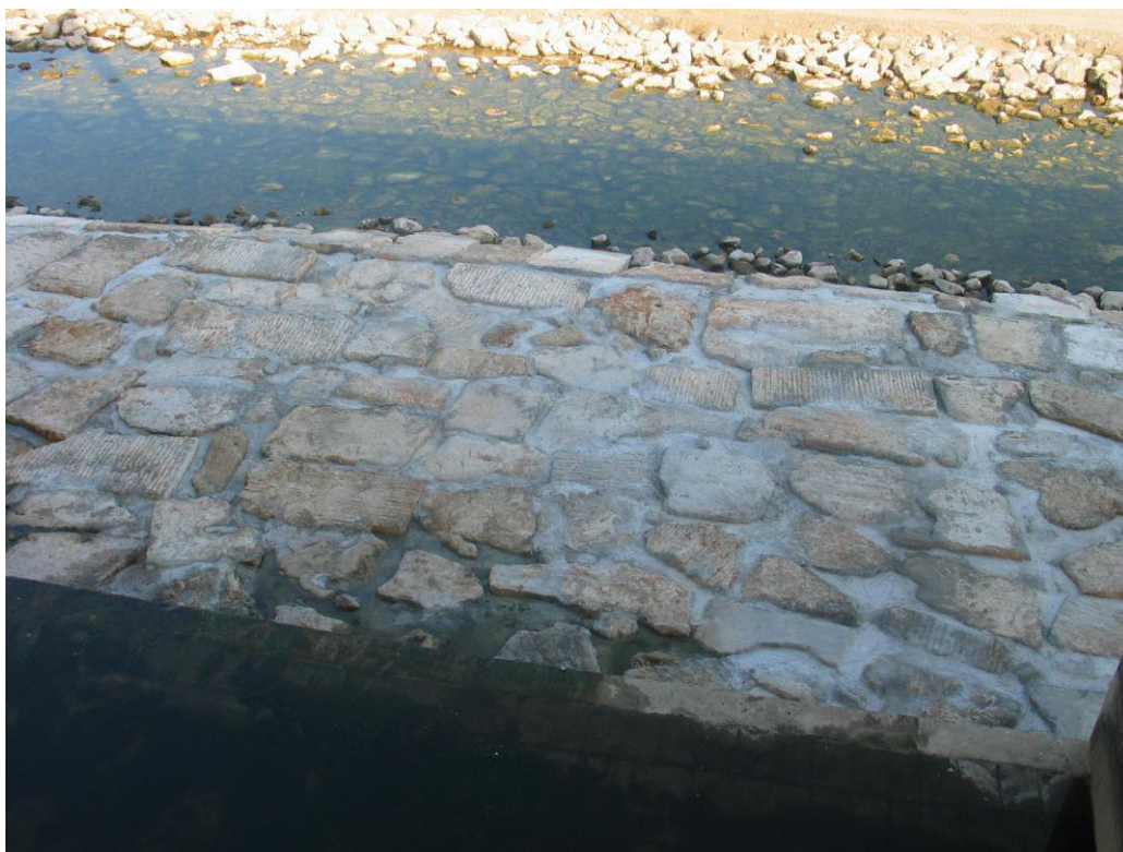
Reabilitação da soleira de proteção dos descarregadores do Açude- Ponte de Coimbra Betonagem dos interstícios do enrocamento. Pormenor
