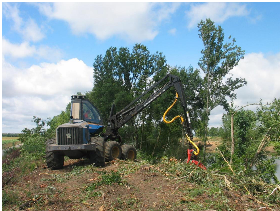
Limpeza de vegetação no coroamento do dique da margem esquerda, na zona entre Taveiro e Arzil
