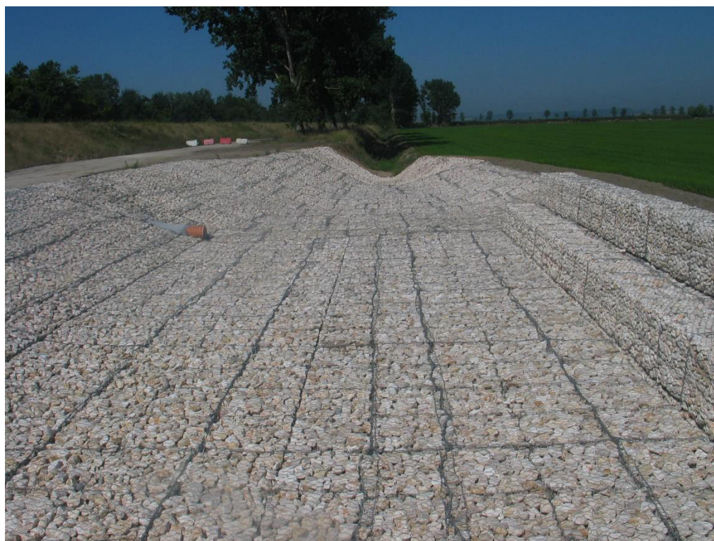
Estrutura de dissipação do descarregador ECC 1 concluída Zona a jusante da passagem hidráulica de ligação ao caminho rural
