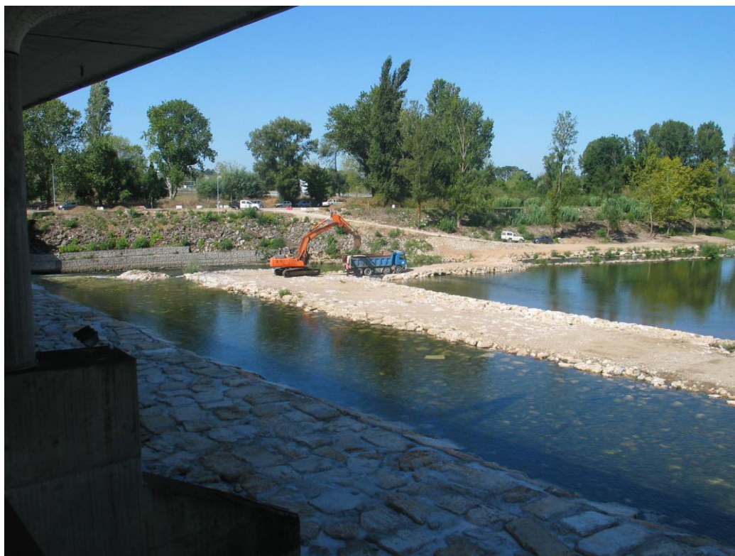
Idem. Regularização e colocação de enrocamento pesado na zona de descarga lateral da soleira de proteção
