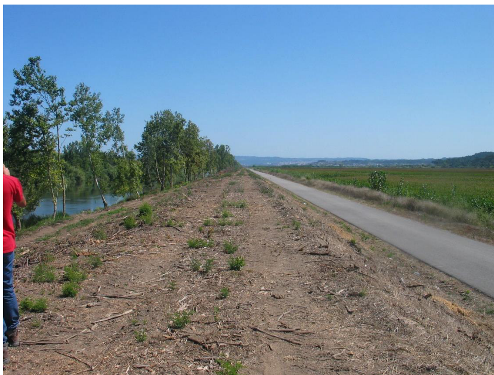
Limpeza de vegetação na margem esquerda entre Taveiro e Arzila concluída Vista para montante
