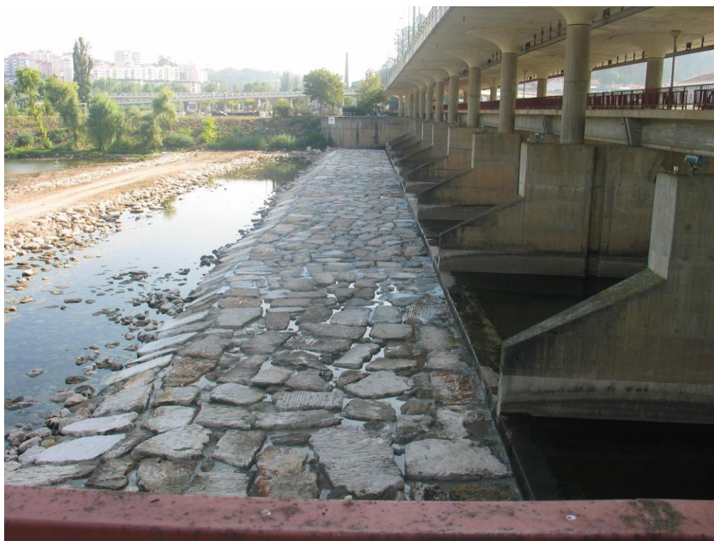
Idem. Betonagem dos interstícios do enrocamento
