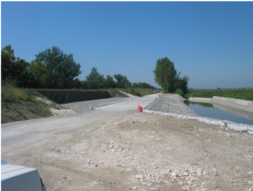
Estrutura de dissipação de energia do descarregador ECC 2 concluída
