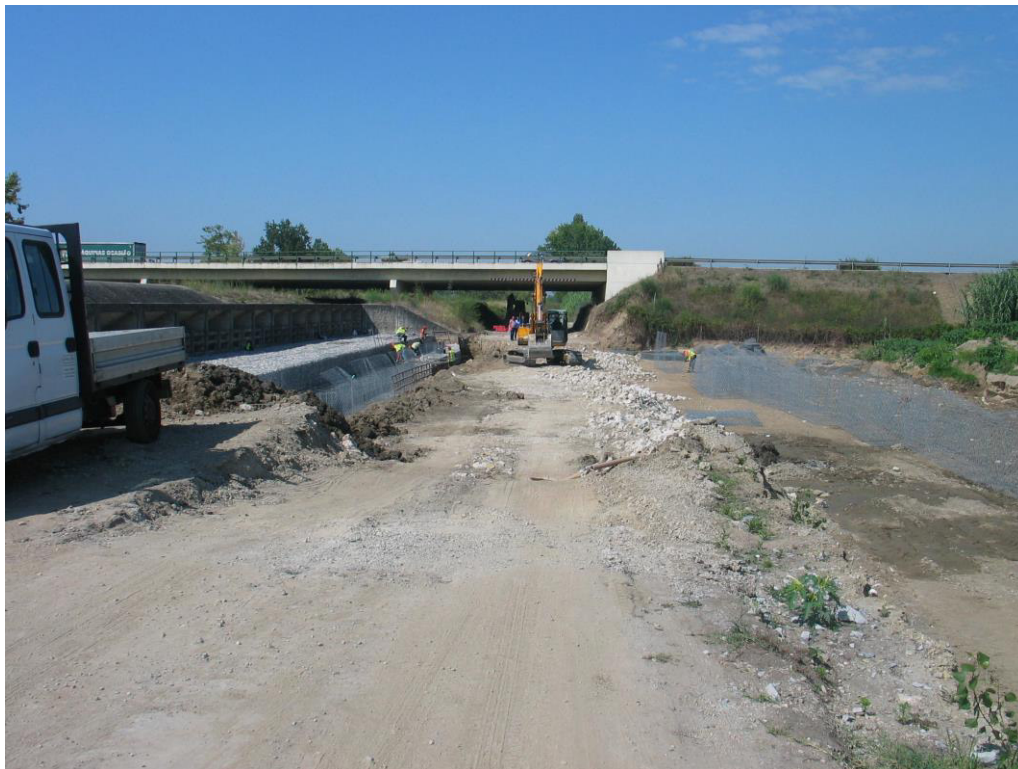
Estrutura de proteção do descarregador de cheias ECC 3 Início da execução dos gabiões junto à saída do descarregador
