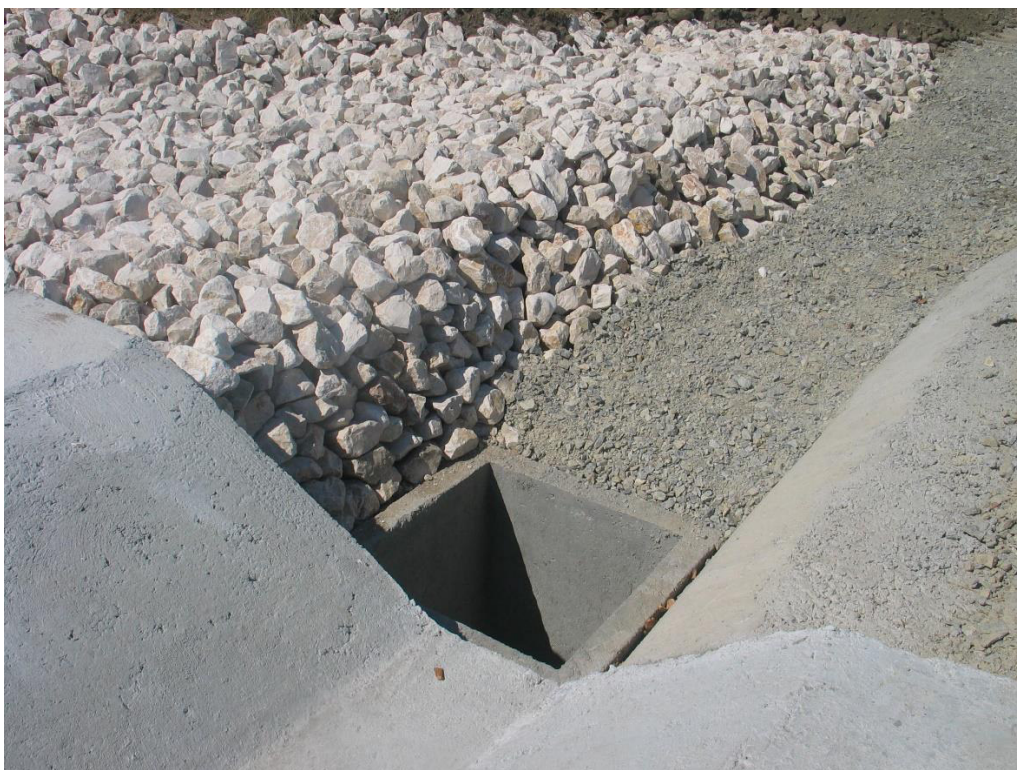
Pormenor da drenagem da estrada na estrutura de dissipação do descarregador ECC 1
