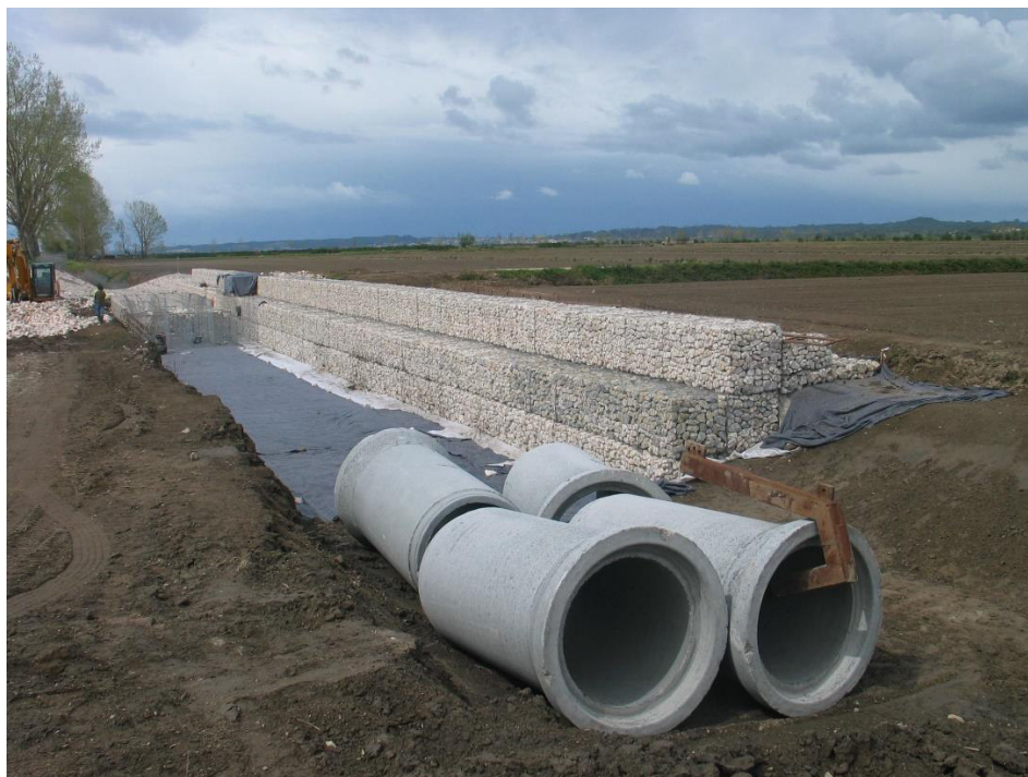
Início da execução dos gabiões e colocação de manilhas na zona da vala, na estrutura de dissipação do descarregador EEC 1
