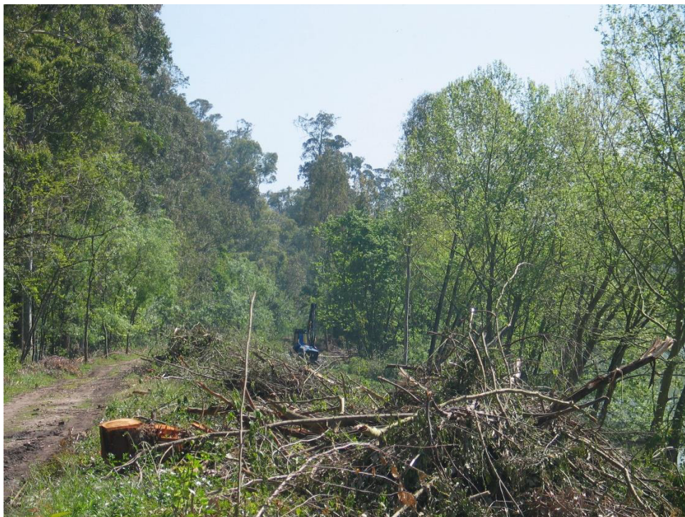
Início da limpeza de vegetação no coroamento do dique da margem direita na zona do Choupal Aspecto da vegetação para montante antes da limpeza
