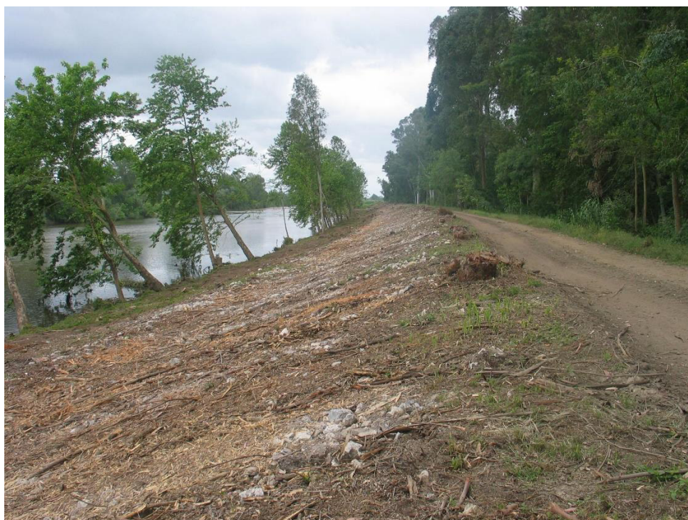
Limpeza de vegetação no coroamento do dique da margem direita na zona do Choupal concluída Vista para jusante
