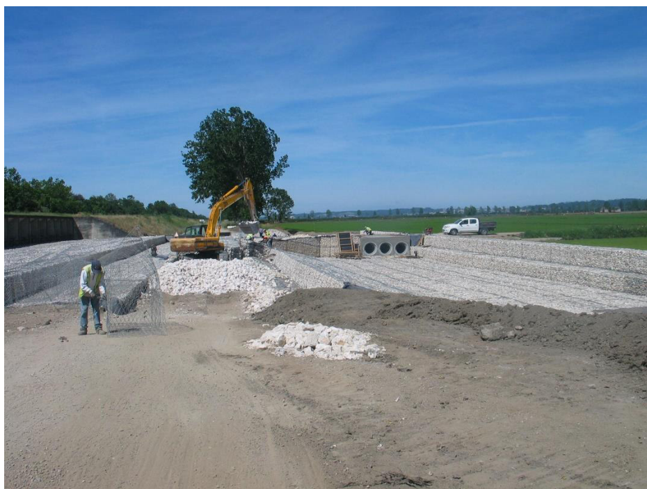
Aspecto da evolução da execução de gabiões na estrutura de dissipação de energia do descarregador ECC1 Betonagem da passagem sobre a vala
