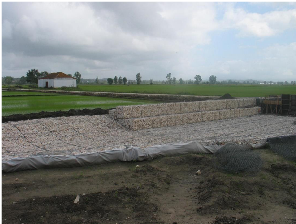
Aspecto da evolução da execução de gabiões e colchão “Reno” na vala, na estrutura de dissipação de energia do descarregador ECC1
