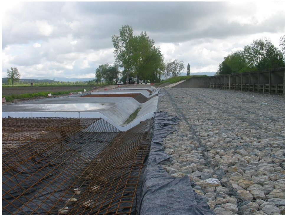
Idem. Betonagem da zona da estrada de manutenção na estrutura de dissipação do descarregador ECC 2 Vista para montante
