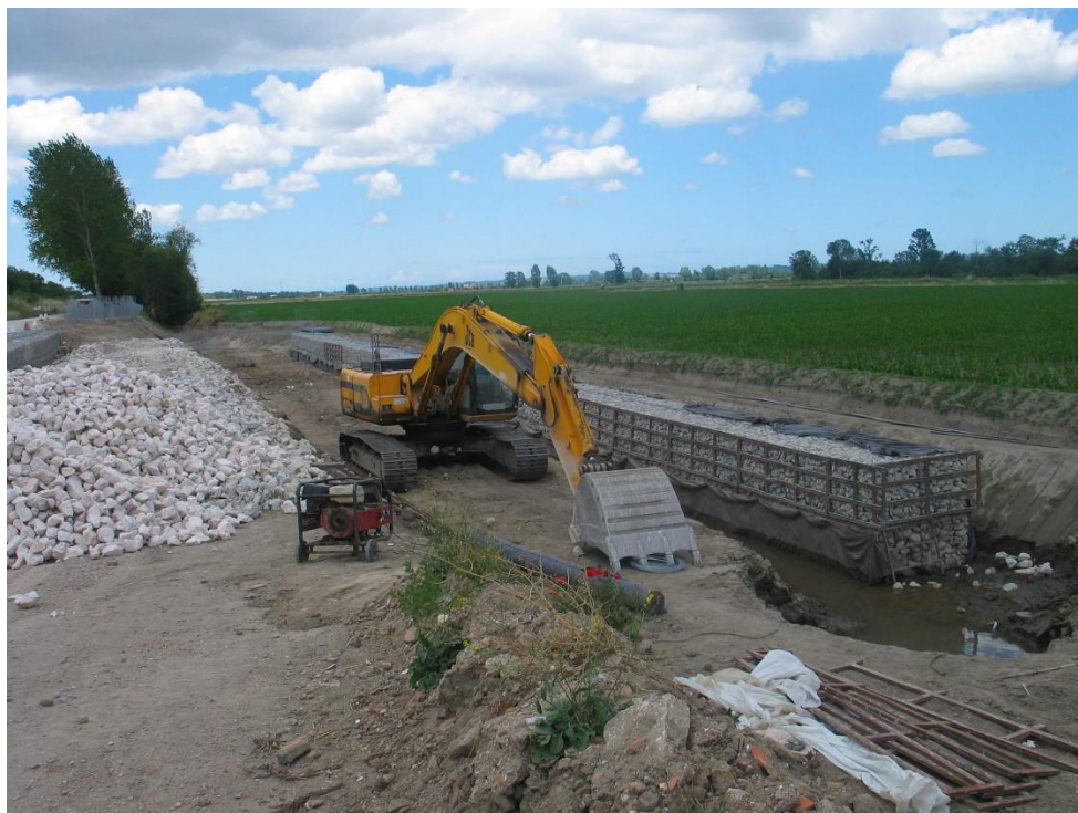
Início da execução dos gabiões na vala da estrutura de dissipação de energia do descarregador de cheias ECC 2
