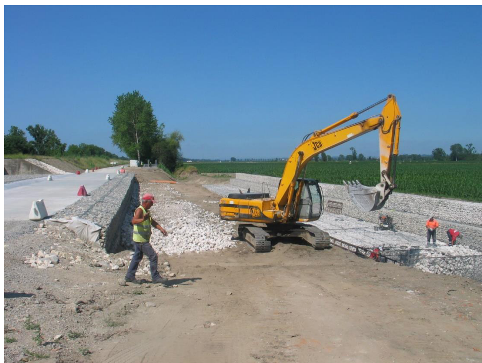
Aspecto da evolução da execução dos gabiões na vala da estrutura de dissipação de energia do descarregador de cheias ECC 2
