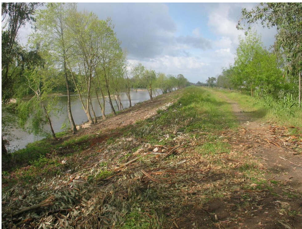
Dique da margem direita a montante da auto estrada A1 durante a limpeza
