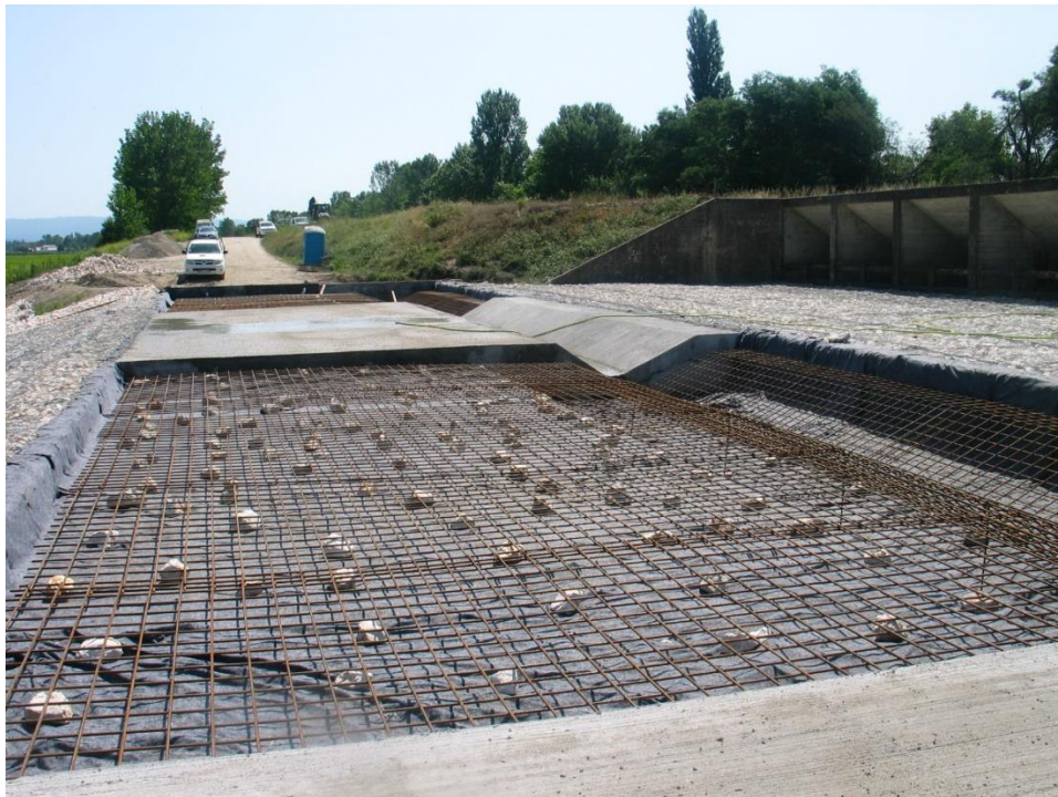
Estrutura de proteção do descarregador de cheias ECC 1 Montagem de armadura de ferro e betonagem da zona da estrada de manutenção
