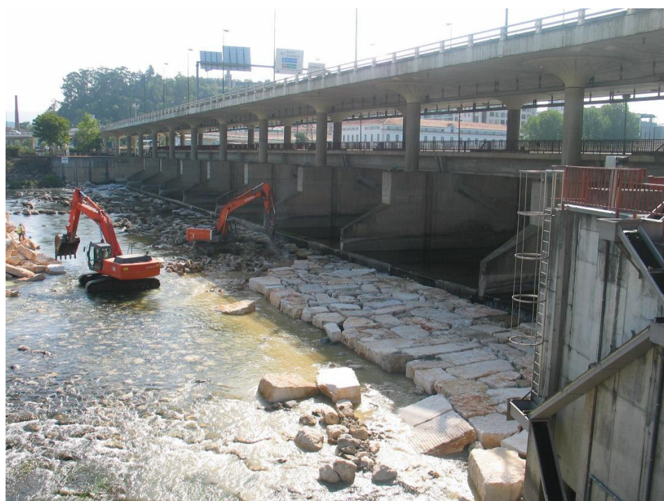
Reabilitação da soleira de proteção dos descarregadores do Açude- Ponte de Coimbra Colocação de enrocamento de grande dimensão
