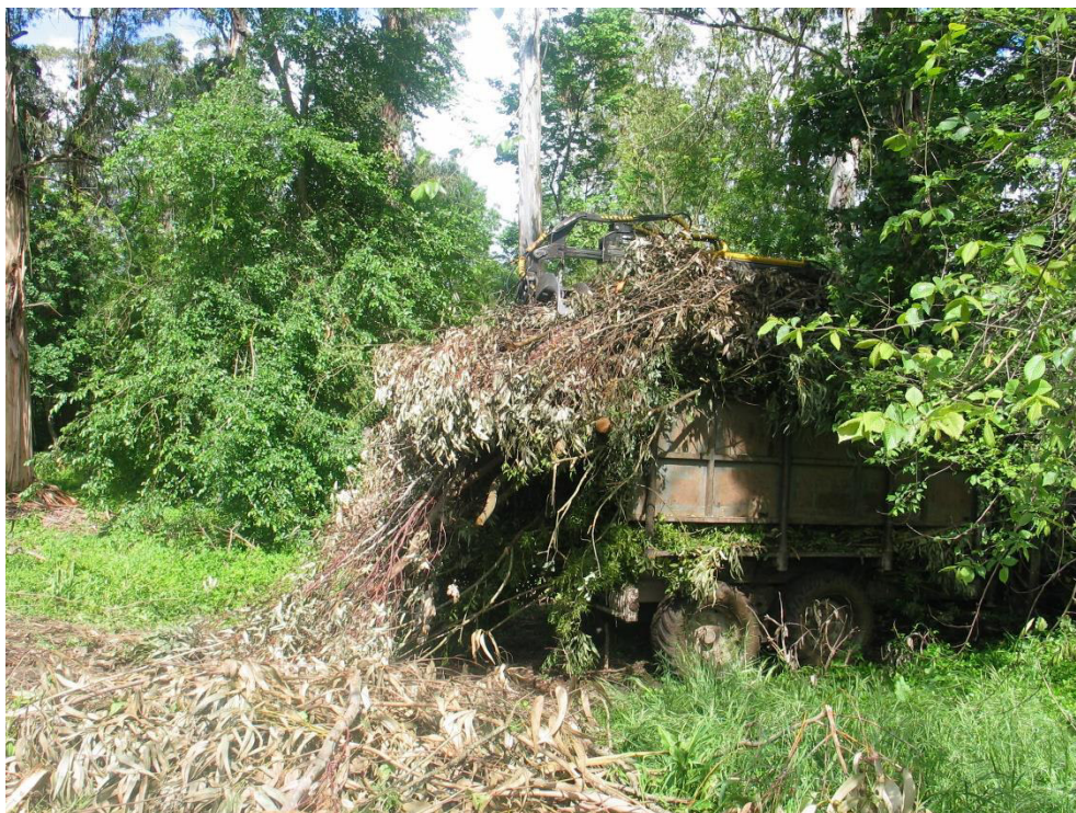
Dique da margem direita a montante da auto estrada A1 antes da limpeza
