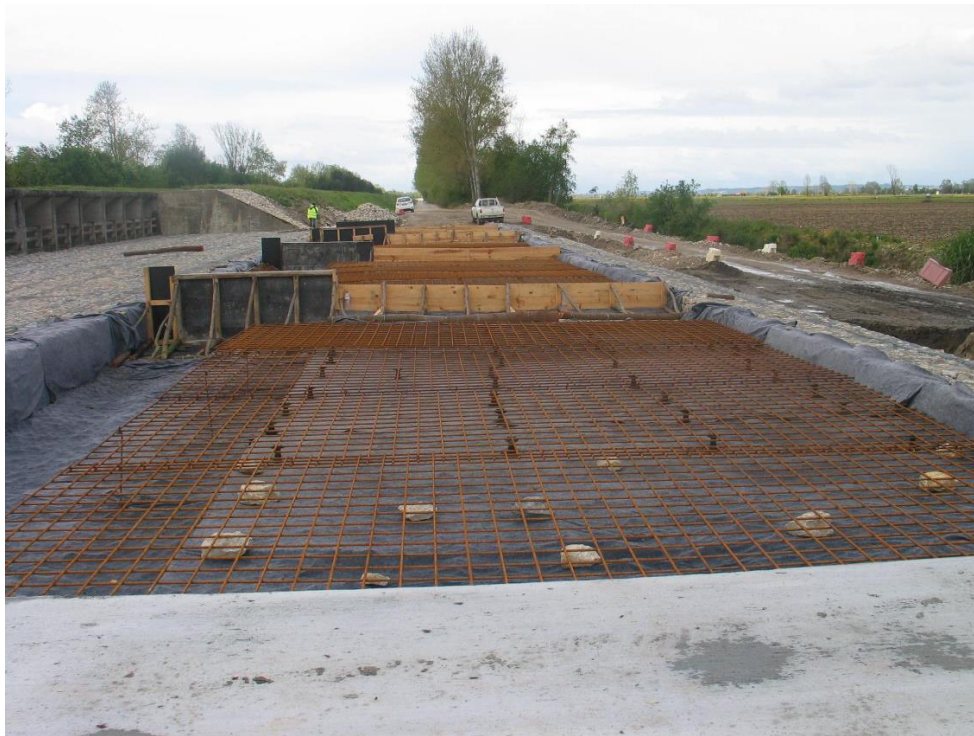
Montagem da armadura para betonagem da zona da estrada de manutenção na estrutura de dissipação do descarregador ECC 2
