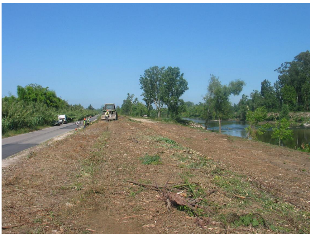
Limpeza de vegetação do dique da margem esquerda na zona de Taveiro concluída
