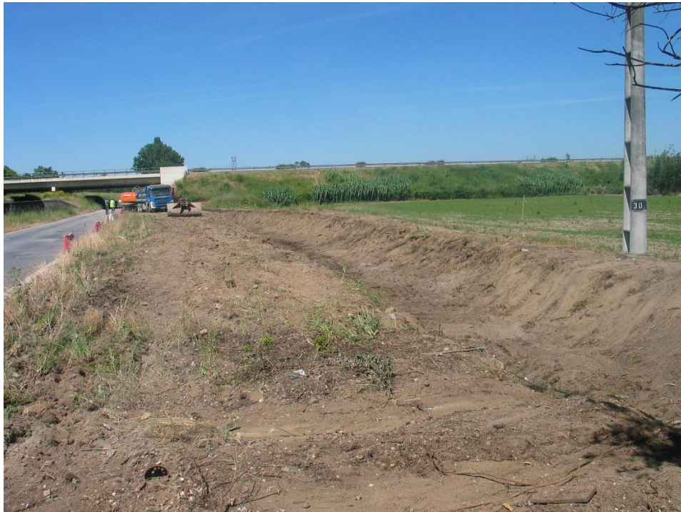
Estrutura de proteção do descarregador de cheias ECC 3 Início da escavação na zona da vala de enxugo
