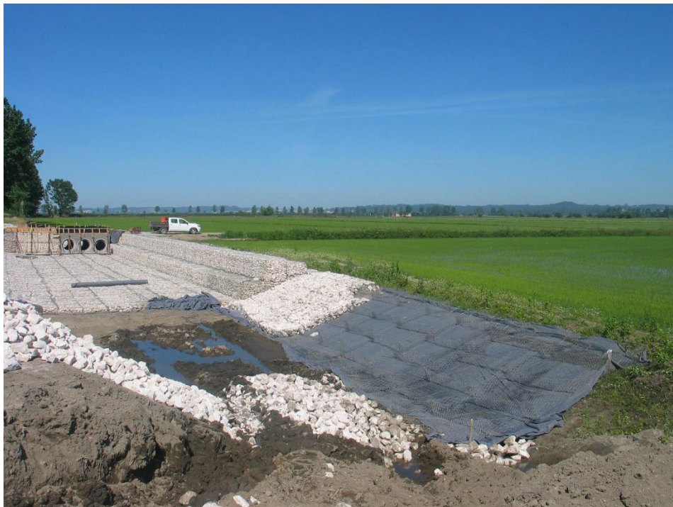
Início da execução do colchão “Reno” de montante na vala da estrutura de proteção do descarregador de cheias ECC1
