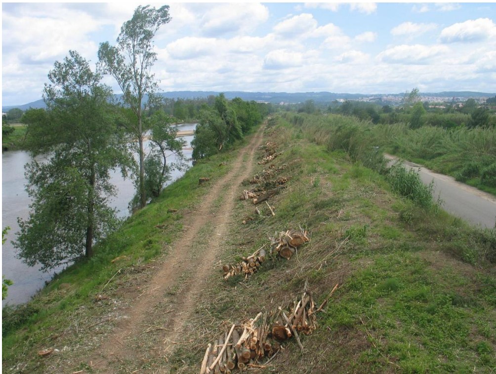
Limpeza de vegetação no dique da margem esquerda a jusante da auto estrada A1
