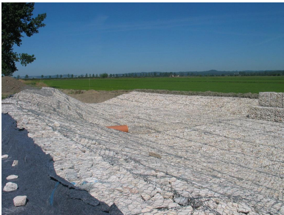
Estrutura de dissipação de energia do descarregador ECC1 Execução do colchão “Reno” de jusante concluída
