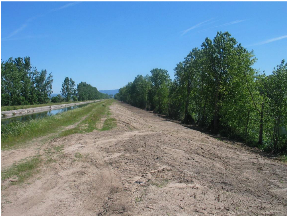
Limpeza do dique da margem direita a montante da auto estrada A1 concluída
