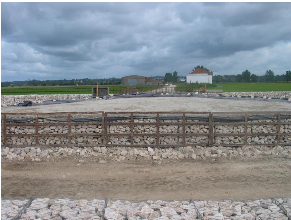
Estrutura de proteção em gabiões do descarregador ECC1 Aterro para modelação de terreno na passagem hidráulica
