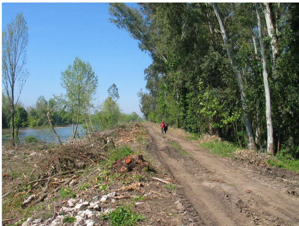
Limpeza de vegetação no coroamento do dique da margem direita na zona do Choupal Vista para jusante
