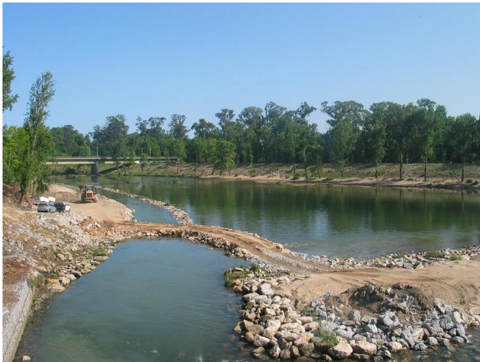
Reabilitação da soleira de proteção dos descarregadores do Açude- Ponte de Coimbra Execução do acesso provisório
