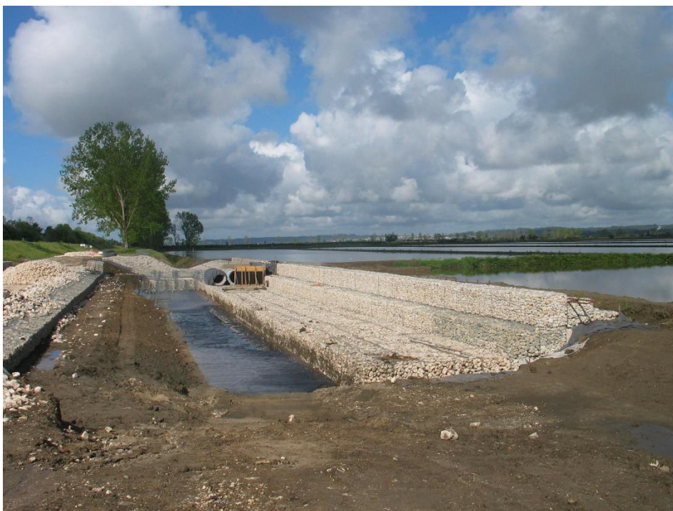
Idem. Colocação das manilhas no fundo da vala para execução de passagem
