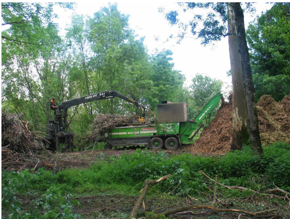
Destroçamento completo dos resíduos da limpeza de vegetação, em depósito
