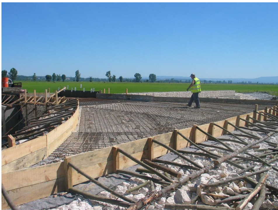
Estrutura de proteção do descarregador ECC1 Montagem de armadura de ferro na passagem hidráulica
