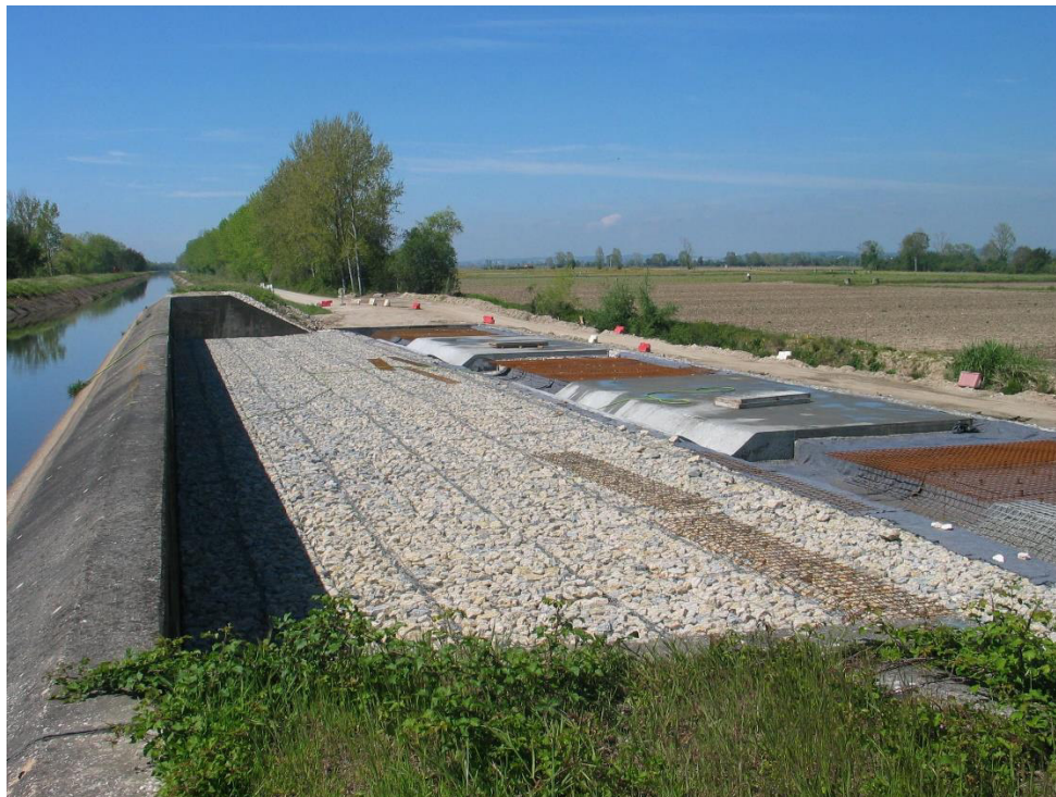
Idem. Betonagem da zona da estrada de manutenção na estrutura de dissipação do descarregador ECC 2 Vista para jusante
