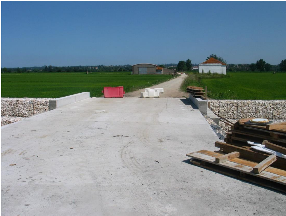
Estrutura de proteção do descarregador de cheias ECC 1 Betonagem da passagem hidráulica concluída
