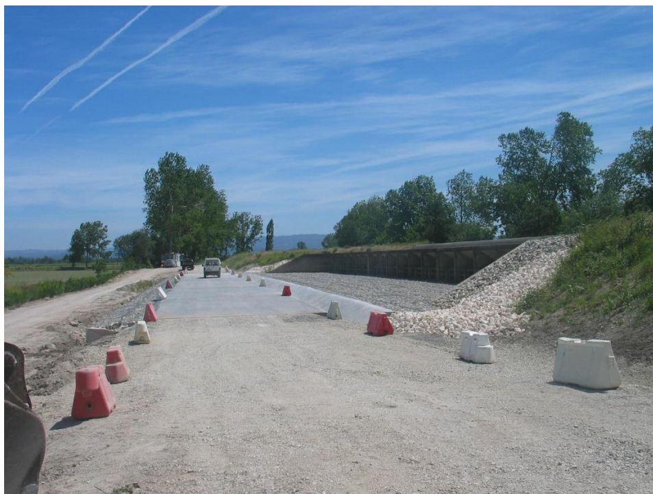
Idem. Betonagem da zona da estrada de manutenção na estrutura de dissipação do descarregador ECC 2 Vista para montante
