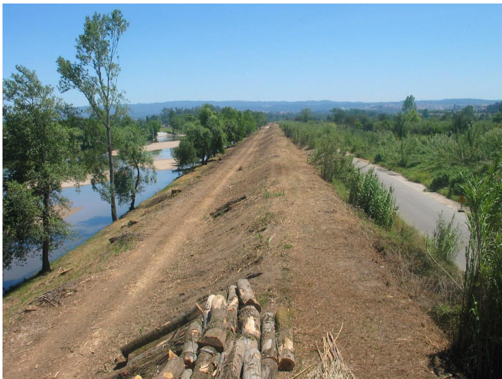
Limpeza de vegetação no dique da margem esquerda, a jusante da auto estrada A1,concluída
