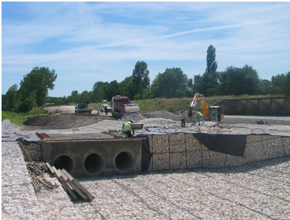
Estrutura de proteção do descarregador ECC1 Preparação para betonagem do piso da passagem hidráulica
