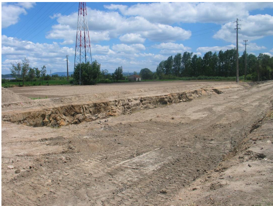
Estrutura de proteção do descarregador de cheias ECC 3 Execução da escavação
