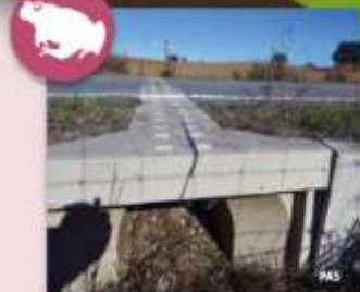
Instalação de passagens específicas para anfíbios
