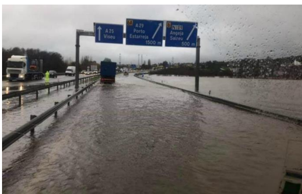
A25 – próximo do nó de Angeja – Fevereiro de 2016
