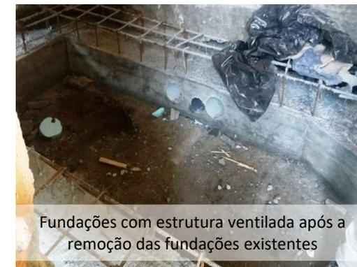
Fundações com estrutura ventilada após a remoção das fundações existentes
