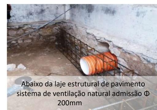
Abaixo da laje estrutural de pavimento sistema de ventilação natural admissão  $\Phi$  200mm
