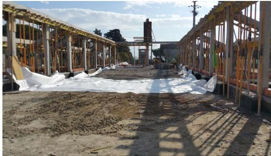
Escavação e substituição de solos até uma profundidade mínima de 0,30m
