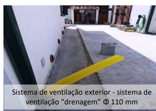
Sistema de ventilação exterior - sistema de ventilação "drenagem"  $\Phi$  110 mm
