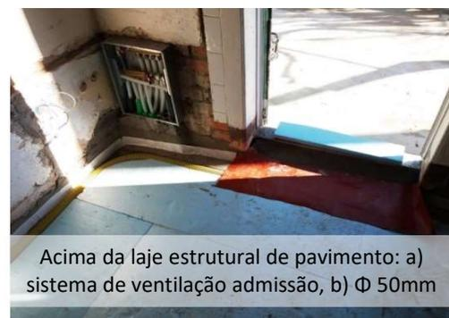
Acima da laje estrutural de pavimento: a) sistema de ventilação admissão, b)  $\Phi$  50mm
