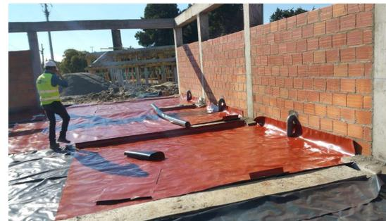
Ligação cuidada aos elementos estruturais e filme plástico de protecção superior das membranas prefabricadas
