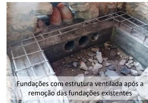
Fundações com estrutura ventilada após a remoção das fundações existentes
