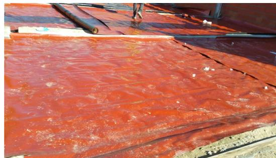
Aplicação de membranas prefabricadas em toda a área do pavimento
