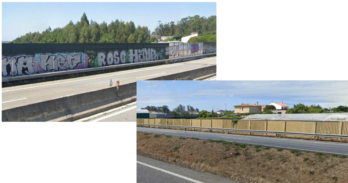
Figura 4-1 – Exemplos de barreiras acústicas de diversos tipos instaladas na A28
