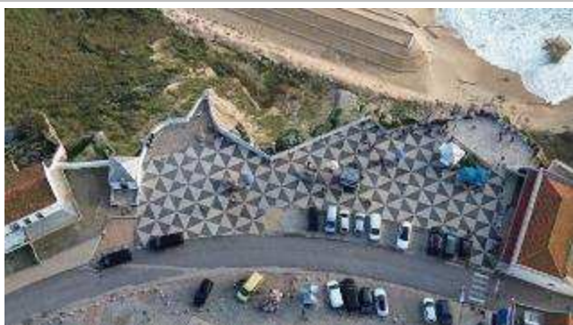
Sítio da Nazaré – Frente de obra foi suspensa a 10 de abril;
