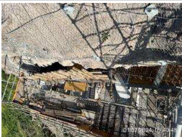
Frente de obra da plataforma Superior do Ascensor – Montagem da cofragem e armaduras para a viga superior;
