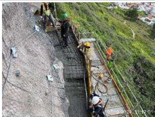
Frente de obra da plataforma Superior do Ascensor – 4 Betonagem da terceira fase da viga superior
