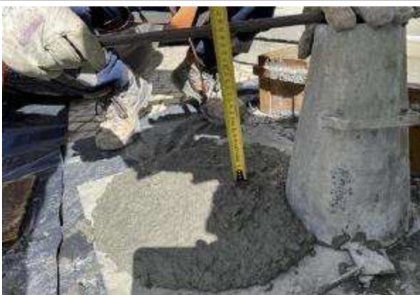
Frente de obra da plataforma Superior do Ascensor – Ensaio de Slump - 27/02/2024 - GR P518/0085692
