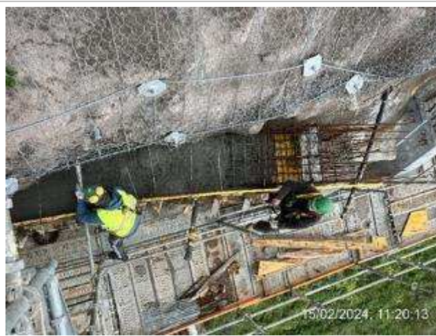
Frente de obra da plataforma Superior do Ascensor – Betonagem da segunda fase da viga superior
