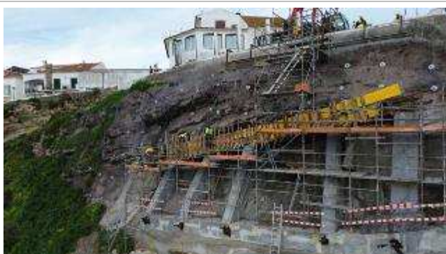
Frente de obra da plataforma Superior do Ascensor – Montagem da cofragem e armaduras para a viga superior;
