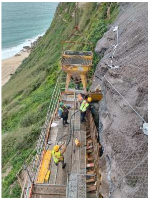
Foto 3 – Betonagem de Viga Superior de Betão Armado
