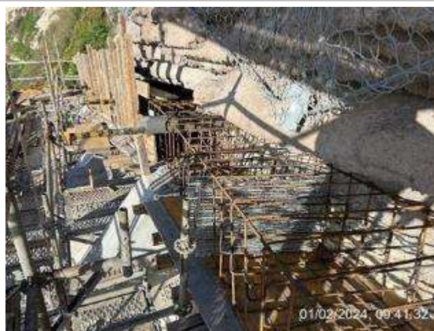
Frente de obra da plataforma Superior do Ascensor – Montagem da cofragem e armaduras para a viga superior;
