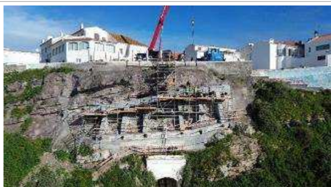
Frente de obra da plataforma Superior do Ascensor – Descofragem da viga superior e maciços;
