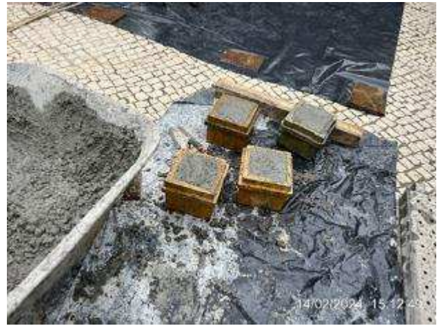
Frente de obra da plataforma Superior do Ascensor – 4 Provetes para ensaio à compressão - 14/02/2024 - GR P518/0085402;
