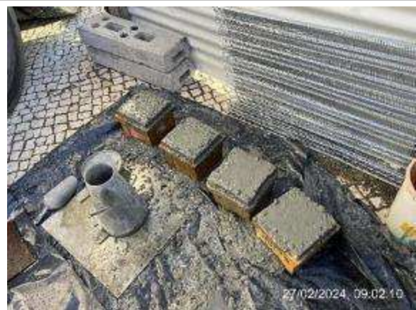
Frente de obra da plataforma Superior do Ascensor –4 4 Provetes para ensaio à compressão - 27/02/2024 - GR P518/0085692
