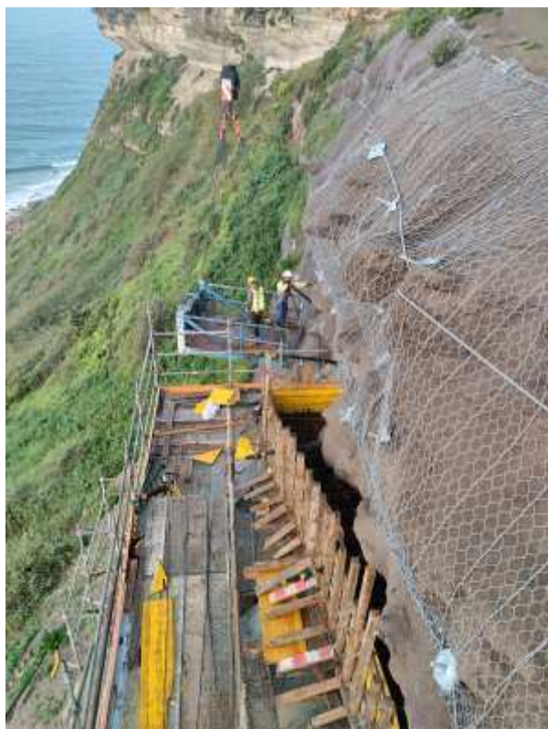
Foto 2 – Vista Geral da Frente de Obra (Viga Superior)
