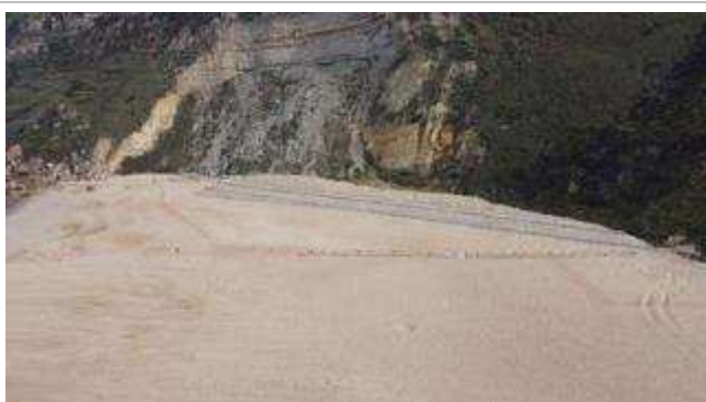
Frente de obra da Duna – Receção Provisória no dia 27 de Julho de 2023;
