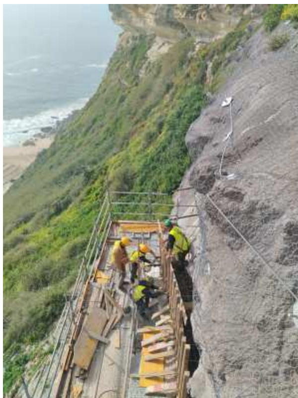
Foto 1 – Trabalhos de Cofragem da Viga de Betão Superior
