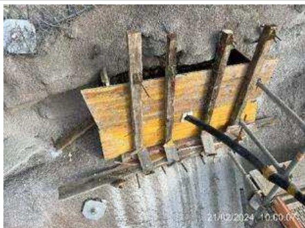
Frente de obra da plataforma Superior do Ascensor – Montagem da cofragem e armaduras para o maciço A1.2;
