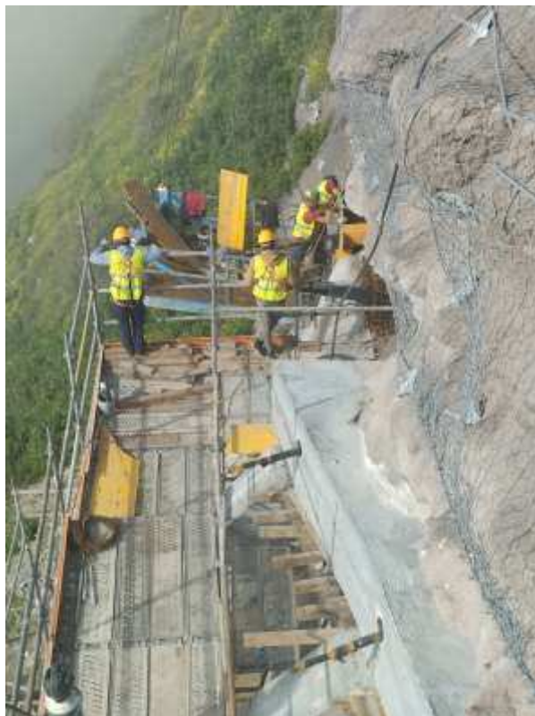
Foto 5 – Trabalhos Cofragem de Maciços de Ancoragens
