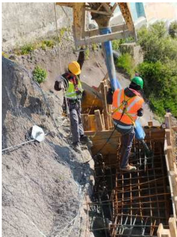
Foto 6 – Trabalhos de Conclusão de Betonagem de Viga de Betão Armado Superior
