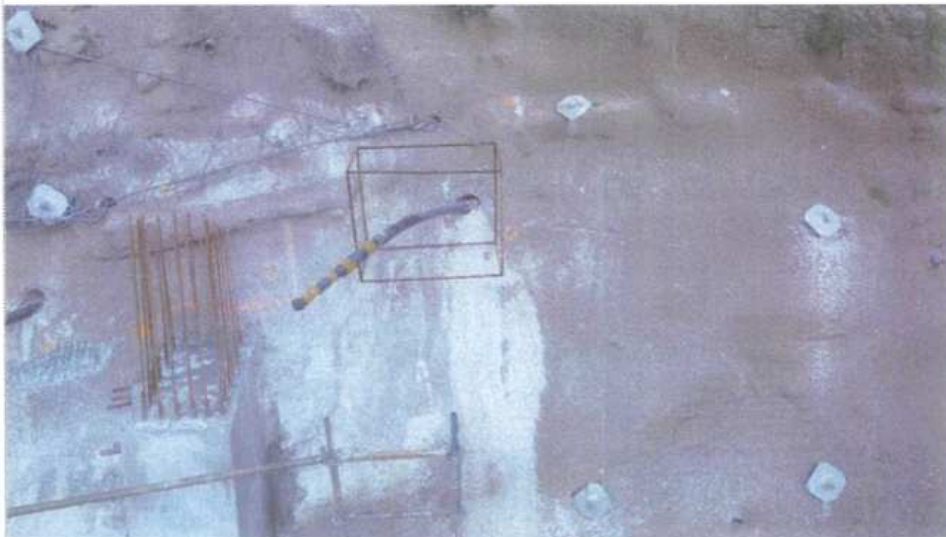
Figura 4: Proposta de maciço na ancoragem A1.8;
