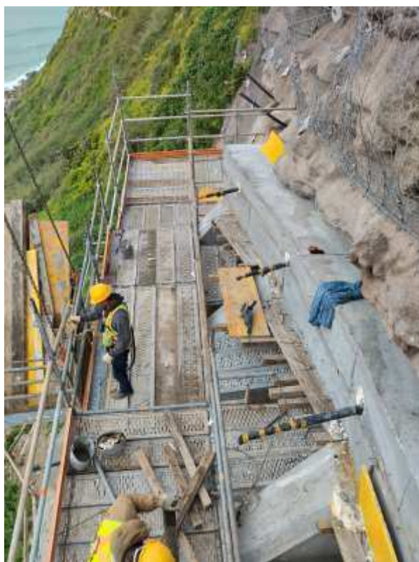
Foto 4 – Trabalhos de Descofragem (Viga Superior)
