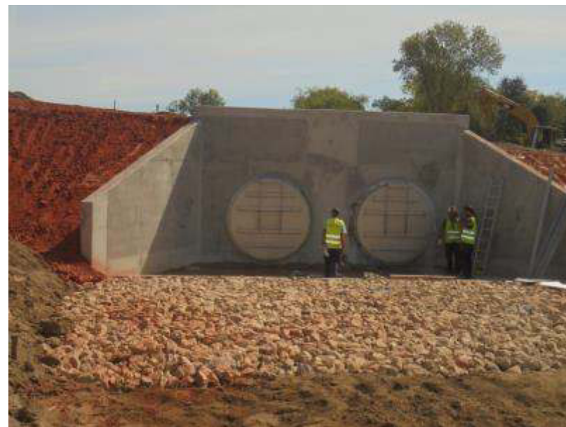
Montagem de válvulas de mural e de maré na Vala Sul
