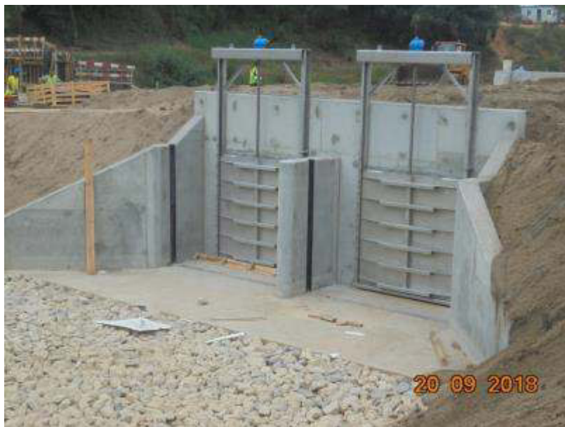
Montagem de válvulas de mural e de maré na Vala Sul
