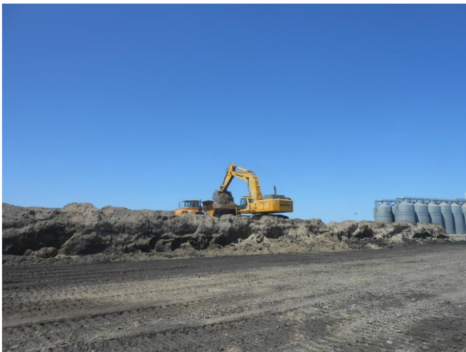
Colocação de areia no dumper com auxílio da giratória
