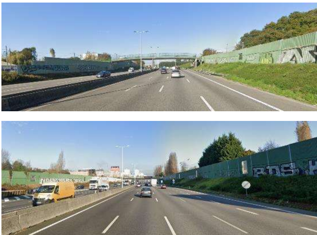
Fig. 4 - Exemplos de barreiras acústicas instaladas na A3
