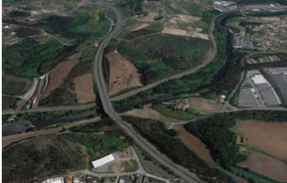
Viaduto do rio de ave ao pk 23+000
