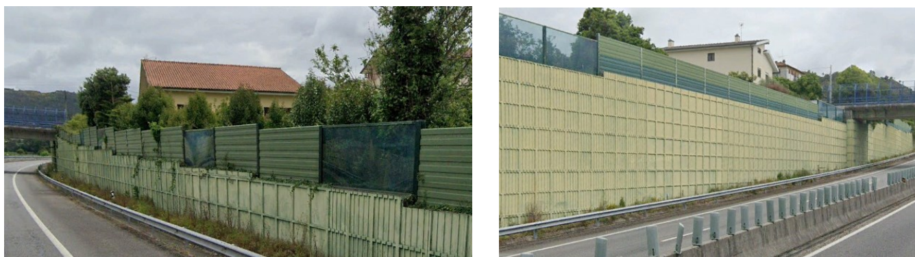
Figura 1 – Exemplos de barreiras acústicas de diversos tipos instaladas na A27
