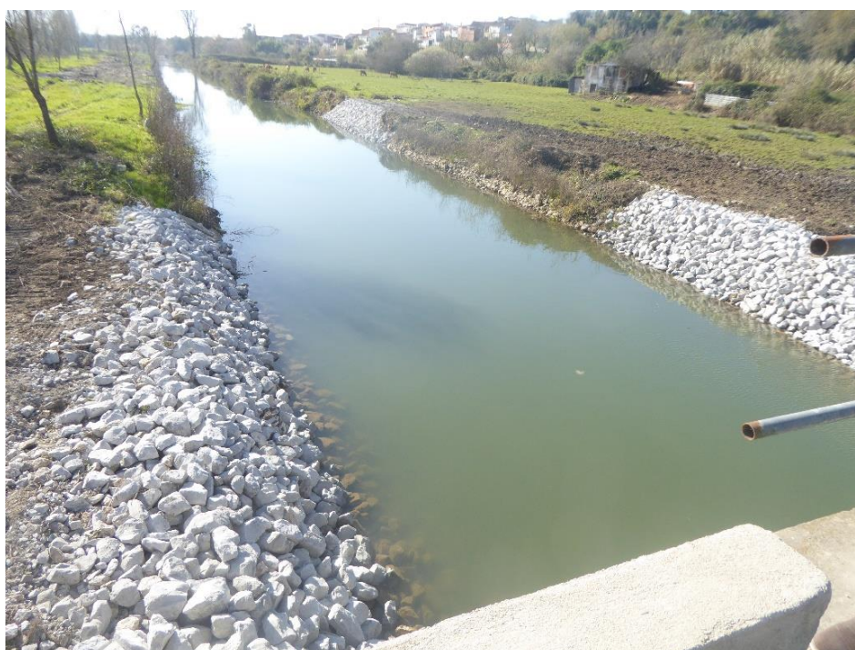
Reabilitação do leito do LPD junto à travessia de Quimbres, com desassoreamento e revestimento de enrocamento
