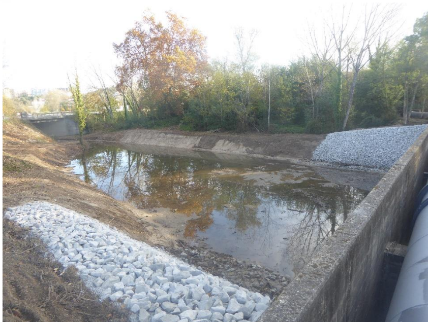
Desassoreamento e proteção de taludes do Valeiro do Campeão – Vista para jusante da ponte-canal
