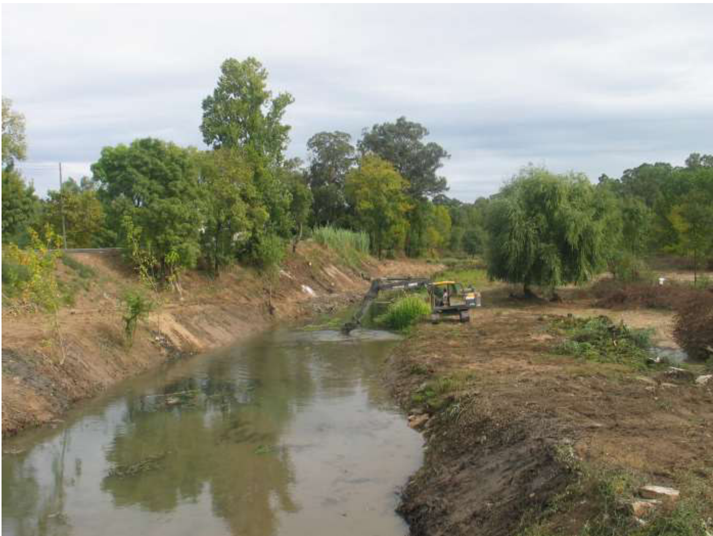
Desassoreamento do leito menor no troço entre as travessias de S. João do Campo e Cioga Vista a partir do pontão da Cioga
