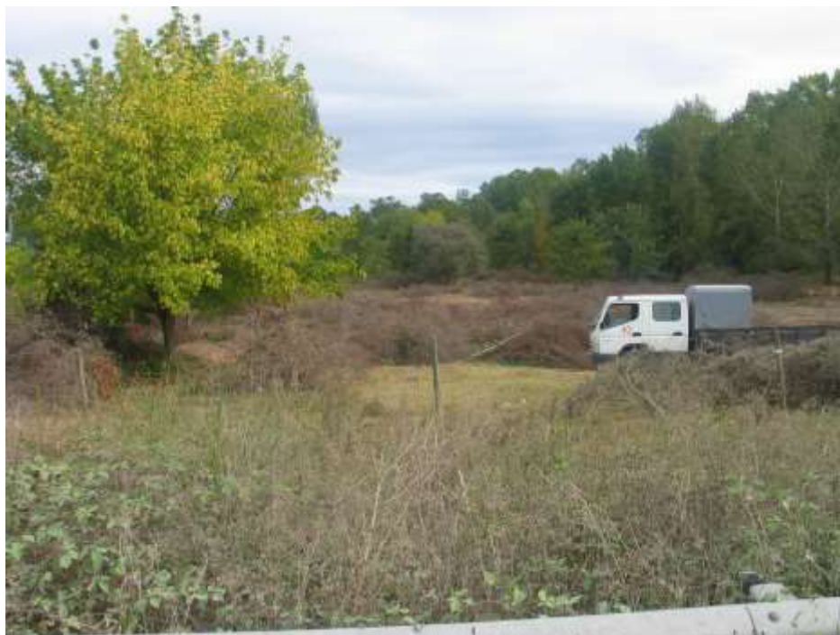
Limpeza de vegetação no leito maior entre a travessia da Cioga e a travessia de Quimbres
