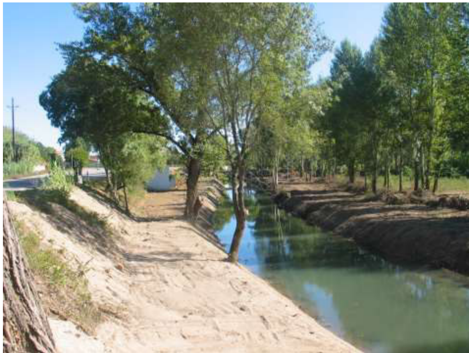
Limpeza de vegetação e desassoreamento do leito menor concluídos a jusante da travessia de S. João do Campo
