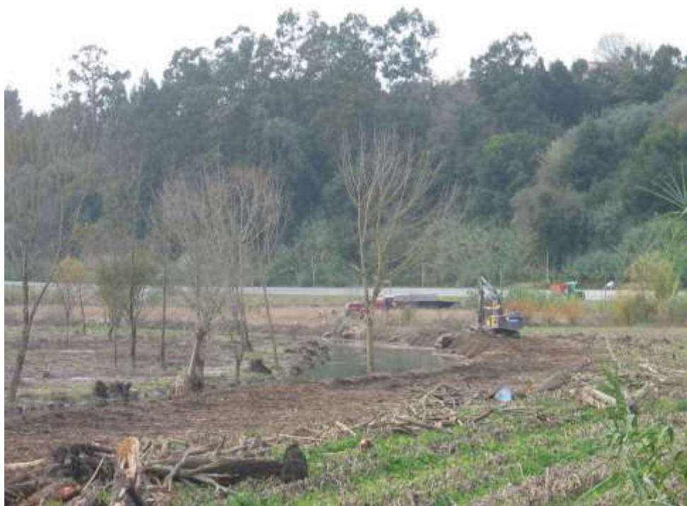
Desassoreamento do leito menor entre a travessia de S. Silvestre e a travessia de Quimbres
