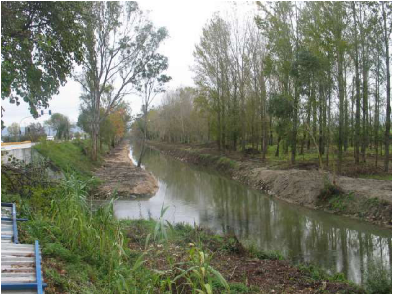
Aterro da plataforma da margem direita do leito maior e desassoreamento do leito menor concluídos entre o viaduto da A1 e a travessia de S. João do Campo. Vista da travessia para o troço final junto à confluência da ribeira de Ançã
