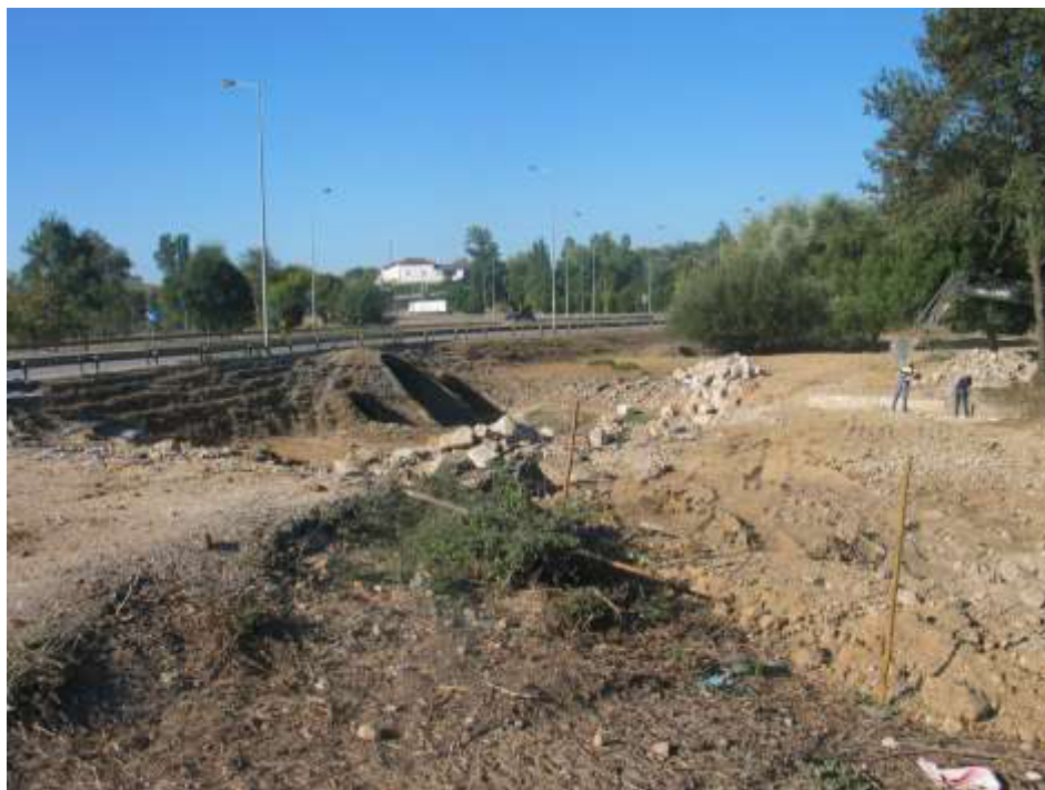
Demolição do pontão da Cidreira
