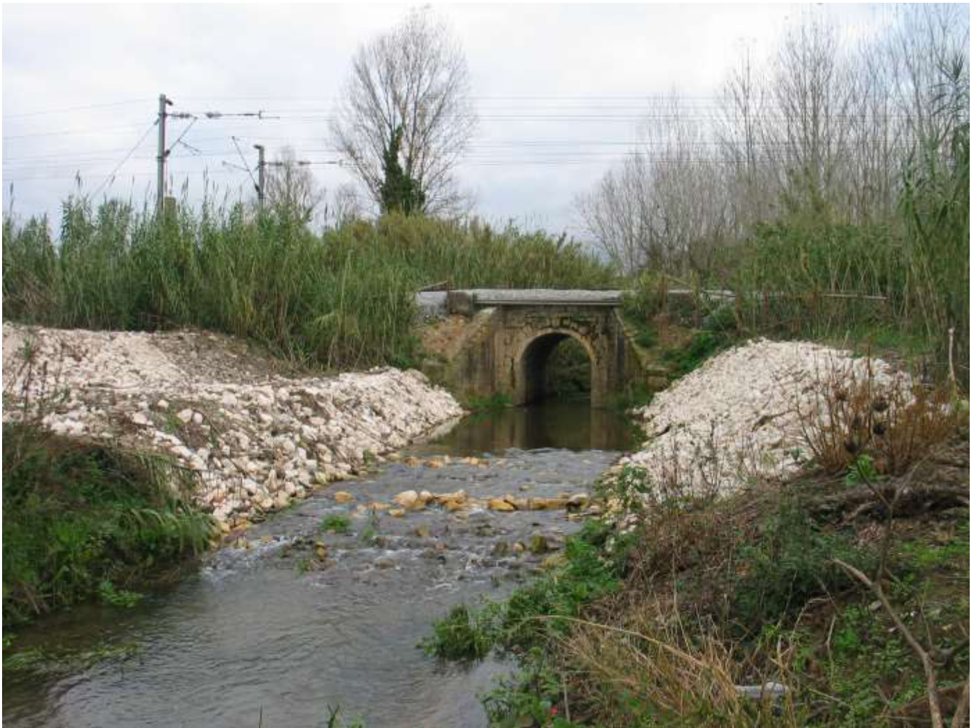
Execução do revestimento de protecção dos taludes do leito menor a jusante do aqueduto da ribeira de Eiras, concluída
