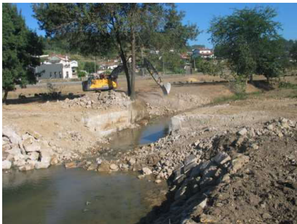
Demolição do pontão da Cidreira – Vista para montante
