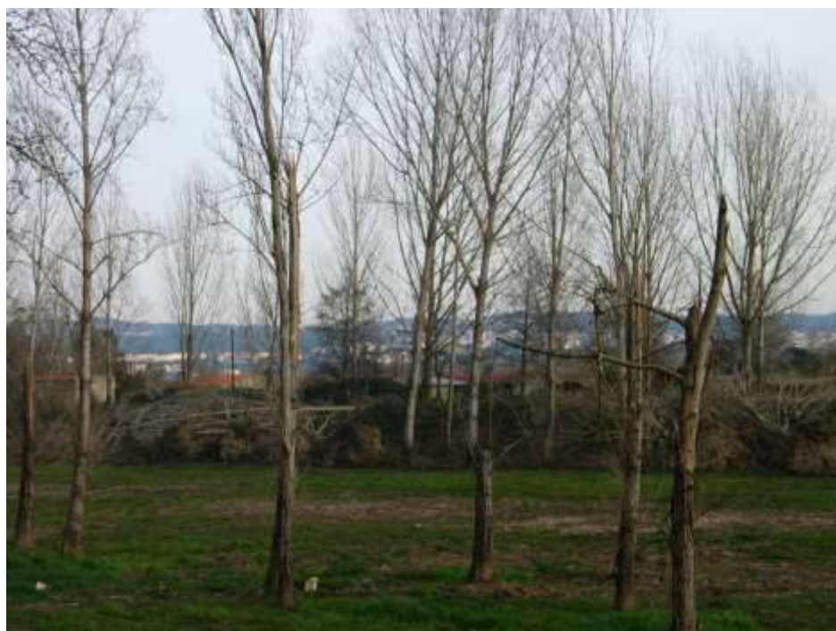
Aspetto da destruição provocada pelo furacão ocorrido em 13 de Outubro Árvores caídas no talude e no leito do rio em zona já anteriormente intervencionada entre as travessias da Cioga e S. Silvestre
