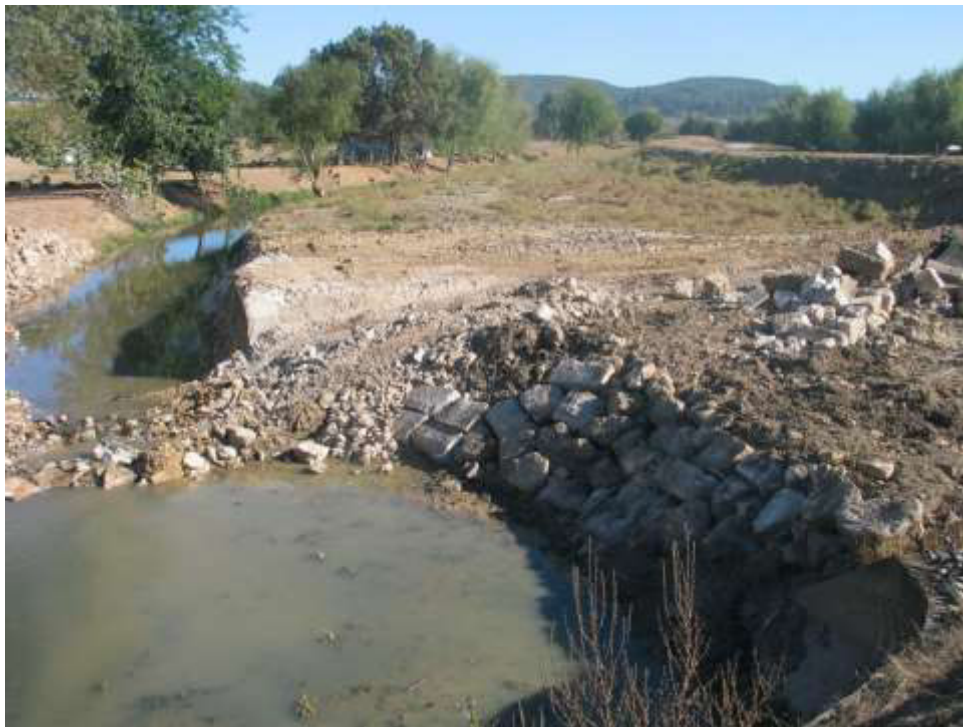
Revestimento de protecção do talude da margem esquerda a montante da passagem hidráulica da travessia da Cidreira
