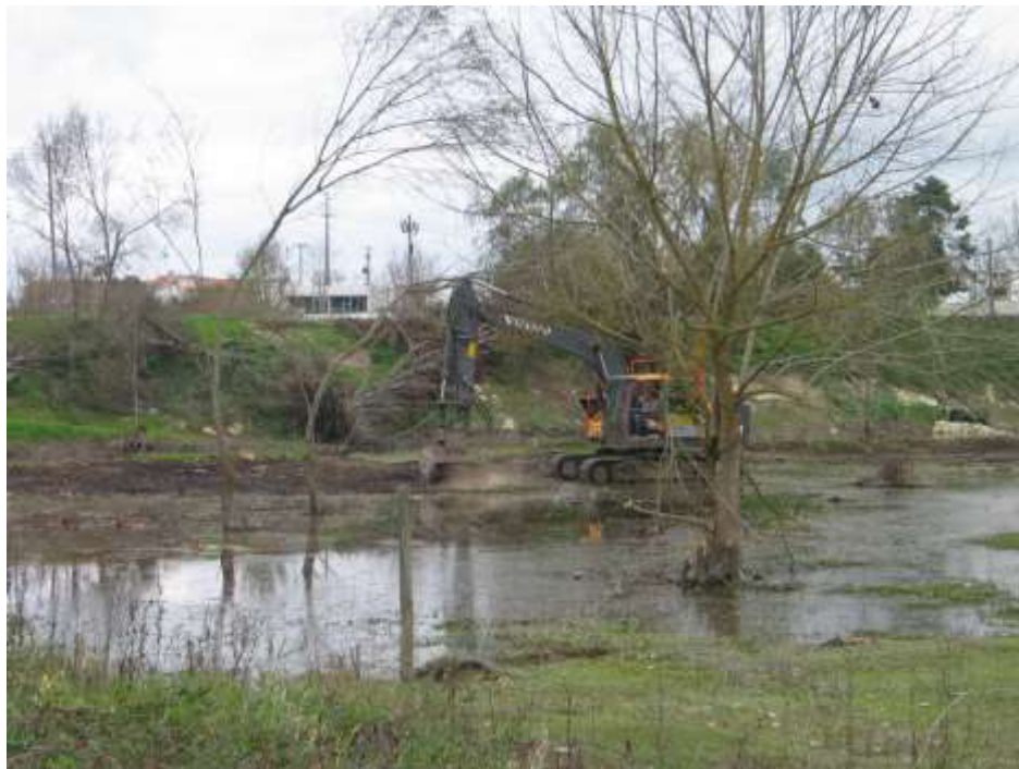
Aspetto da destruição provocada pelo furacão ocorrido em 13 de Outubro Árvores caídas no talude e no leito do rio em zona já anteriormente intervencionada entre as travessias da Cioga e S. Silvestre
