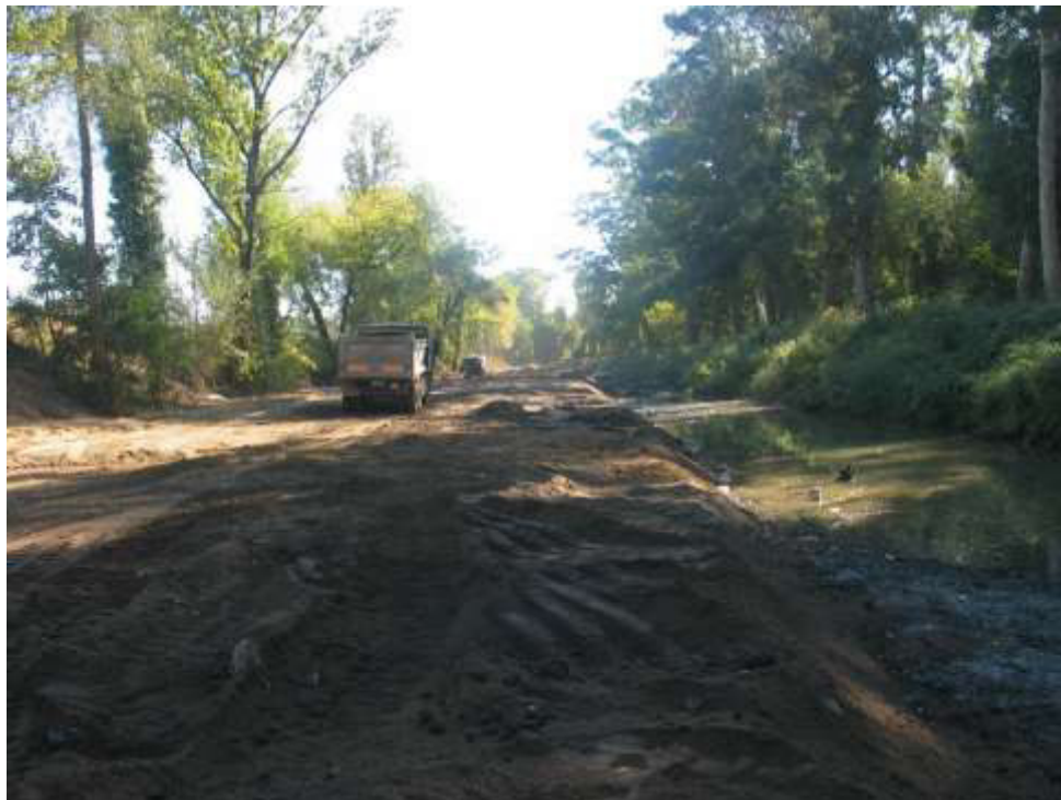
Execução do aterro da plataforma da margem direita do leito maior entre a A1 e a travessia de S. João do Campo
