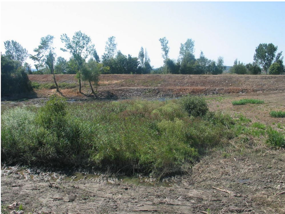
Limpeza de vegetação dos diques e leito maior e desassoreamento do leito menor na zona de confluência com o Leito Central do Mondego
