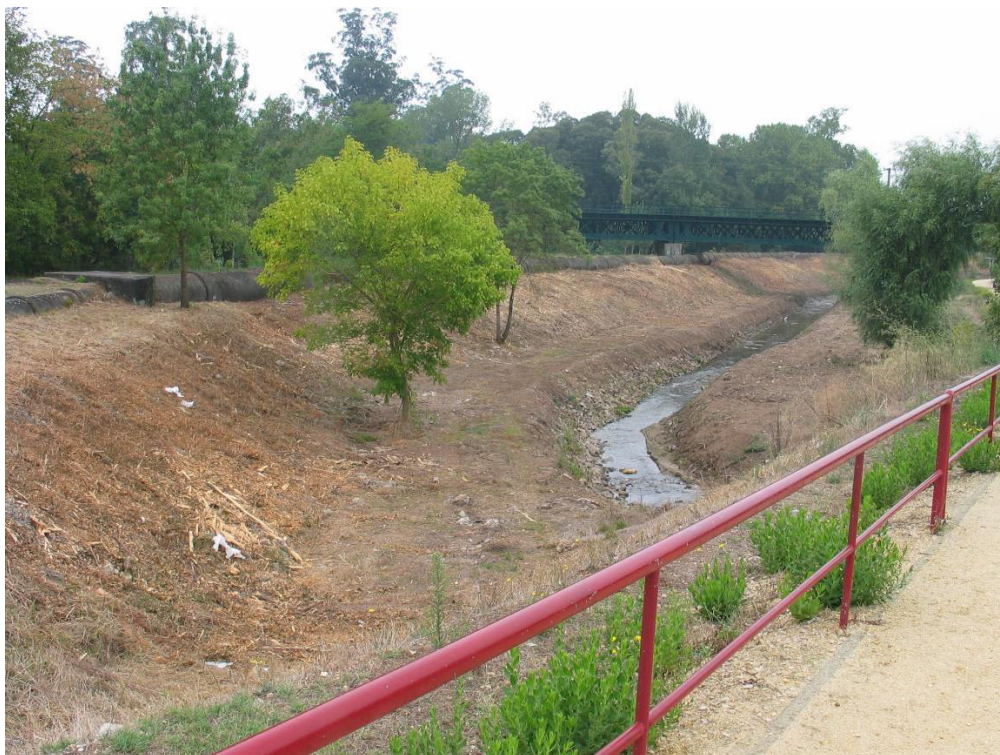
Desassoreamento do leito menor e limpeza de vegetação dos diques e golenas no troço inicial do Leito Periférico Direito concluídos
