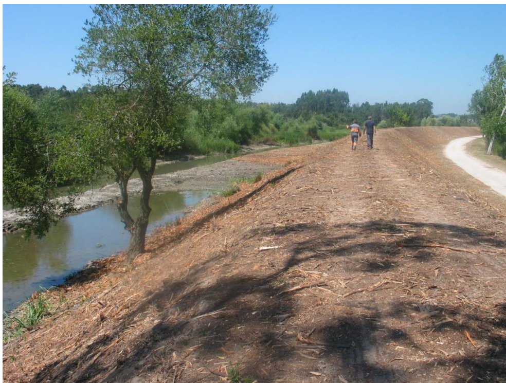
Limpeza de vegetação e desassoreamento concluídos entre as travessias das Meãs e de Lavariz – Vista para montante
