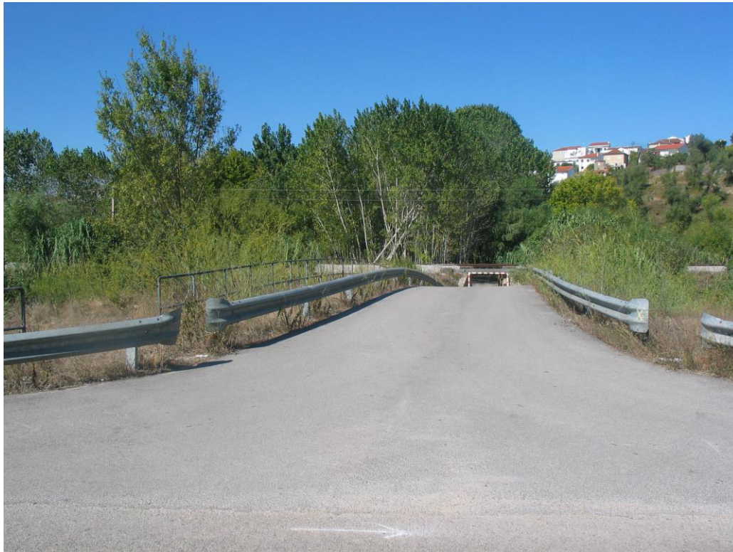
Montagem de rails de proteção concluída na travessia da Pedrulha
