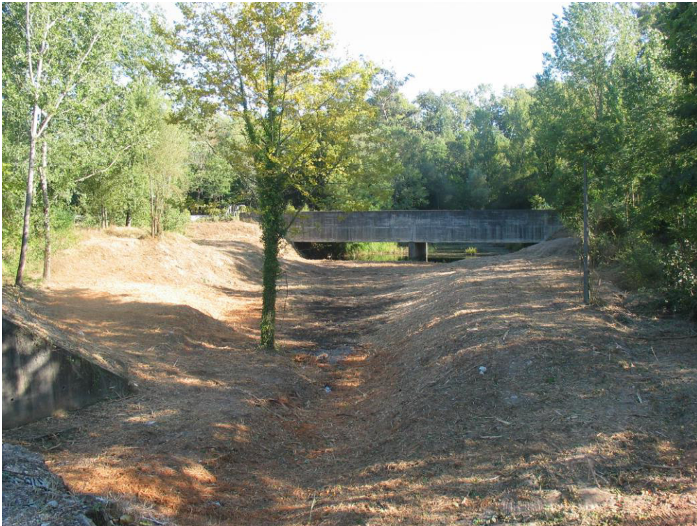
Limpeza de vegetação do Valeiro do Campeão, a jusante da ponte canal concluída
