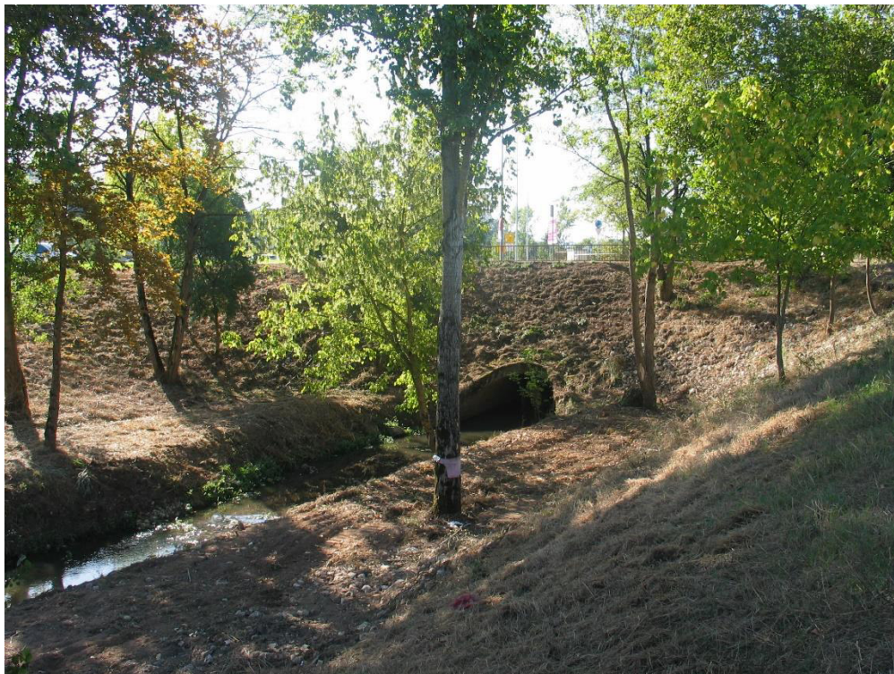
Desassoreamento do leito menor e limpeza de vegetação dos diques e golenas concluídos a jusante da passagem hidráulica do Choupal de Coimbra
