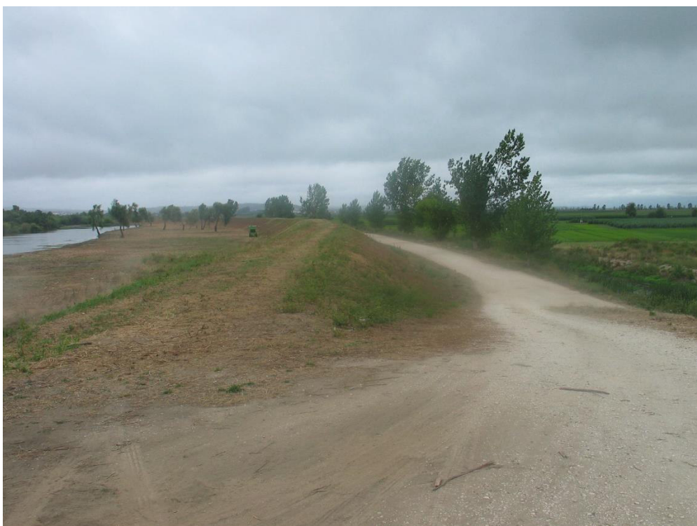
Limpeza de vegetação na zona final do Poço da Cal concluída
