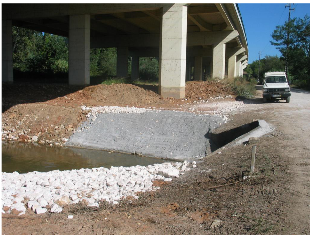
Reabilitação da passagem hidráulica do Rio Velho junto ao viaduto da A1 concluída Vista da estrutura de montante
