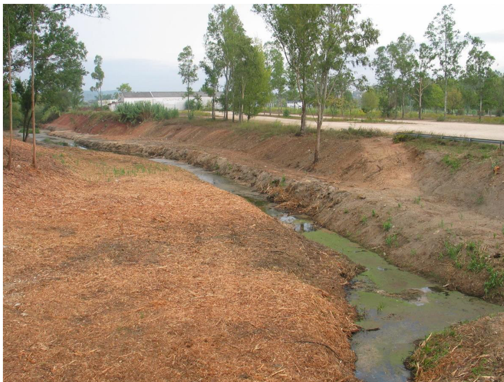
Limpeza de vegetação e desassoreamento do leito menor do troço inicial do Rio Velho a jusante da passagem hidráulica de acesso ao Choupal de Coimbra concluídos
