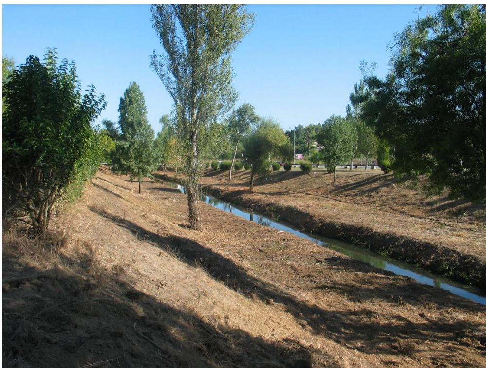
Desassoreamento do leito menor e limpeza de vegetação dos diques e golenas concluídos entre a passagem hidráulica do Choupal de Coimbra e a EN 111
