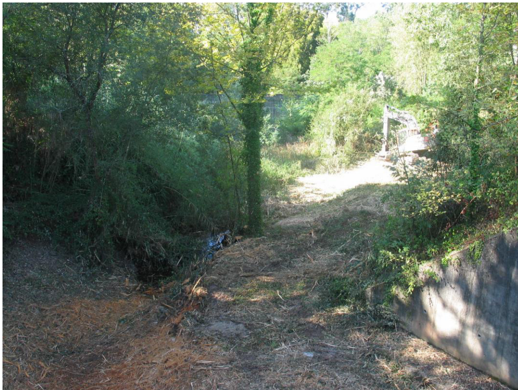
Início da limpeza de vegetação do Valeiro do Campeão, a jusante da ponte canal
