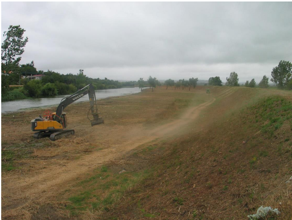
Limpeza de vegetação do dique e do leito maior na zona do Poço da Cal Vista para montante
