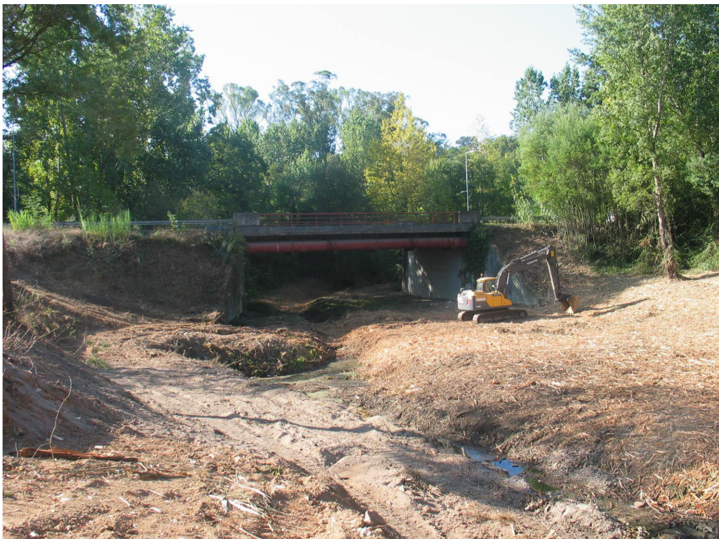
Início da limpeza de vegetação e desassoreamento do leito menor do Rio Velho a jusante da passagem hidráulica de acesso ao Choupal de Coimbra
