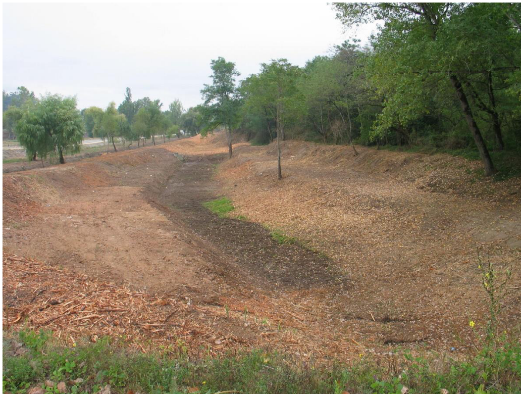
Limpeza de vegetação e desassoreamento do leito menor do troço inicial do Rio Velho a montante da passagem hidráulica de acesso ao Choupal de Coimbra concluídos
