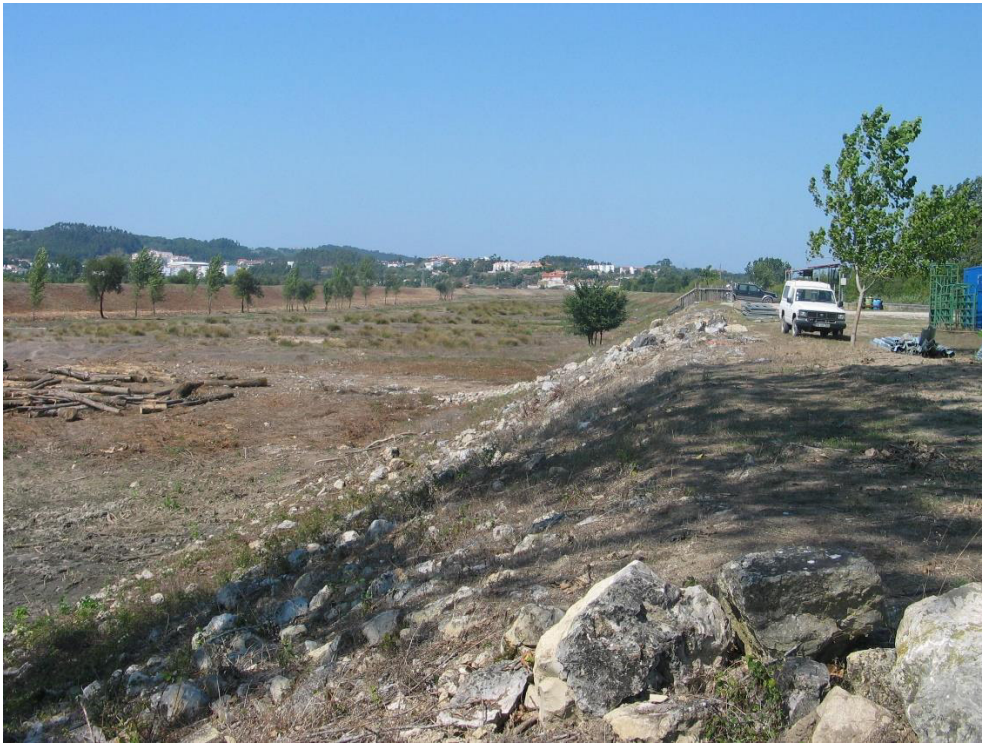
Limpeza de vegetação nos diques e leito maior no troço final do Leito Periférico Direito
