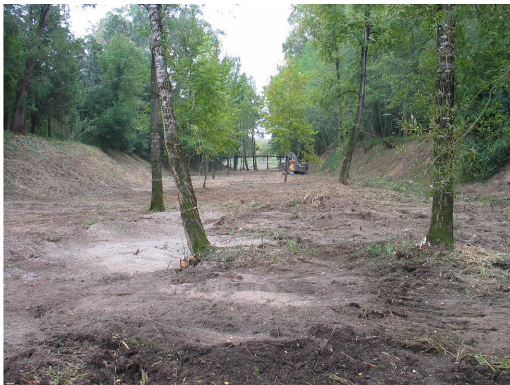
Limpeza de vegetação no Valeiro do Campeão entre a ponte canal e o descarregador fusível de cheias do Mondego
