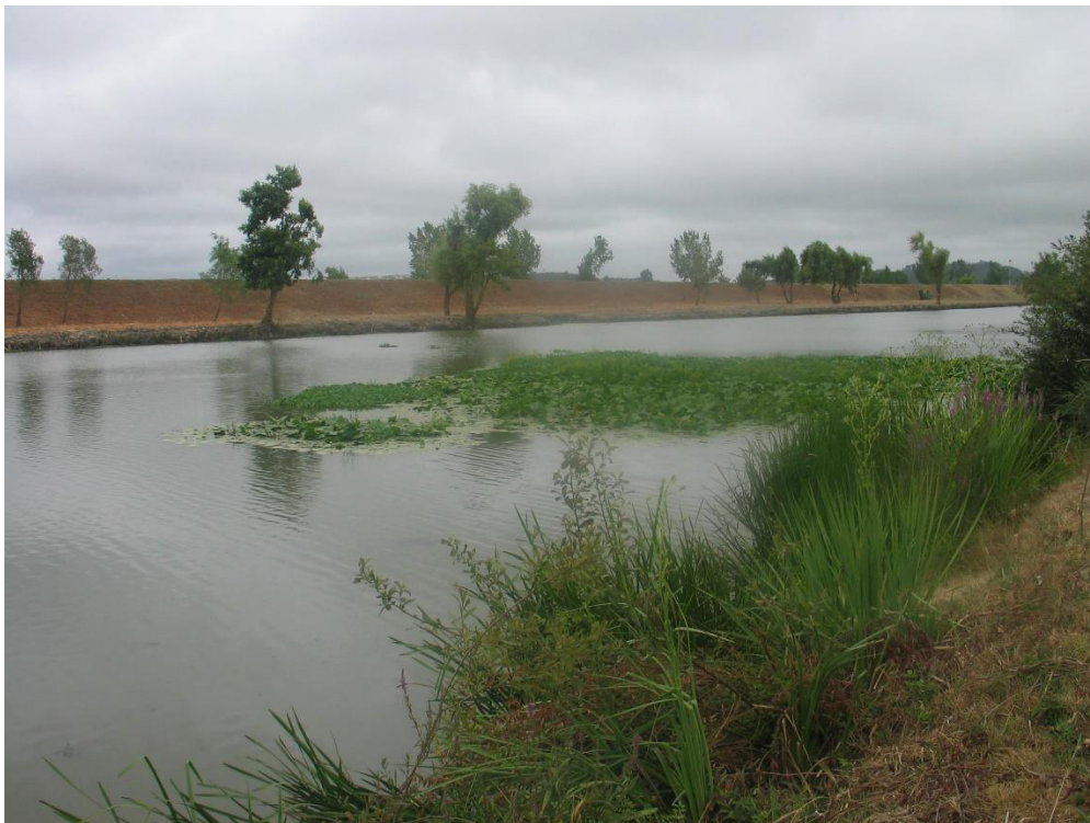
Limpeza de vegetação do dique na zona de início do Poço da Cal concluída
