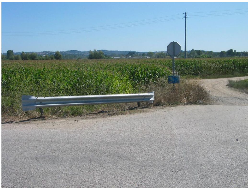
Montagem de rail de proteção concluída na estrada de manutenção junto à travessia da Adémia
