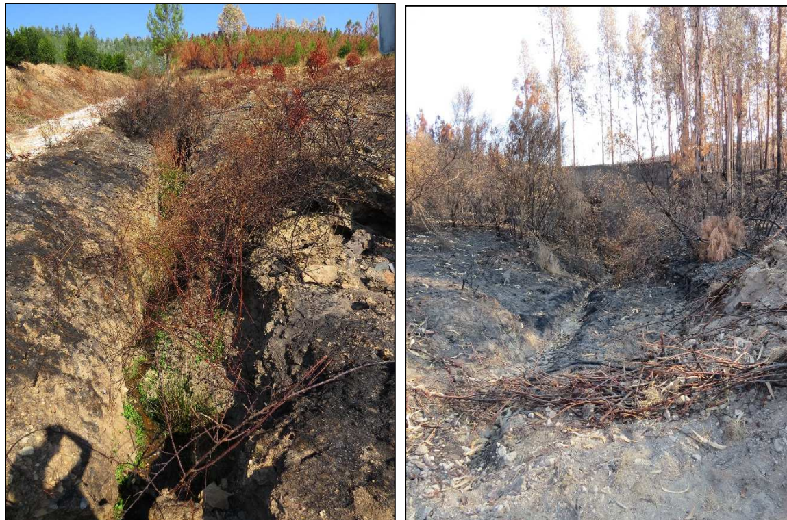
Figura 140 e Figura 141 - Corte e remoção de material vegetal ardido (medida A)
