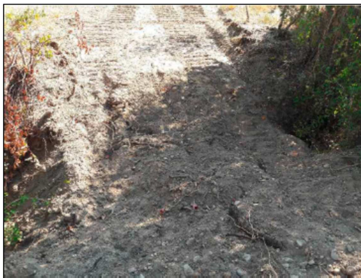
Figura 2 – Remoção de sedimentos e outro material nos leitos
