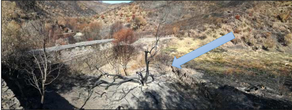
Figura 93 - Montante do Açude 71- Remoção de sedimentos e outro material nos leitos
