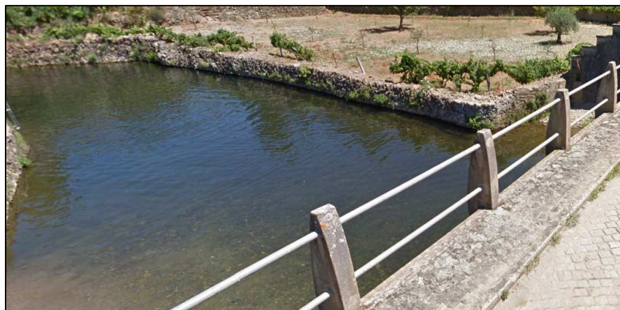
Figura 45- Remoção de sedimentos e outro material no leito
