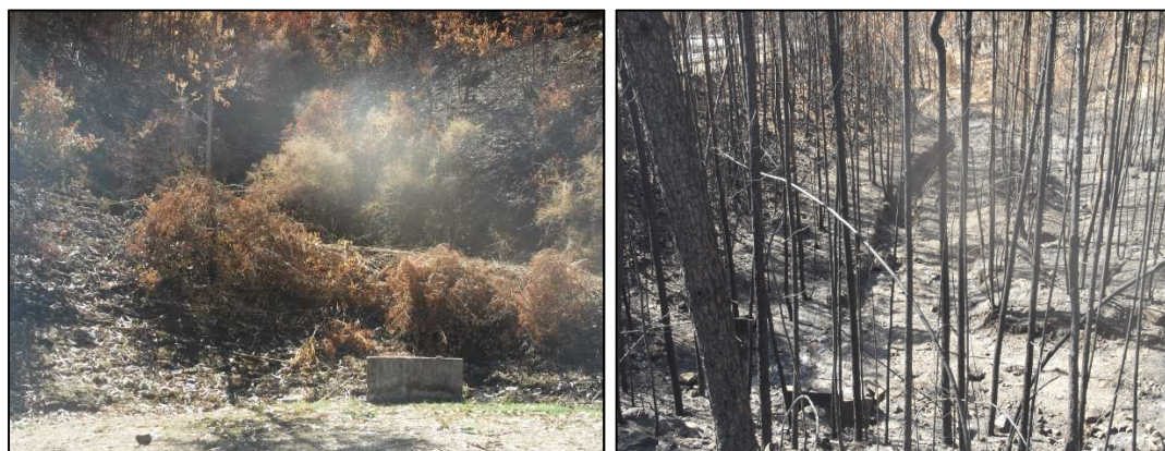
Figura 31 e Figura 32 - Recuperação da secção de vazão de passagem hidráulica (à esquerda) e consolidação e recuperação de taludes e margens (à direita).
