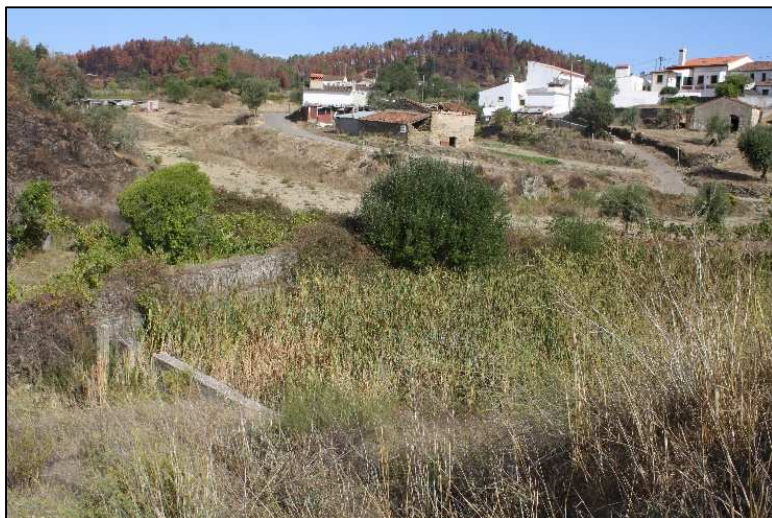
Figura 59 - Reabilitação de açudes existentes, com objetivos de correção torrencial
