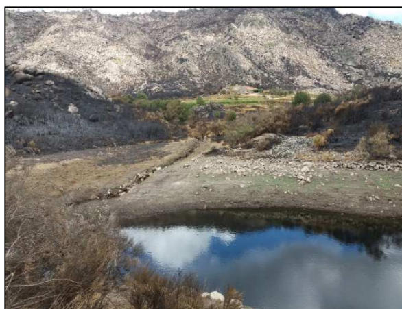
Figura 41 e Figura 42- Barragens assoreadas com área envolvente ardida e remoção de vegetação queimada dentro do NPA.
