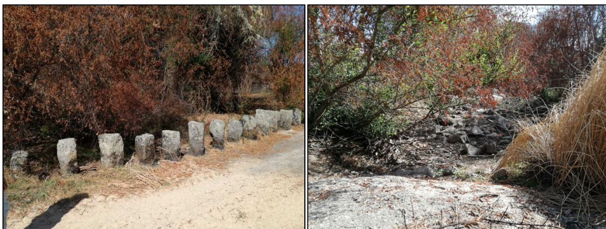
Figura 91 - Ribeira de Figueiró – Corte e remoção de material vegetal arbóreo e arbustivo ardido
