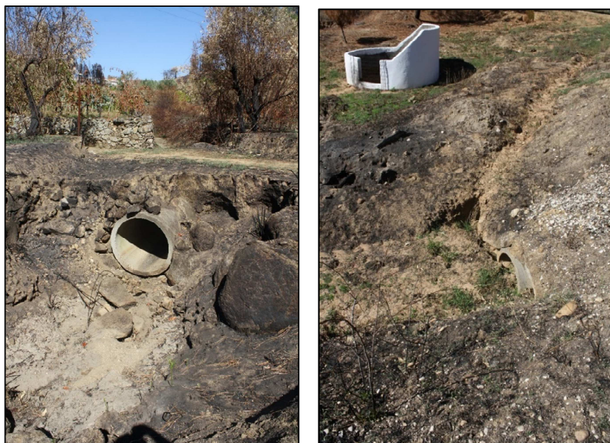
Figura 54 e Figura 55- Recuperação da secção de vazão de passagem hidráulica (à esquerda) e consolidação e recuperação de taludes e margens (à direita).
