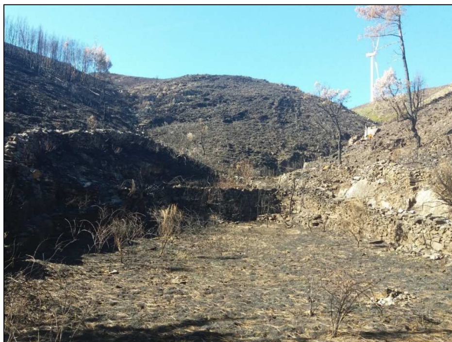
Figura 116 – Recuperação da seção de vazão de passagens hidráulicas
