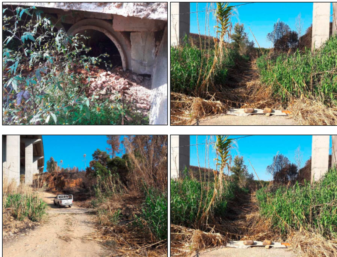
Figura 3 e Figura 4 e Figura 5 e Figura 6 – Recuperação da secção de vazão das passagens hidráulicas e pontões-Destruição e reconstrução de pontão sob a A23
