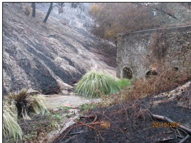
Figura 13 e Figura 14 – Acumulação de sedimentos e material vegetal ardido junto a passagens hidráulicas.
