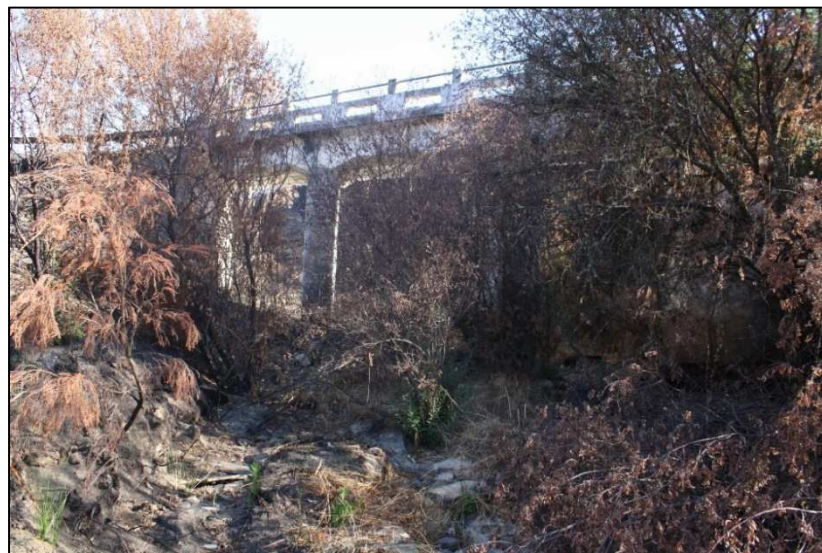
Figura 56 - Recuperação da secção de vazão de pontão
