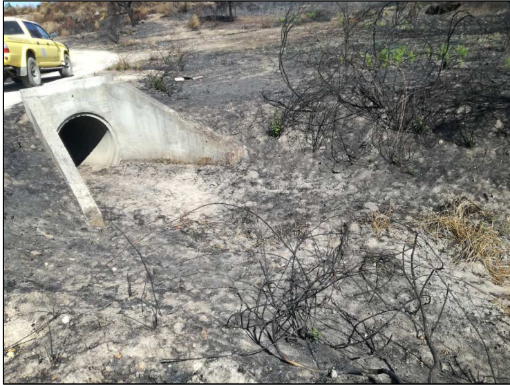
Figura 95 - Recuperação da secção de vazão de passagem hidráulica - tipo 1
