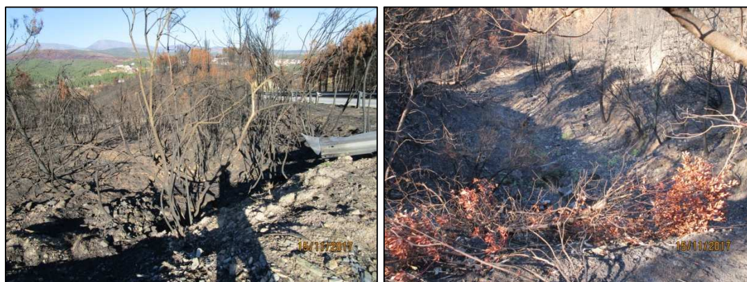
Figura 46 e Figura 47- Recuperação da secção de vazão de passagem hidráulica (à esquerda) e consolidação e recuperação de taludes e margens (à direita).
