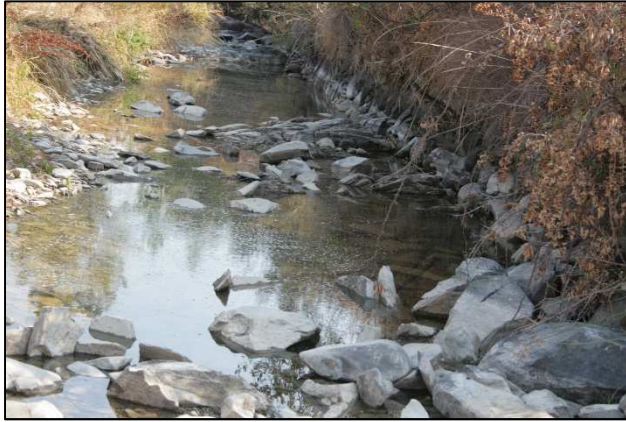
Figura 137, Figura 138 e Figura 139 - Construção e/ou recuperação de bacias de retenção (diqe)
