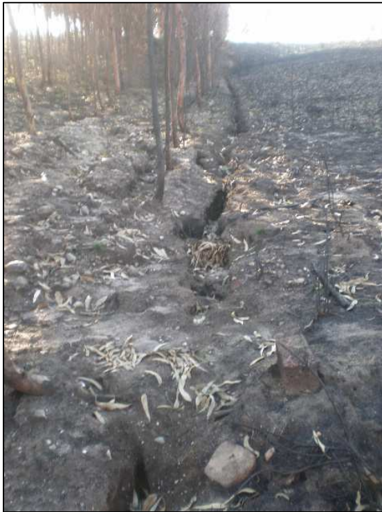
Figura 112 - Construção de pequenas obras de correção torrencial (à direita).
