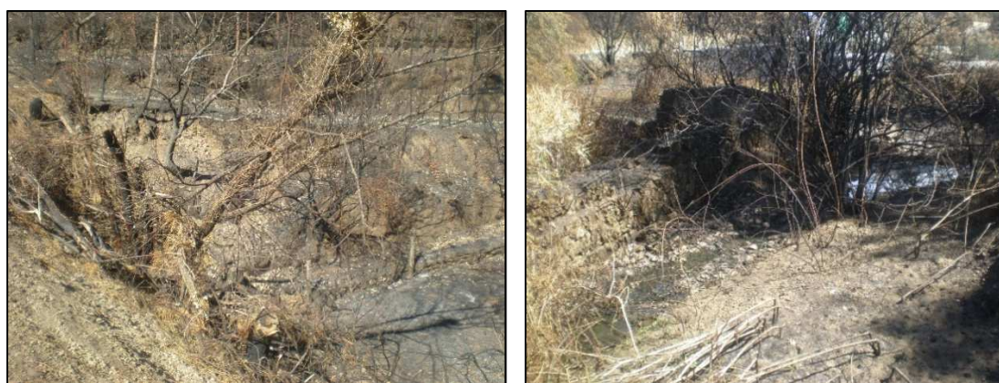
Figura 102 e Figura 103 – Recuperação da secção de vazão de passagem hidráulica (à esquerda) e consolidação e recuperação de taludes e margens (à direita).
