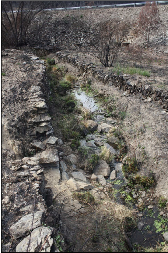
Figura 57 - Consolidação e recuperação de taludes e margens.
