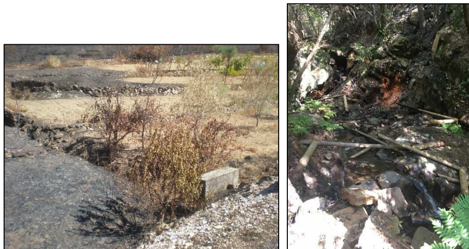
Figura 104 e Figura 105 – Reabilitação da galeria ripícola (à esquerda) e reabilitação de açudes existentes, com objetivos de correção torrencial (à direita).
