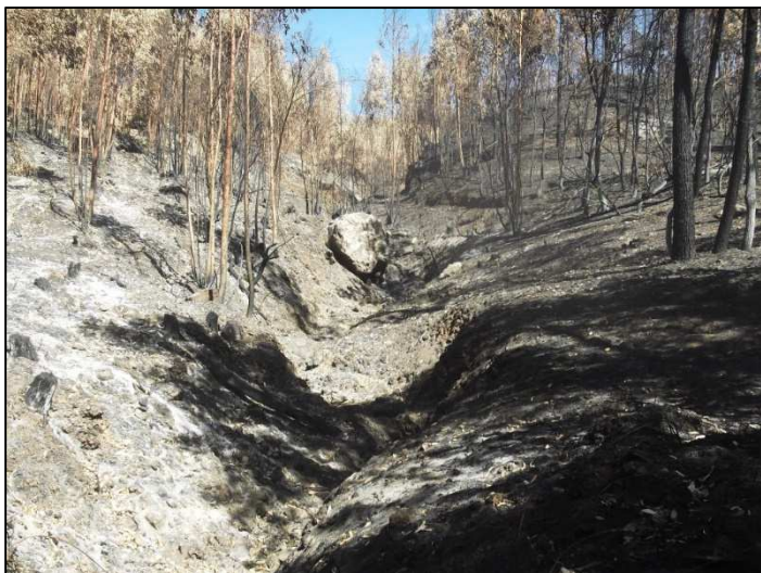
Figura 35 - Construção de pequenas obras de correção torrencial.
