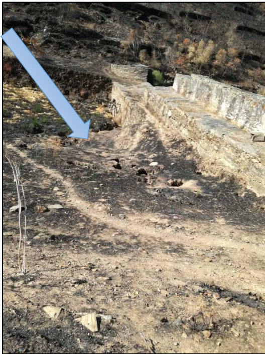
Figura 94 - Montante do Açude 70- Remoção de sedimentos e outro material nos leitos
