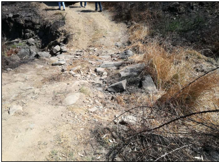
Figura 96 - Recuperação da secção de vazão de passagem hidráulica - tipo 2
