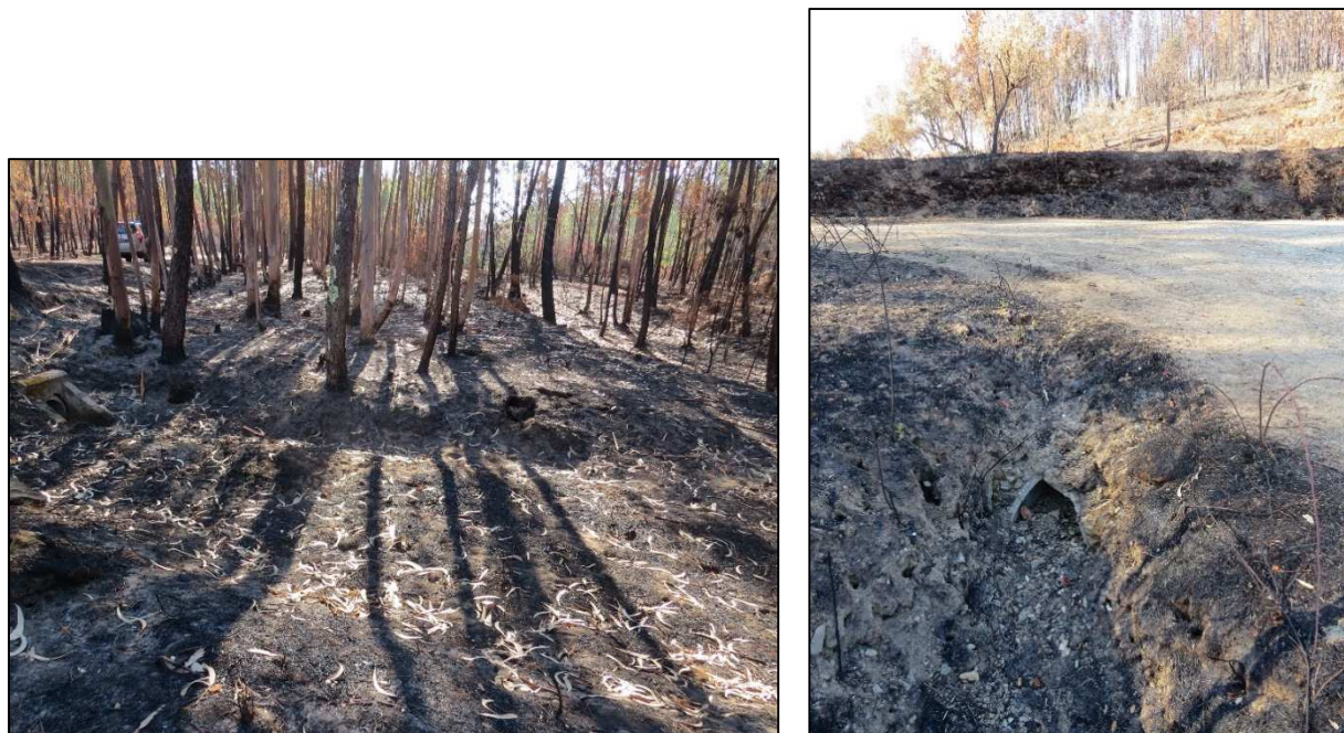
Figura 142 e Figura 143 – Recuperação da seção de vazão das PH e pontões (medida C)
