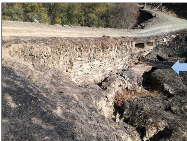
Figura 92 - Montante do Açude 18 - Remoção de sedimentos e outro material nos leitos
