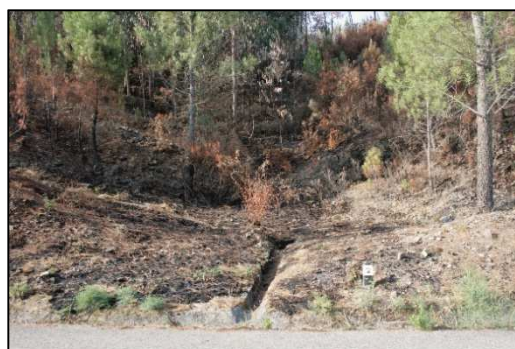
Figura 122, Figura 123, Figura 124, Figura 125, Figura 126 e Figura 127 - Recuperação da secção de vazão das passagens hidráulicas e pontões, com bacia de retenção
