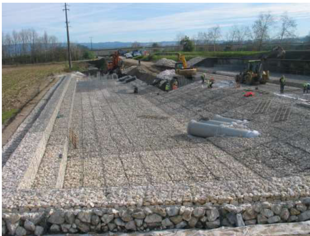
Estrutura de dissipação de energia do descarregador ECC 3 Evolução da execução dos gabiões na zona da vala de drenagem
