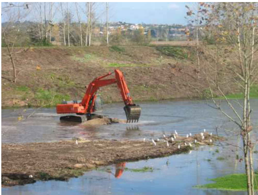
Pormenor do desassoreamento da ilha a montante da soleira do P 115
