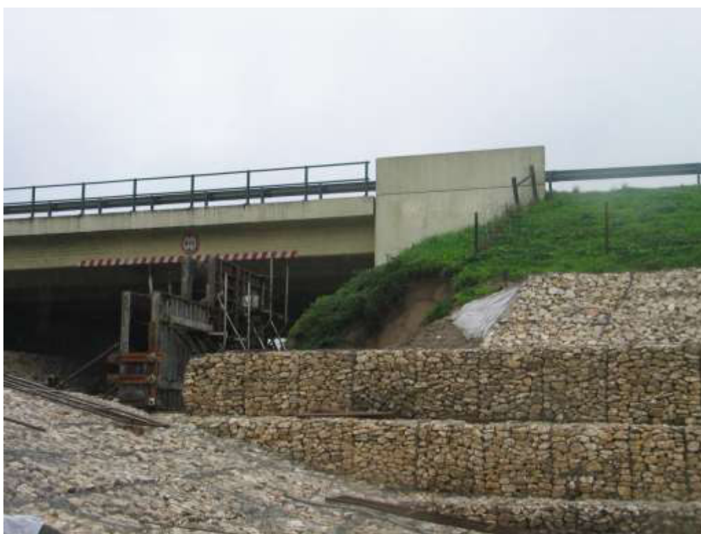
Estrutura de dissipação de energia do descarregador ECC 3 Montagem de cofragem da sapata do muro de suporte para posterior betonagem
