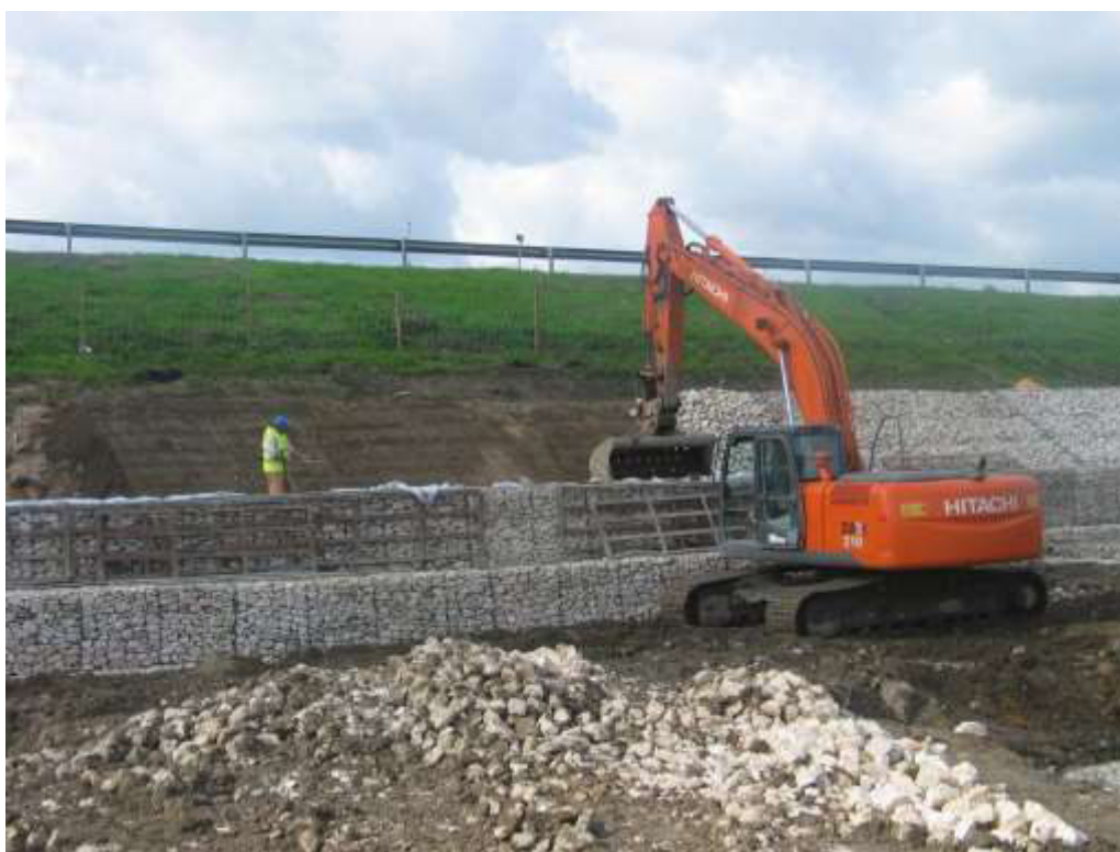
Estrutura de dissipação de energia do descarregador ECC 3 Execução do colchão Reno de proteção do talude da A1 em fase avançada
