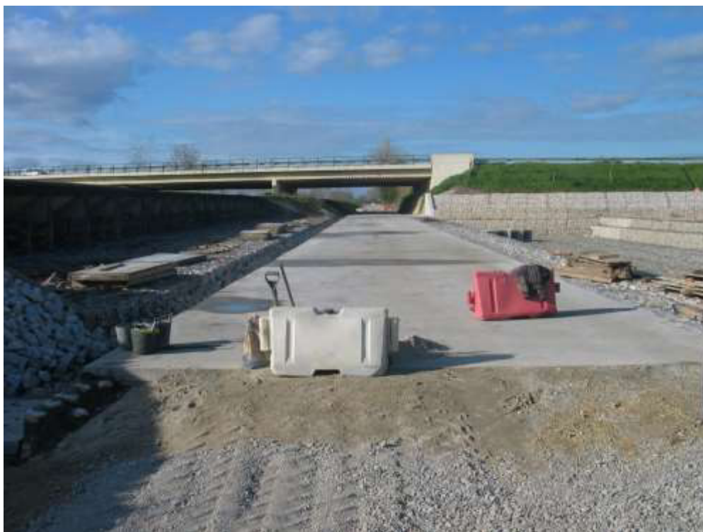
Estrutura de dissipação de energia do descarregador ECC 3 concluída à exceção dos pavimentos
