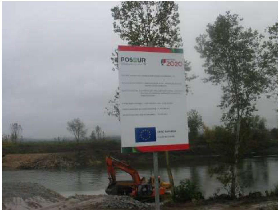
Reabilitação da soleira do perfil 115 do Leito Central do rio Mondego Placard de identificação de obra co-financiada pelo POSEUR
