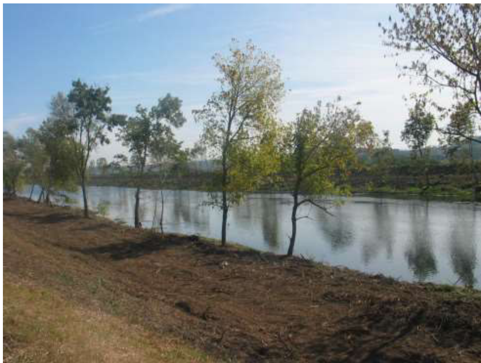
Limpeza de vegetação do dique, taludes e leito concluída
