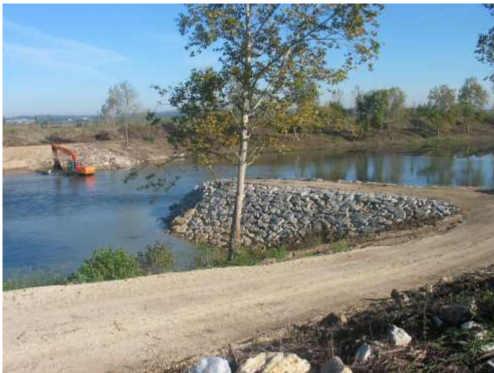
Reabilitação da soleira do perfil 115 do Leito Central do rio Mondego Esporão da margem esquerda reabilitado e regularização do leito na margem direita
