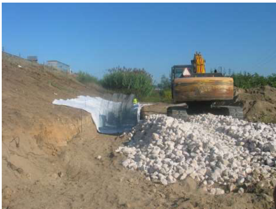
Estrutura de dissipação de energia do descarregador ECC 3 Início da proteção do talude da A1
