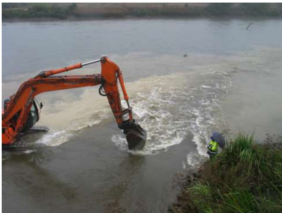
Consolidação da fundação a jusante da estação elevatória do Foja Trabalhos finais de enchimento da fundação e regularização do leito
