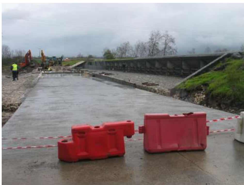
Estrutura de dissipação de energia do descarregador ECC 3 Zona da estrada parcialmente betonada
