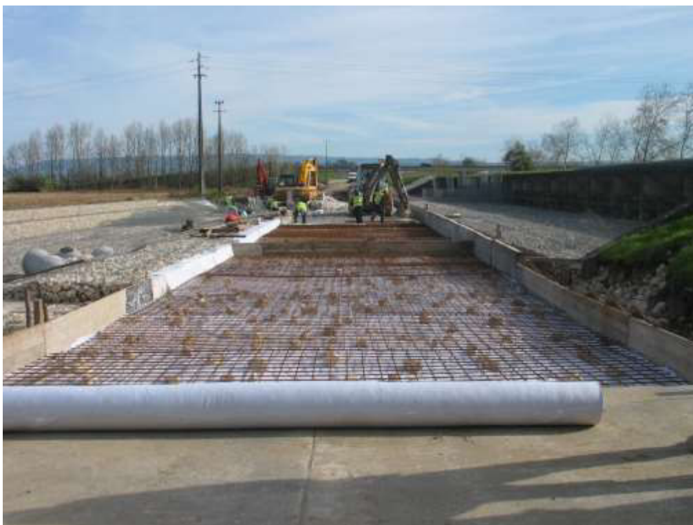
Estrutura de dissipação de energia do descarregador ECC 3 Montagem da armadura na zona da estrada para posterior betonagem
