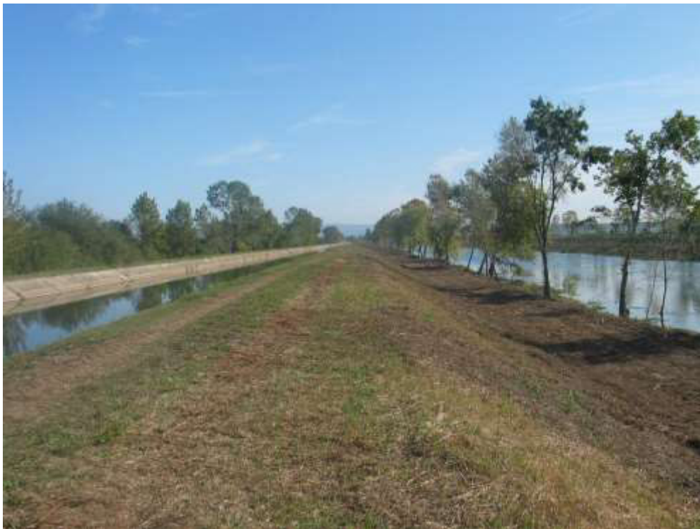
Limpeza de vegetação do dique e taludes na margem direita entre Taveiro e Arzila concluída
