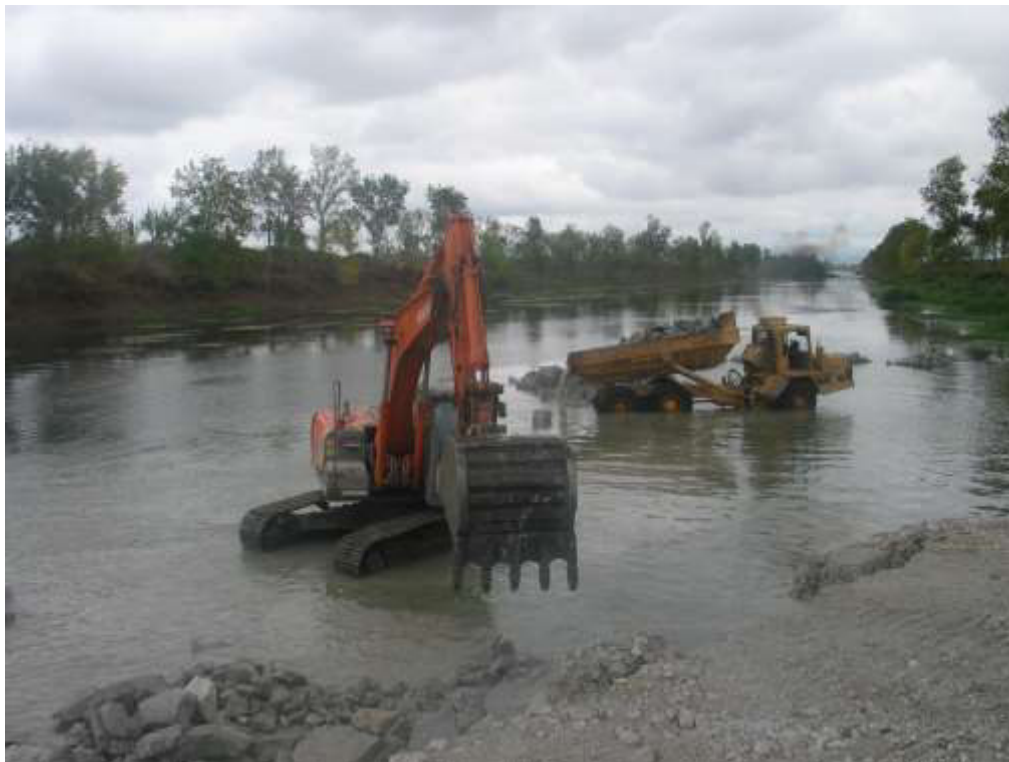
Reabilitação da soleira do perfil 115 do Leito Central do rio Mondego Revestimento do fundo do leito com enrocamento
