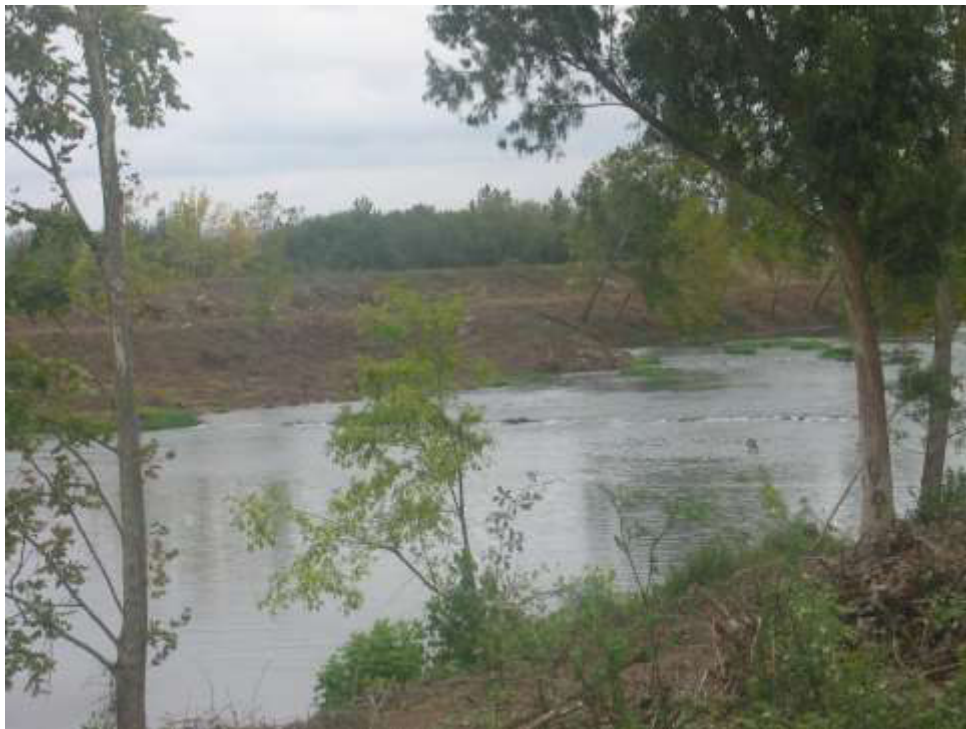
Limpeza de vegetação no coroamento e taludes do dique da margem direita, na zona entre Arzila e Pereira
