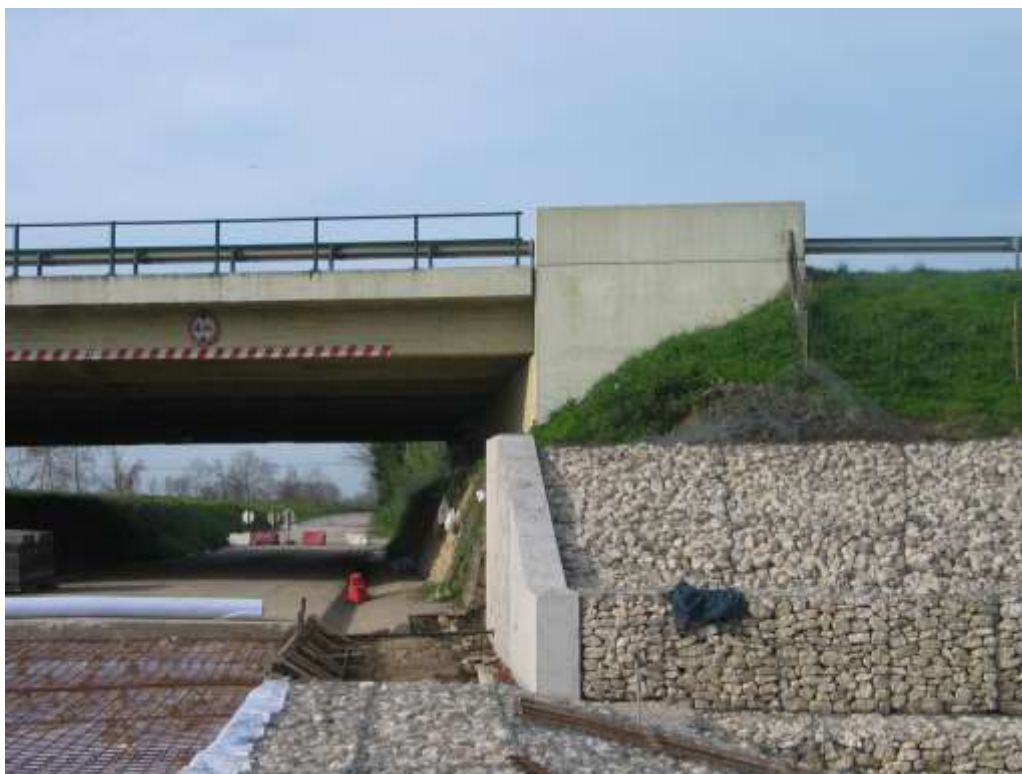
Estrutura de dissipação de energia do descarregador ECC 3 Muro de suporte do talude da A1 betonado e concluído
