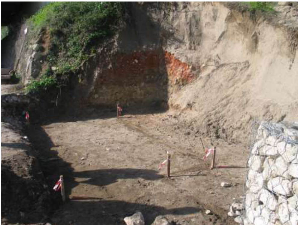
Estrutura de dissipação de energia do descarregador ECC 3 Escavação para construção do muro de suporte do talude da A1
