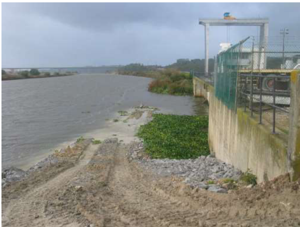
Consolidação da fundação a jusante da estação elevatória do Foja Evolução do enchimento com enrocamento e tout-venant da fundação da soleira
