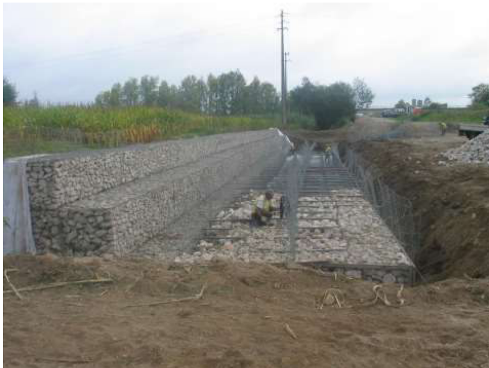
Aspetto da evolução da execução dos gabiões na vala da estrutura de dissipação de energia do descarregador de cheias ECC 3
