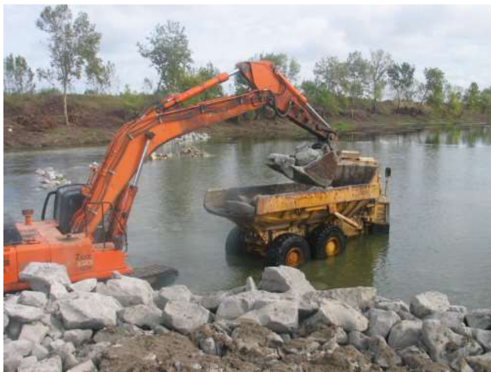
Reabilitação da soleira do perfil 115 do Leito Central do rio Mondego Reabilitação do enrocamento do esporão
