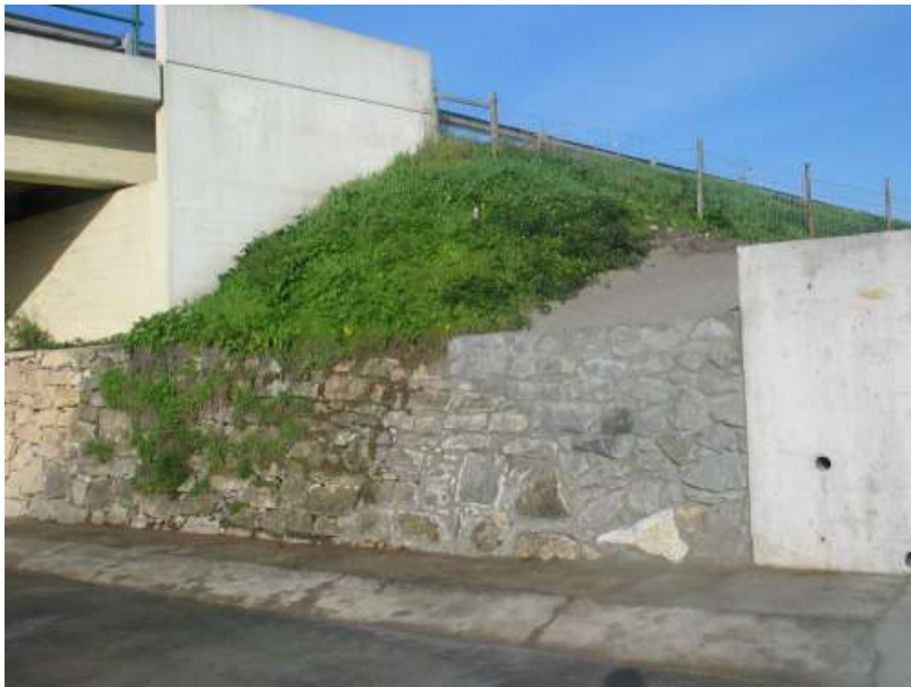
Estrutura de dissipação de energia do descarregador ECC Reabilitação do muro de proteção em perré do talude da A1
