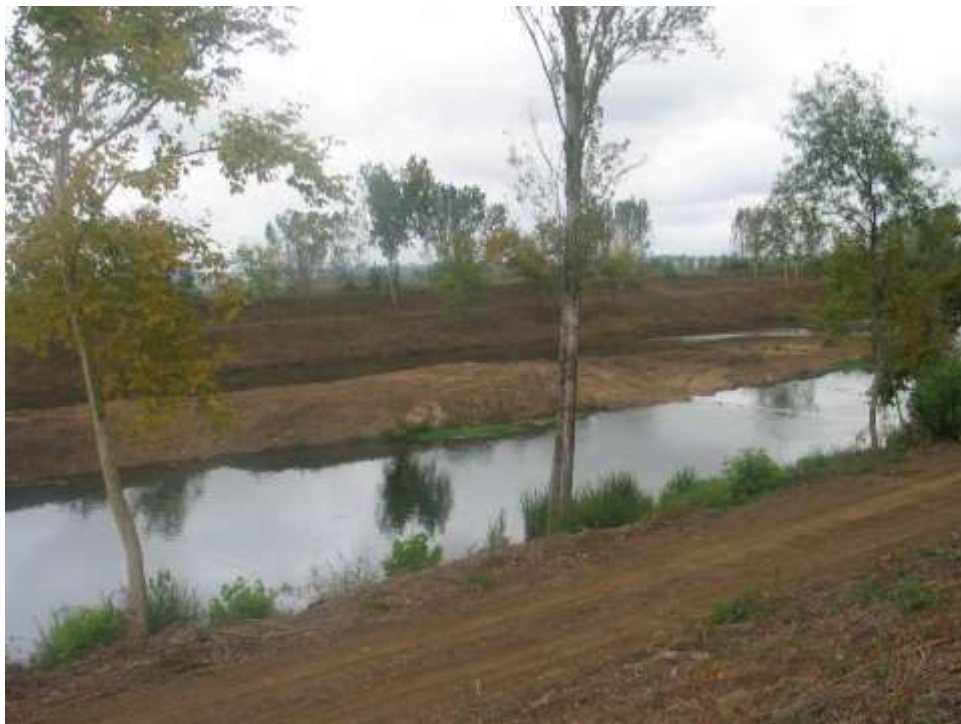
Ilha de assoreamento no meio do leito do rio a montante da soleira P115 Pormenor
