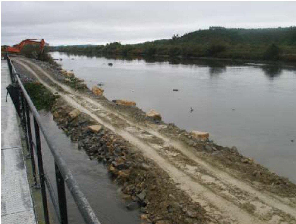
Consolidação da fundação a jusante da estação elevatória do Foja Evolução do enchimento com enrocamento e tout-venant da fundação
