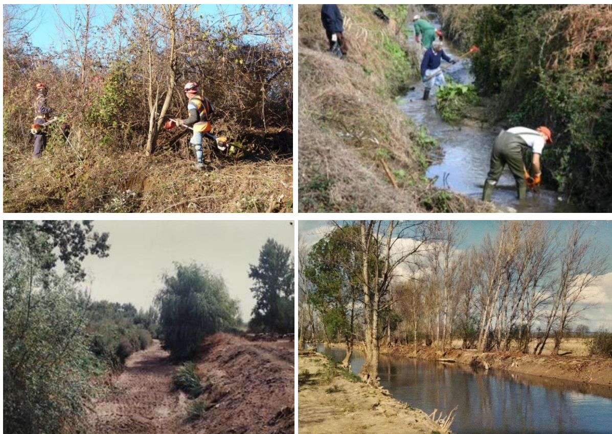
Figura 44 - Realização de ações de limpeza no âmbito da medida PT_PROT1_NAC
