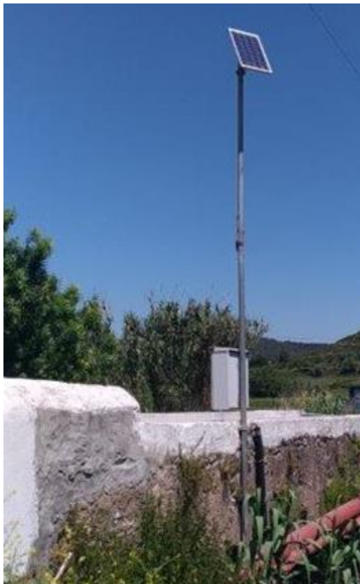
Figura 46 - Estação Hidrométrica de Runa
