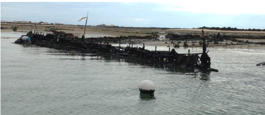
Figura 35. Viveiro na zona da Culatra com pneus, entulho diverso e blocos de fibrocimento.
