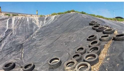
Passou a estar expressamente estabelecido que os resíduos de pneus podem ser utilizados como elemento de proteção da barreira de impermeabilização artificial do aterro (n.º 3.3, anexo I do RJDRA)
