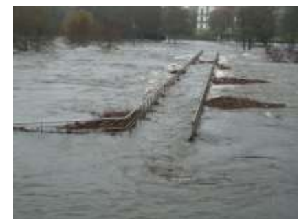
Arcos de Valdevez – mar/2015 (Fonte: Município de Arcos de Valdevez)
