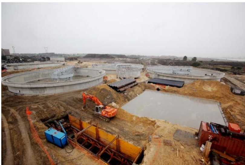
Figura 13 – Intervenção da SIMARSUL
