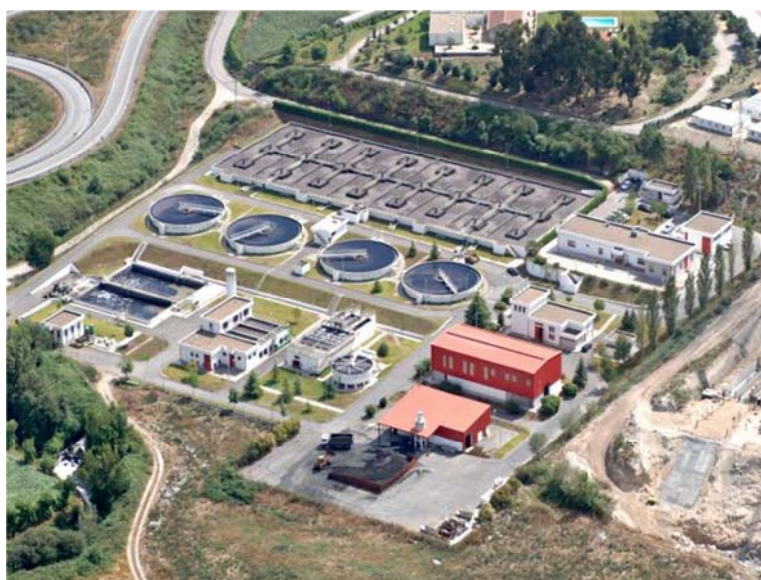
Figura 12 - Intervenção da Águas do Ave
