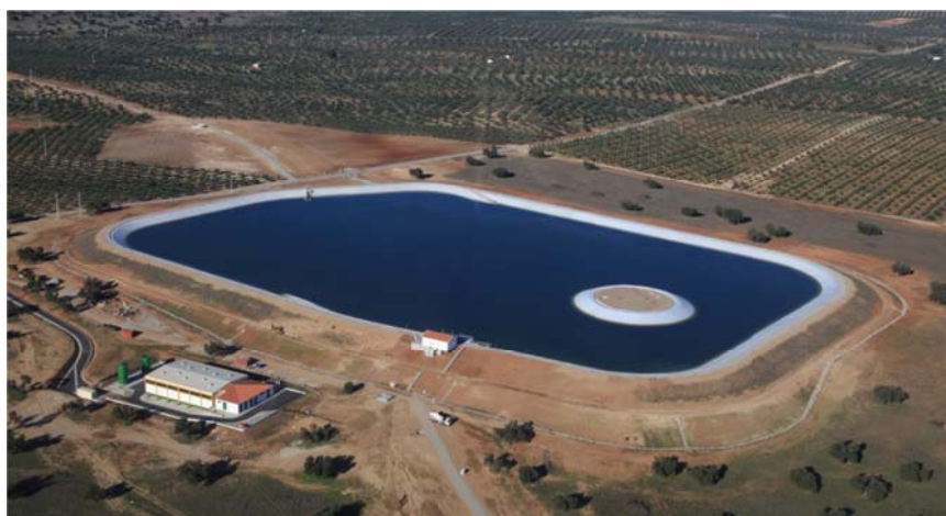
Figura 16 – Intervenção Adutor Brinches-Enxoé
