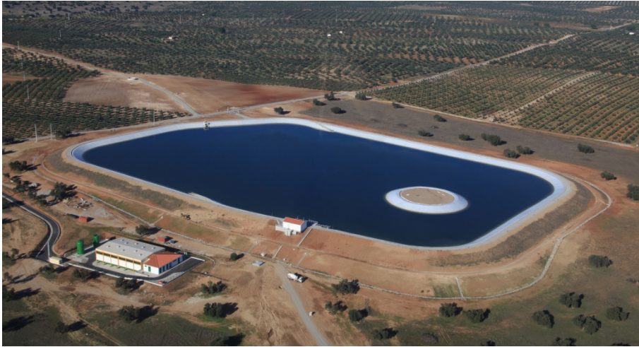
Figura 24 - Intervenção Adutor Brinches-Enxoé
