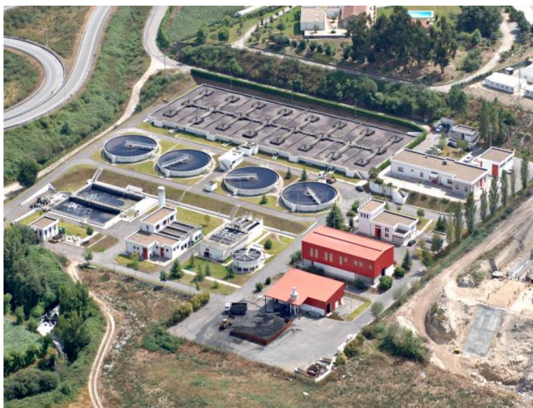
Figura 20 - Intervenção da Águas do Ave
