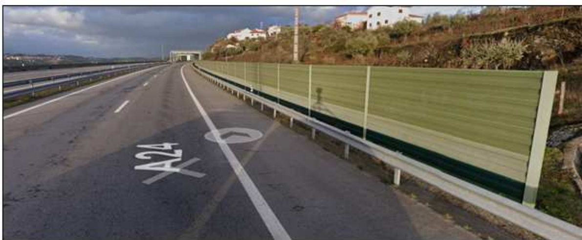
Figura 3 – Exemplo de barreiras acústicas em painéis metálicos perfurados instalados na A24
