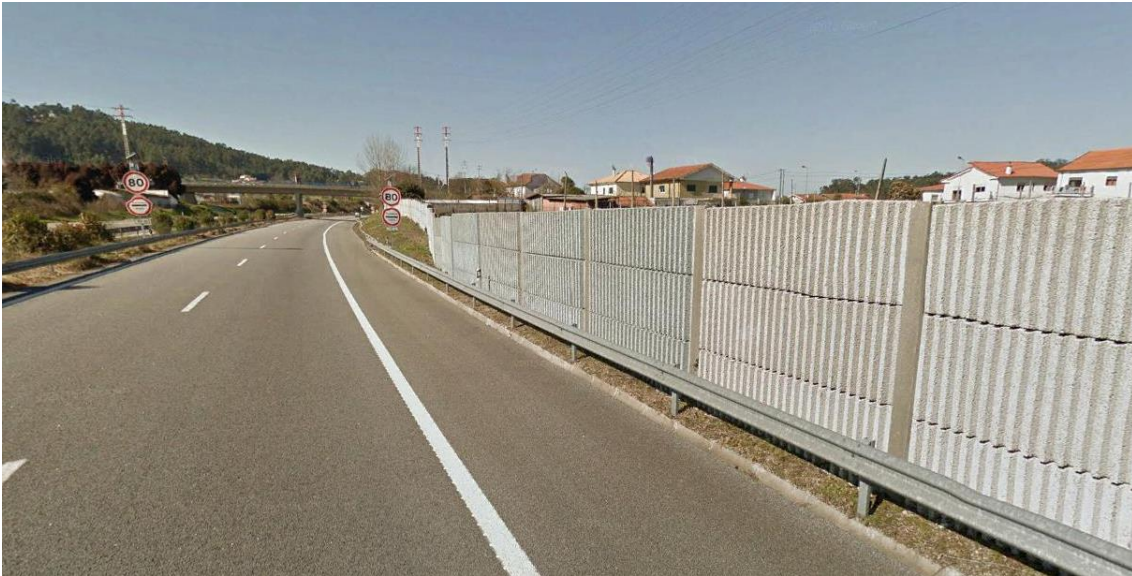
Imagem 3: Barreira de betão
