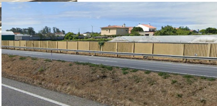
Figura 1 – Exemplos de barreiras acústicas de diversos tipos instaladas na A28
