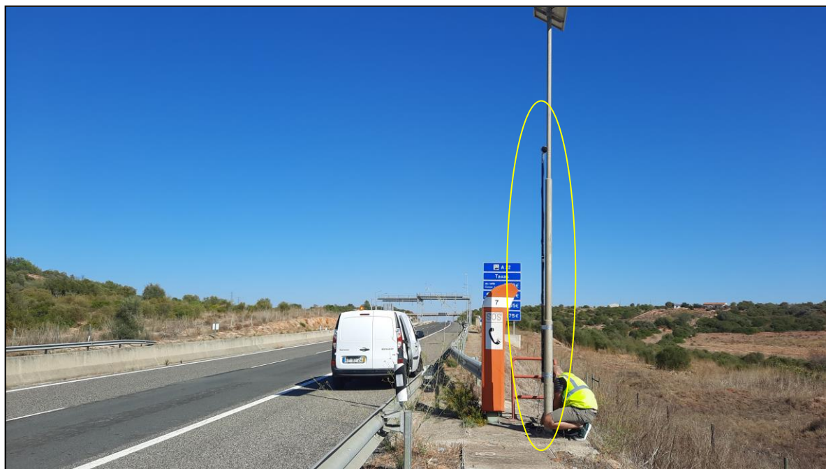
Figura 6-6 – Localização do P03, realizado no sublanço Mexilhoeira – Alvor entre 19 e 21 de outubro de 2021
