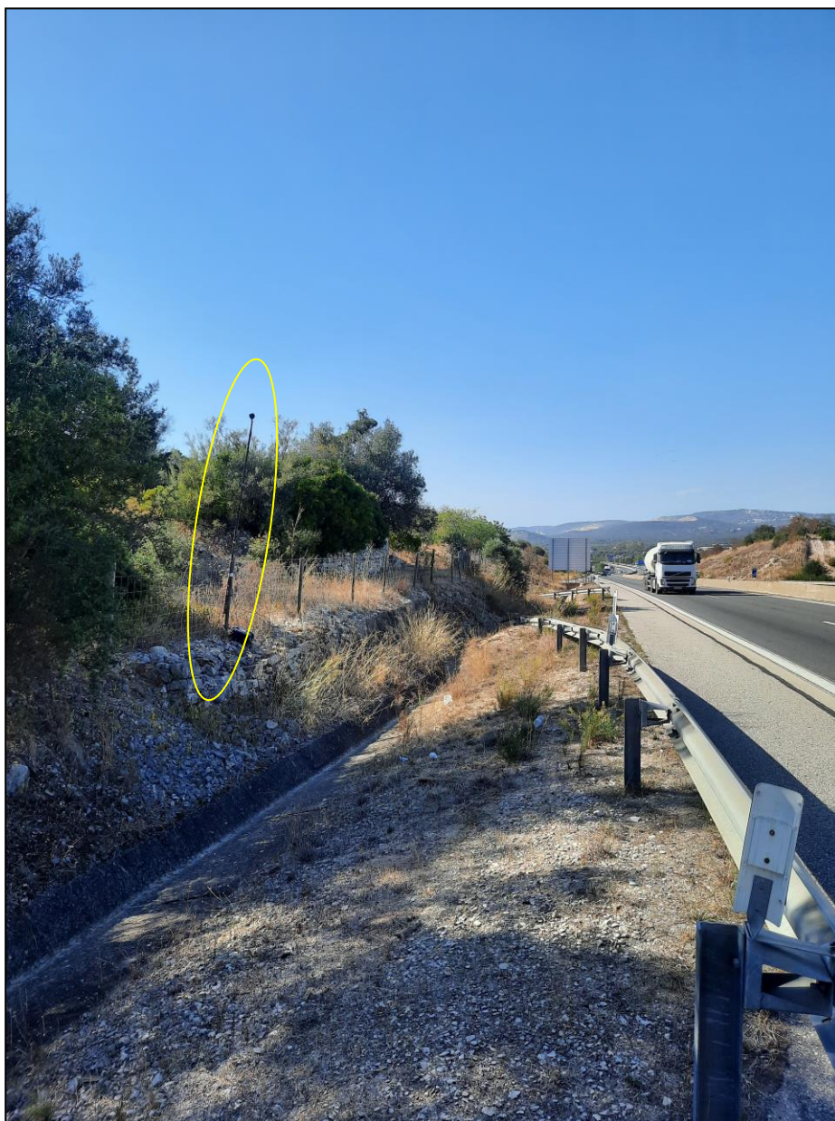
Figura 6-13 – Localização do P10, realizado no sublanço Loulé - Faro/Areroporto entre 26 e 28 de outubro de 2021
