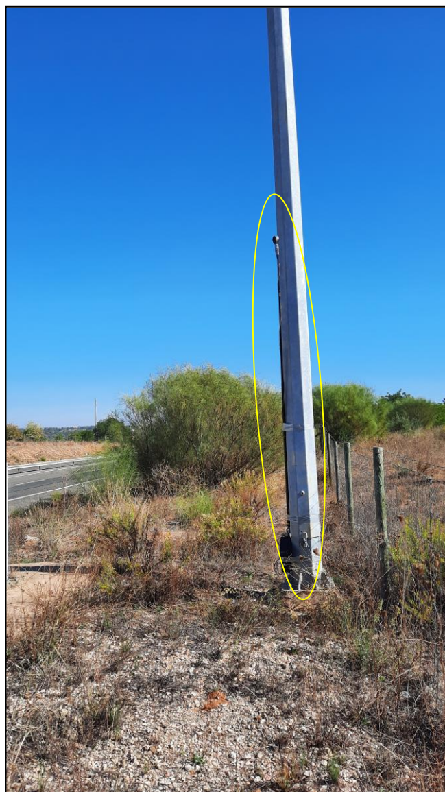
Figura 6-8 – Localização do P05, realizado no sublanço Lagoa/Silves – Alcantarilha entre 19 e 21 de outubro de 2021
