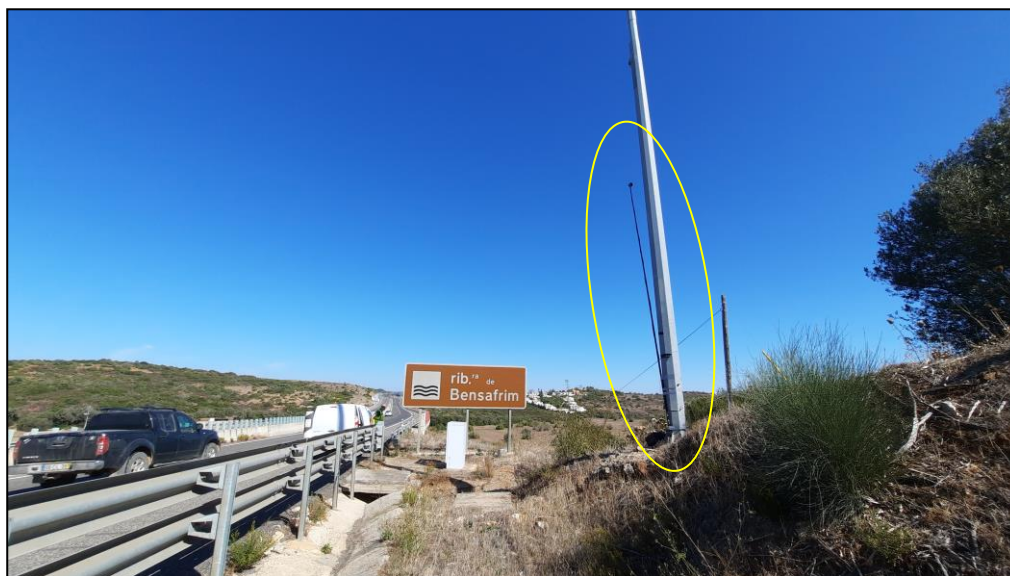
Figura 6-4 – Localização do P01, realizado no sublanço Lagos – Odiáxere entre 19 e 21 de outubro de 2021
