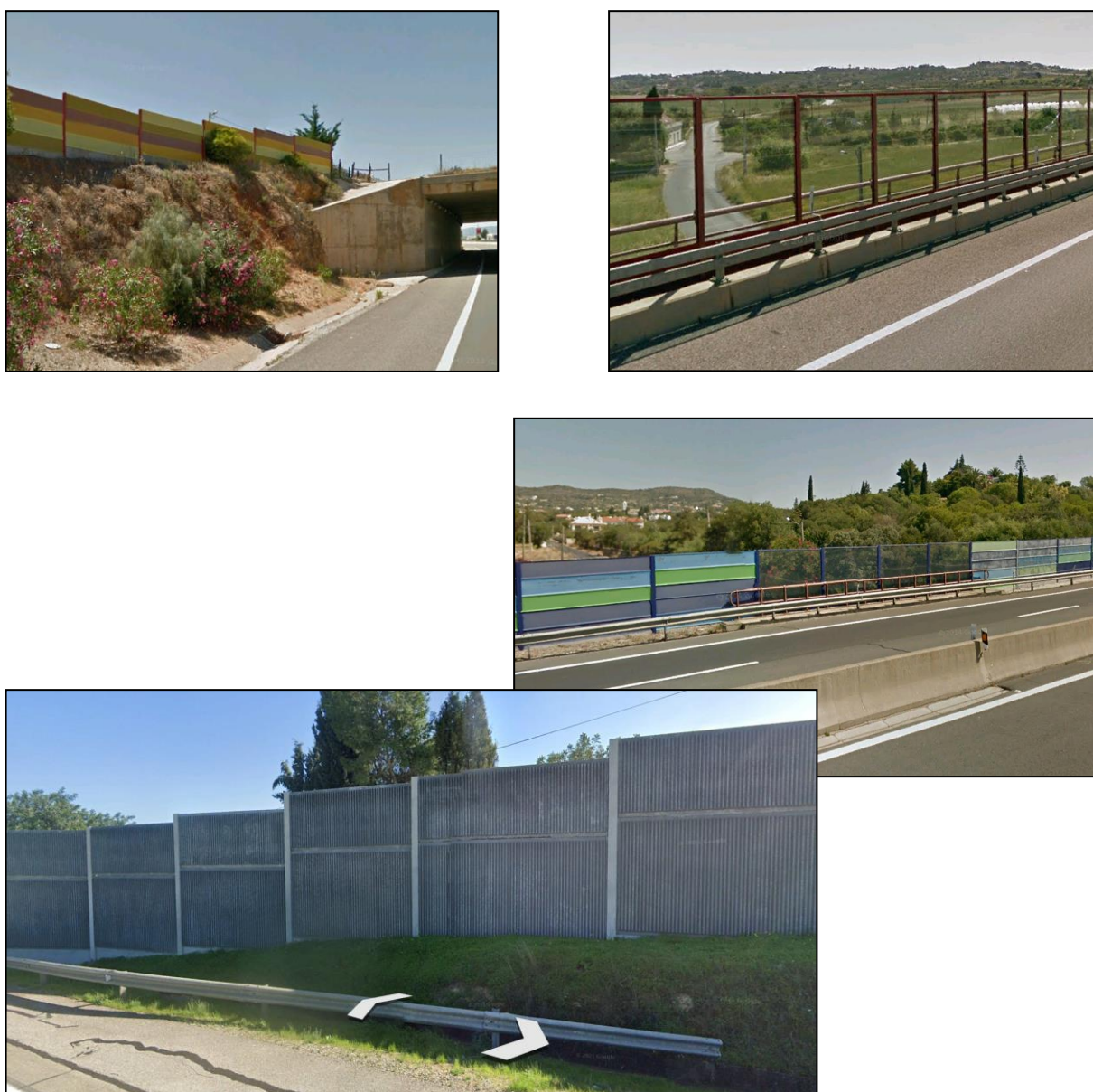
Figura 4-3 – Exemplos de barreiras acústicas de diversos tipos instaladas na Via do Infante
