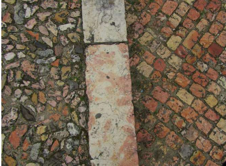
Fot. 27– Um aspecto do pavimento da capela da Memória
