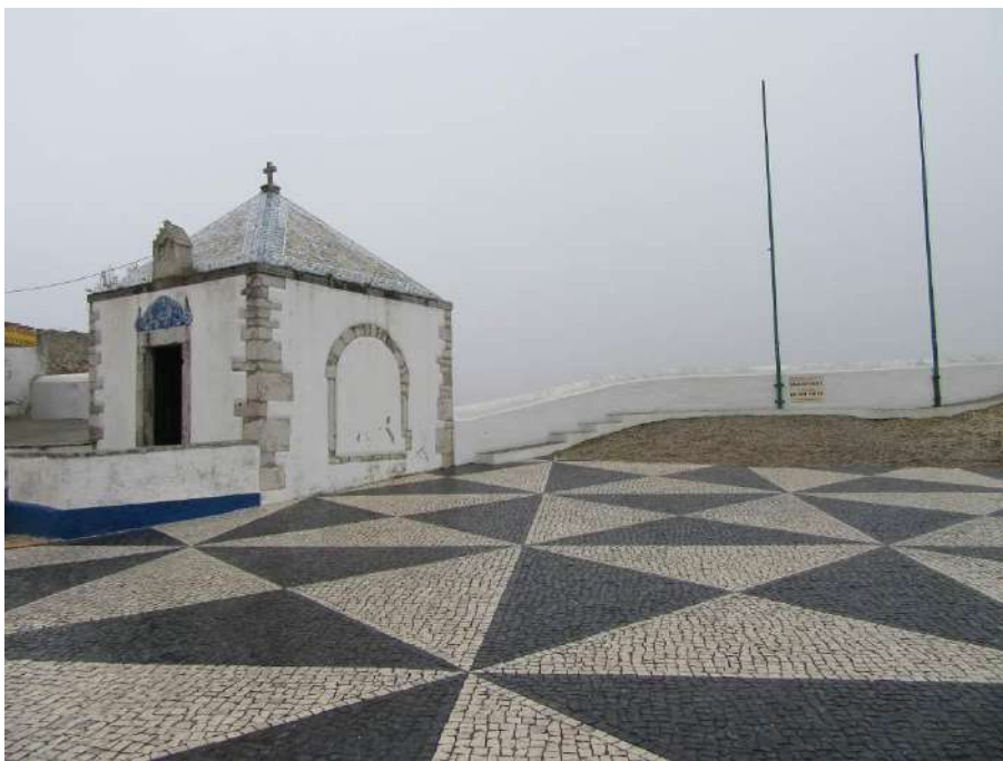
Fot. 20 – Capela da Memória e o pavimento em calçada “portuguesa” que será reproduzido
