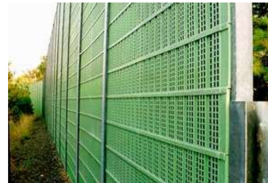
Figura A1. 40 - Barreira absorvente em material plástico (FHWA, et al., 2000)
