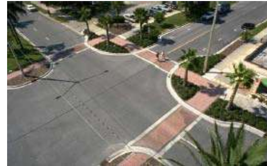
Figura A1. 11 - Exemplo de restrição de largura à entrada de intersecções (Huang, et al., 2001)
