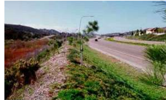
Figura A1. 43 - Barreiras “naturais” em mota de terra (FHWA, et al., 2000)
