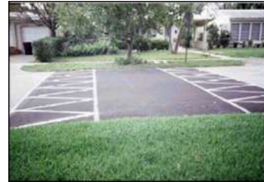
Figura A1. 17 - Exemplo de lombas do tipo "hump" (Partington, 1999)
