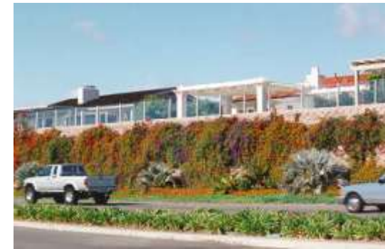
Figura A1. 39 - Barreira acústica transparente com pormenor de integração paisagística (FHWA, et al., 2000)
