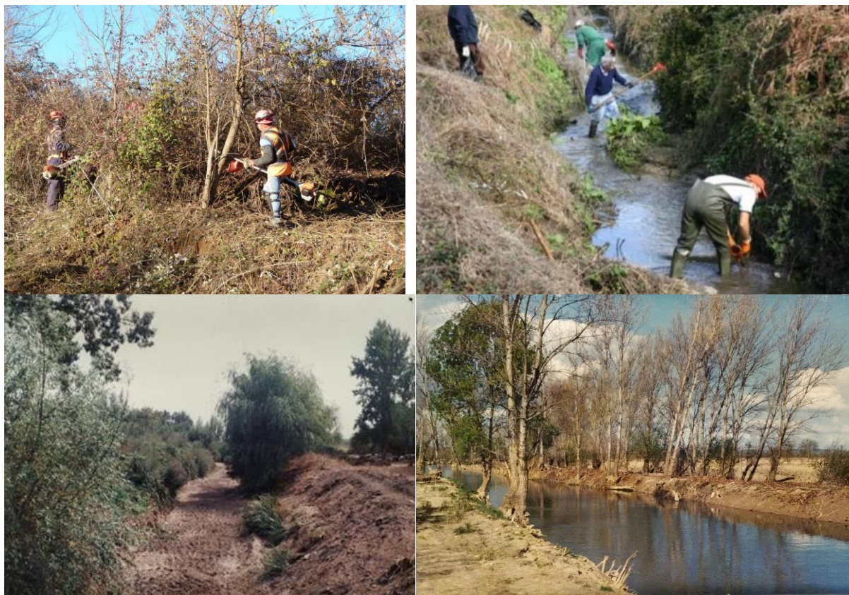
Figura 36 - Realização de ações de limpeza no âmbito da medida Desassorear, desobstruir e remover material dos cursos de água e de albufeiras (PT_PROT1_NAC)
