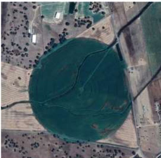
5 Pivot instalado em cima de segmento da Ribeira da Figueira
