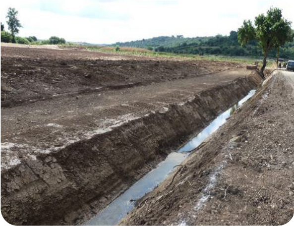
Intervenções em aflente do rio Maior
