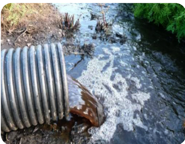
Descarga das águas de arrefecimento - contaminadas pelas águas ruças - em linha de água afluente sem denominação da Ribeira de Seda
