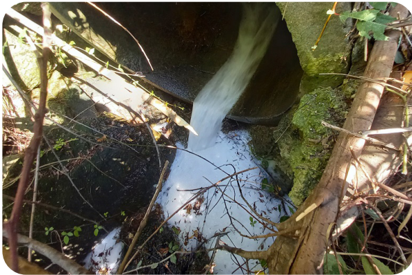
Rejeição de efluente industrial para uma linha de água, por intermédio de um coletor de águas pluviais
