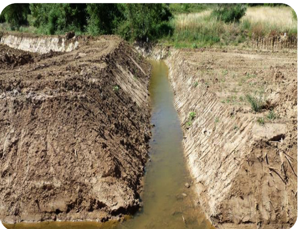
Intervenções no aflente da ribeira de Almoster
