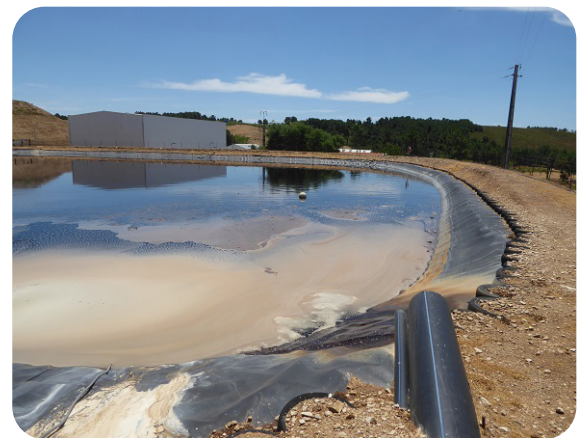
Tanque de lixiviado de aterro sanitário
