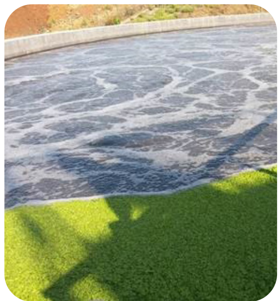
ETAR da Zona Industrial Descarga de coletor de águas pluviais da ZI a denotar espumas
