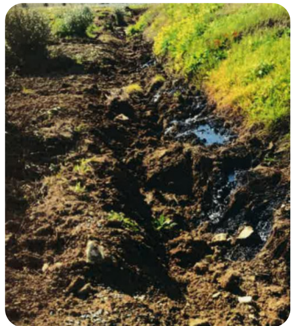
Vista geral e de pormenor, da rejeição de águas sujas que percolaram de unidade industrial de secagem de bagaço de azeitona e de extração de óleos alimentares atingiram a plataforma ferroviária de Alvito
