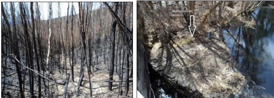
Figura 23 e Figura 24- Corte e remoção de material vegetal arbóreo e arbustivo ardido (à esquerda) e remoção de sedimentos em açude existente (à direita).
