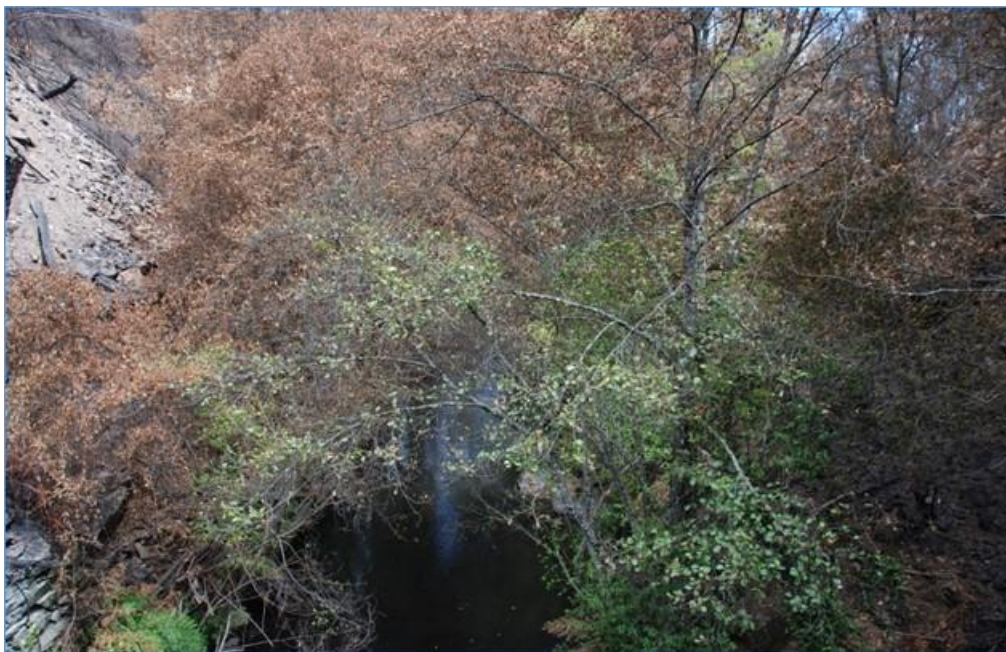
Figura 20 - Consolidação e recuperação de taludes e margens.
