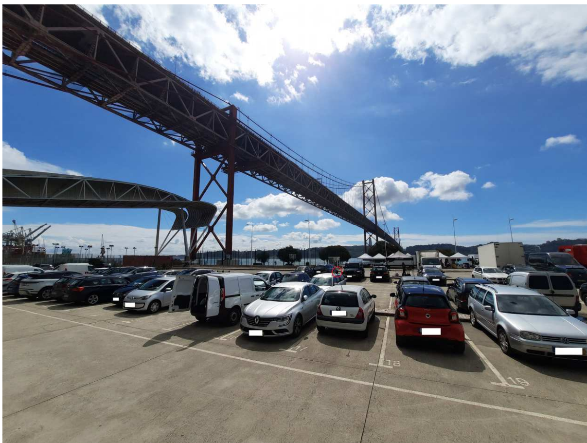
Figura 5-13 – Localização do ponto P2 (monitorização 48 h).
