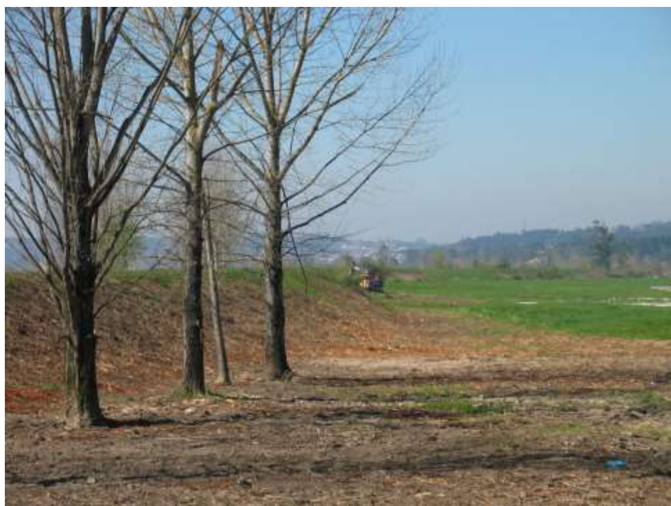
Limpeza de vegetação no dique e golena a jusante da travessia de Sandelgas
