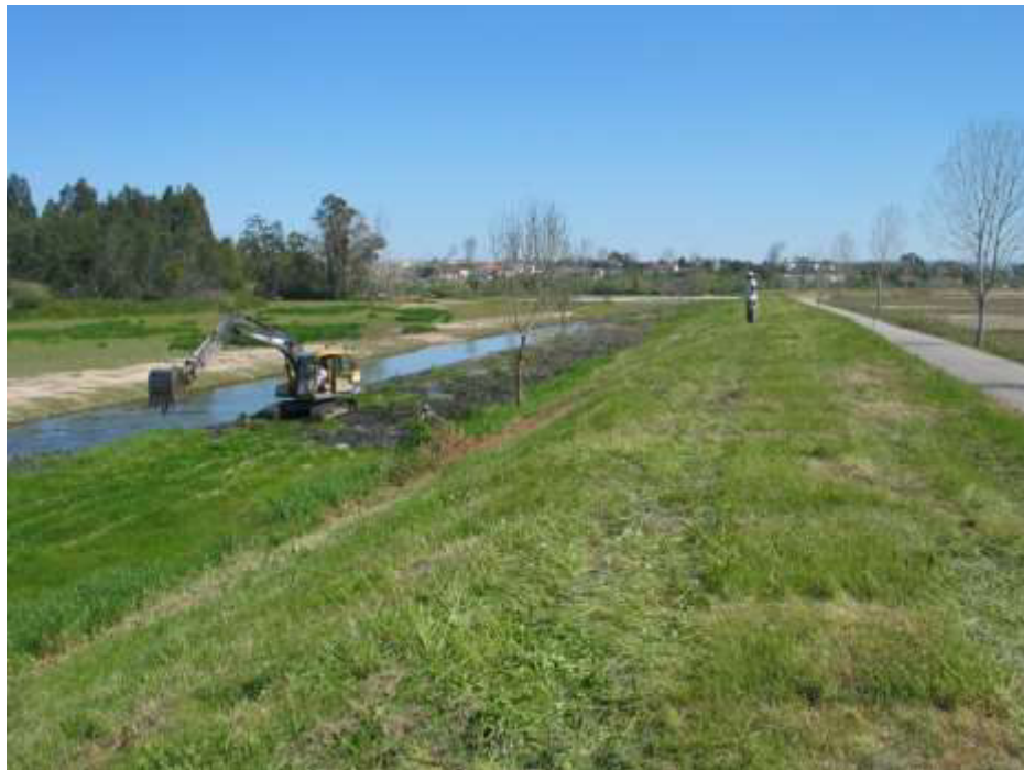
Desassoreamento do leito menor entre as travessias de Tentúgal e das Meãs - Renault Limpeza de vegetação concluída
