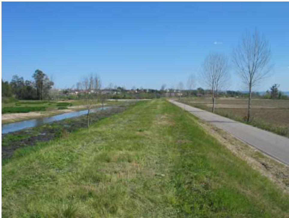
Troço entre a travessia de Tentúgal e das Meãs – Renault Limpeza de vegetação e desassoreamento concluídos
