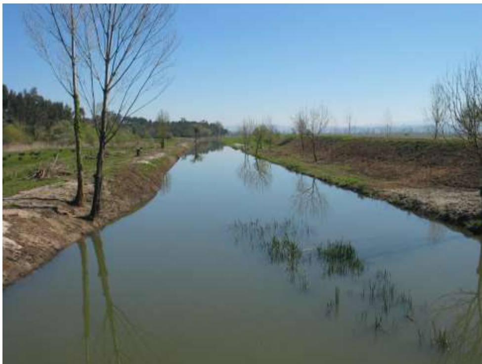
Limpeza de vegetação e desassoreamento a montante da travessia de Tentúgal
