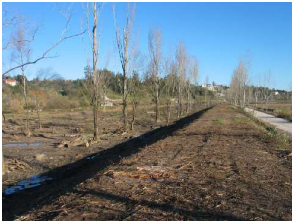
Limpeza de vegetação do leito maior da margem direita entre as travessias de S. Martinho de Árvore e Quimbres
