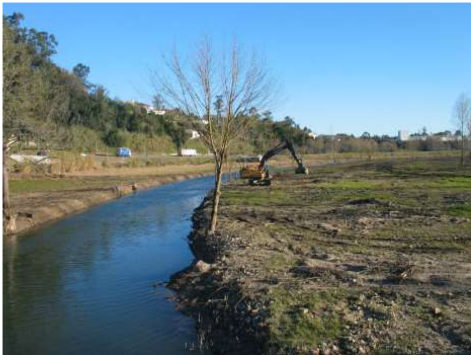
Desassoreamento do leito menor a montante da travessia de Quimbres
