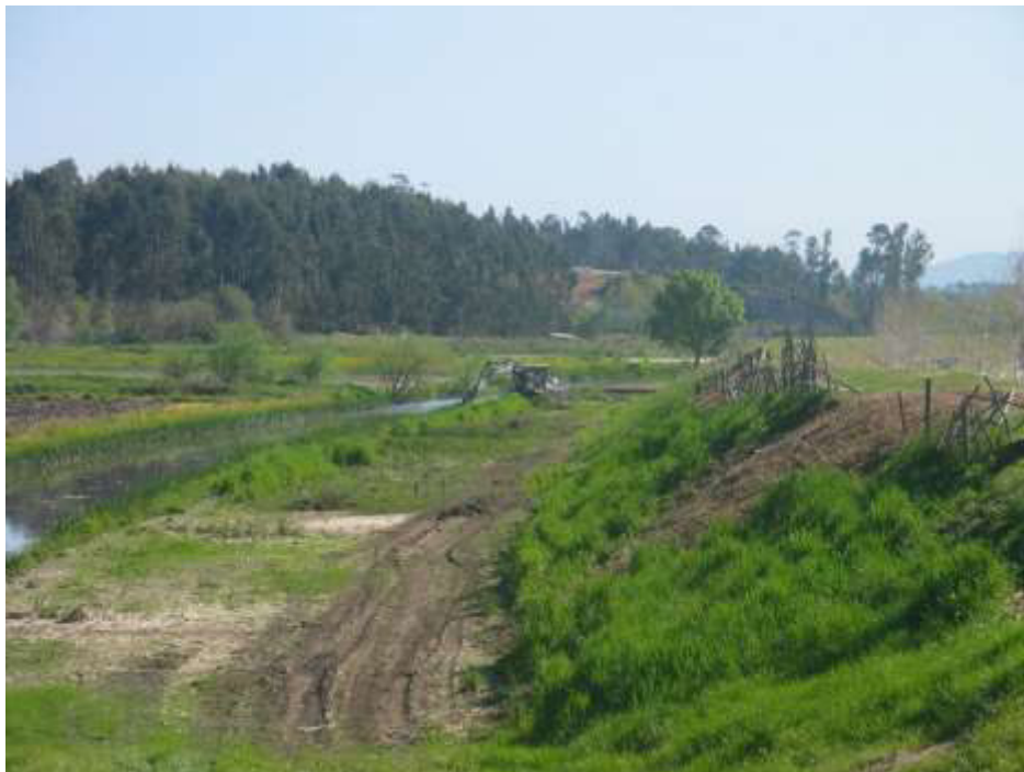
Limpeza de vegetação e desassoreamento do leito menor a montante da travessia das Meãs Pormenor
