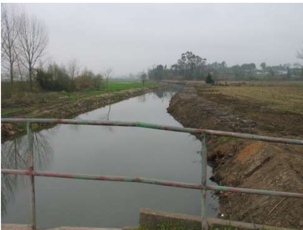
Desassoreamento do leito menor a jusante da travessia de S. Martinho de Árvore
