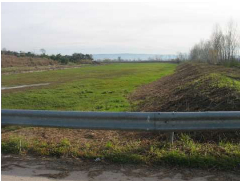
Limpeza de vegetação e desassoreamento do leito menor concluído entre as travessias de Quimbres e S. Martinho de Árvore
