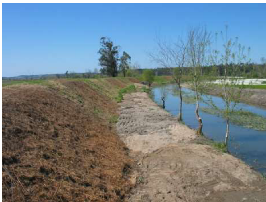
Limpeza de vegetação e desassoreamento do leito menor a jusante da travessia de Tentúgal
