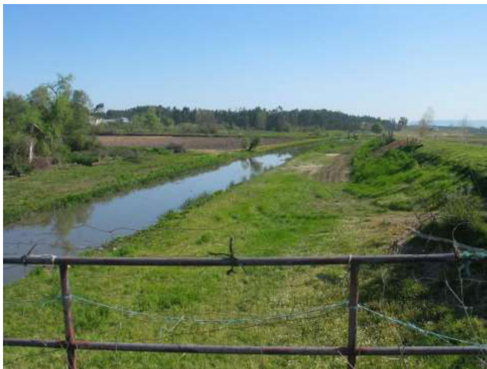
Limpeza de vegetação e desassoreamento do leito menor a montante da travessia das Meãs
