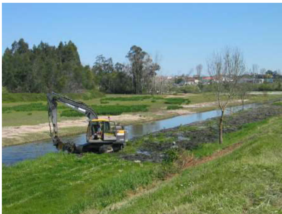
Desassoreamento do leito menor entre as travessias de Tentúgal e das Meãs - Renault Limpeza de vegetação concluída Pormenor
