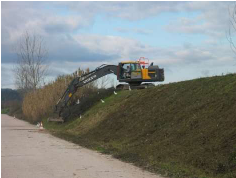
Limpeza de vegetação do dique a montante da travessia de S. Martinho de Árvore
