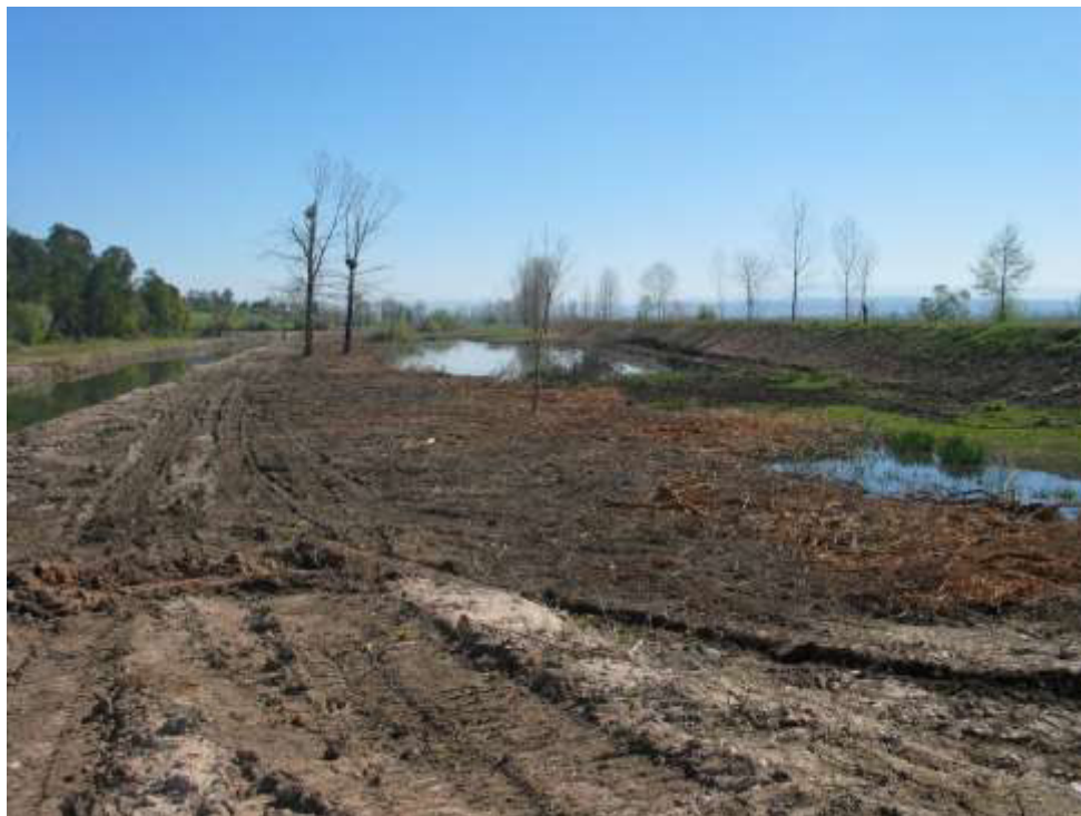
Limpeza de vegetação e desassoreamento a montante da travessia de Sandelgas
