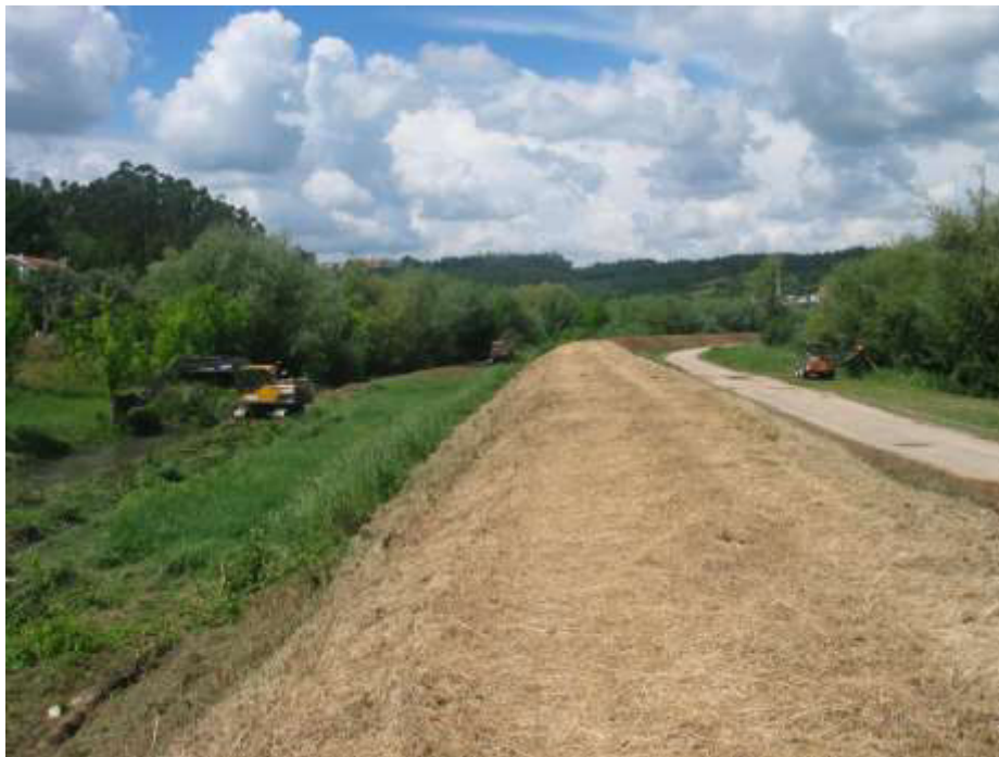
Limpeza de vegetação e desassoreamento do leito na zona de Antuzede Vista de jusante para montante ( Maio 2018 )
