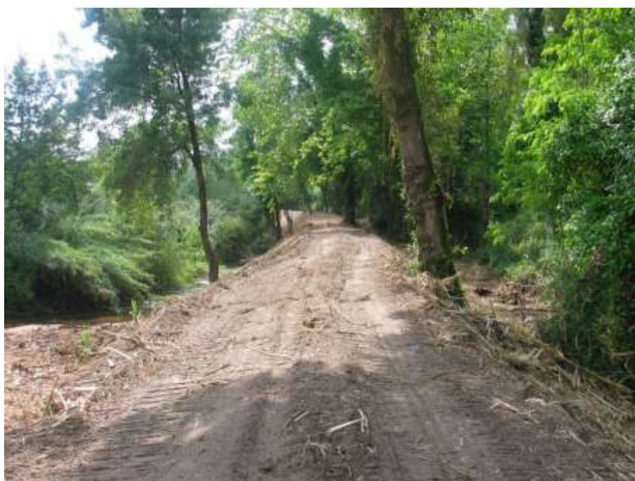
Corte e destroçamento de vegetação no dique na Mata da Geria ( Maio 2018 )
