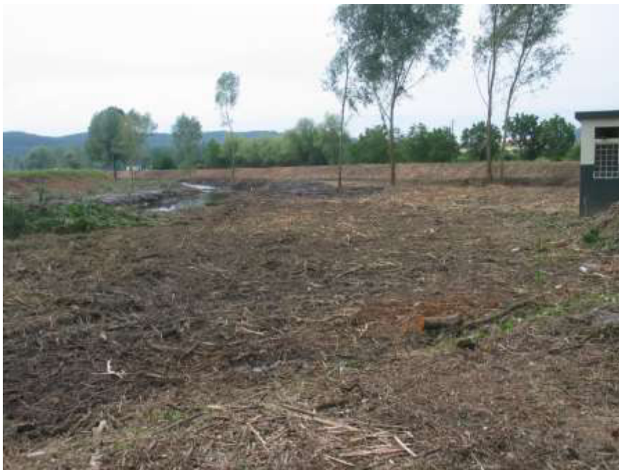
Limpeza de vegetação e desassoreamento no leito na zona da confluência da Ribeira de Eiras (Junho 2018)
