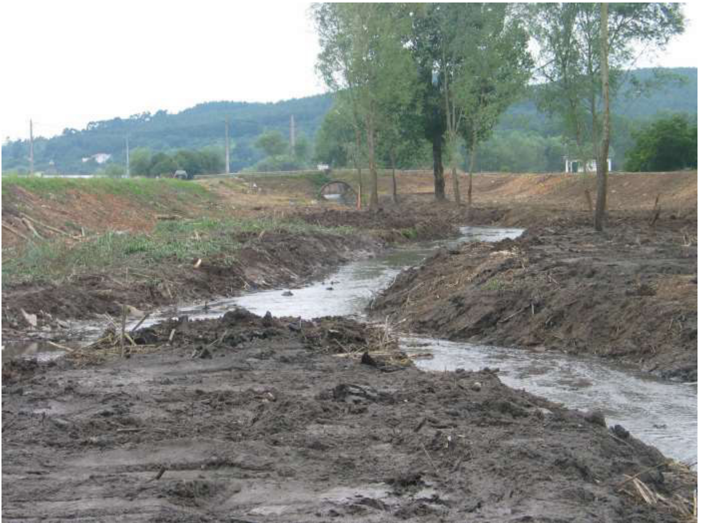
Limpeza de vegetação e desassoreamento no leito na zona da confluência da Ribeira de Eiras e a montante da Travessia da Adémia (Junho 2018)
