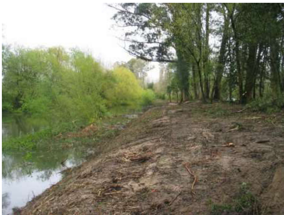
Limpeza de vegetação arbórea e arbustiva no leito na zona da Mata da Geria (Abril 2018 )
