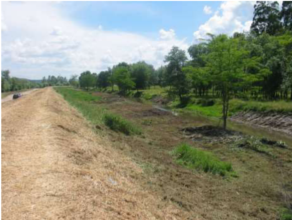
Limpeza de vegetação e desassoreamento do leito na zona de Antuzede Vista de montante para jusante ( Maio 2018 )
