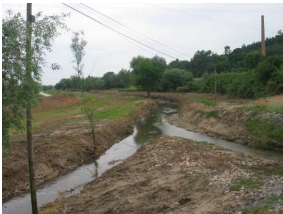
Desassoreamento do leito na zona a jusante da confluência da Ribeira dos Fornos (Junho 2018)
