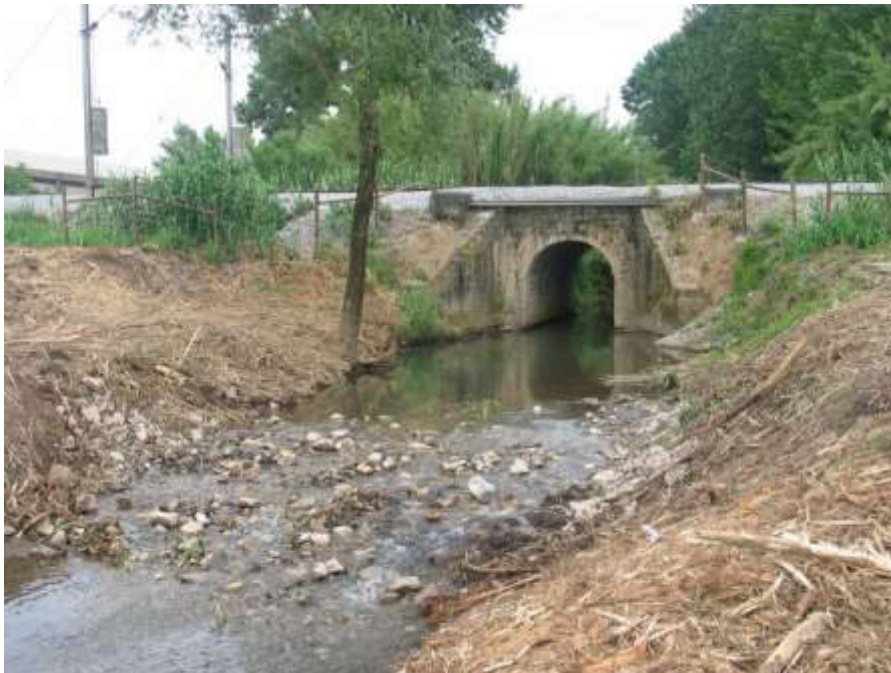
Limpeza de vegetação no leito a jusante da confluência da Ribeira de Eiras (Junho 2018)
