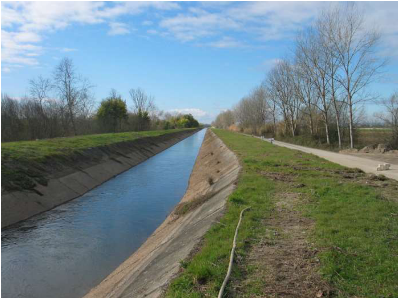
Limpeza de vegetação no coroamento do dique da margem direita a jusante do descarregador de cheias ECC 2 concluída
