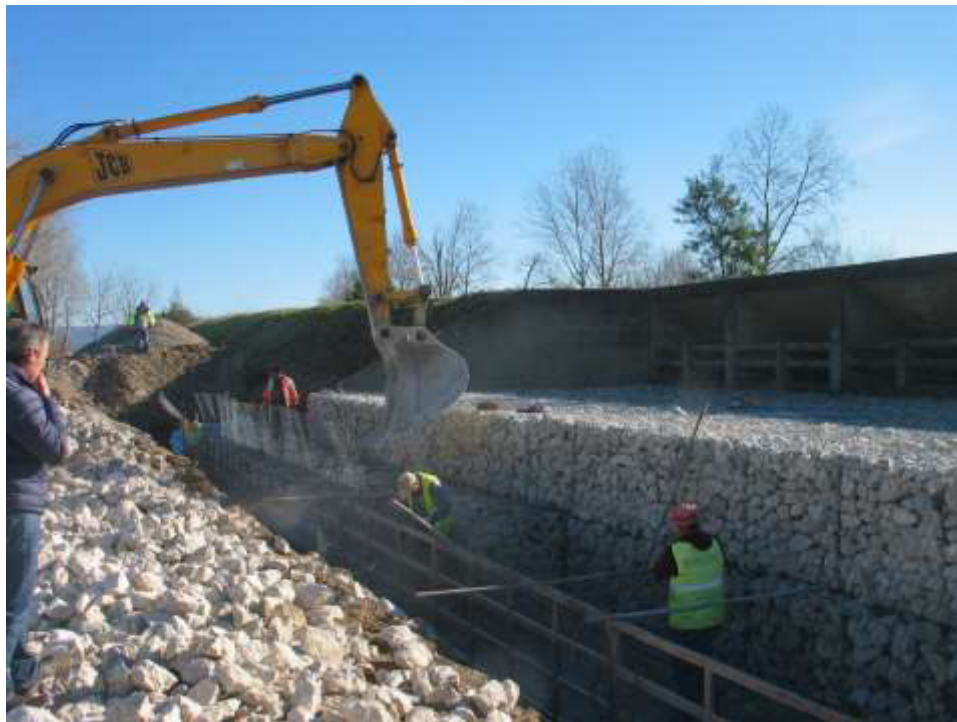
Execução dos gabões na estrutura de dissipação de energia do descarregador de cheias ECC 2
