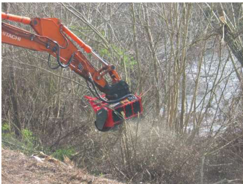
Limpeza de vegetação no talude e golena do dique da margem direita no troço a jusante do Choupal Pormenor
