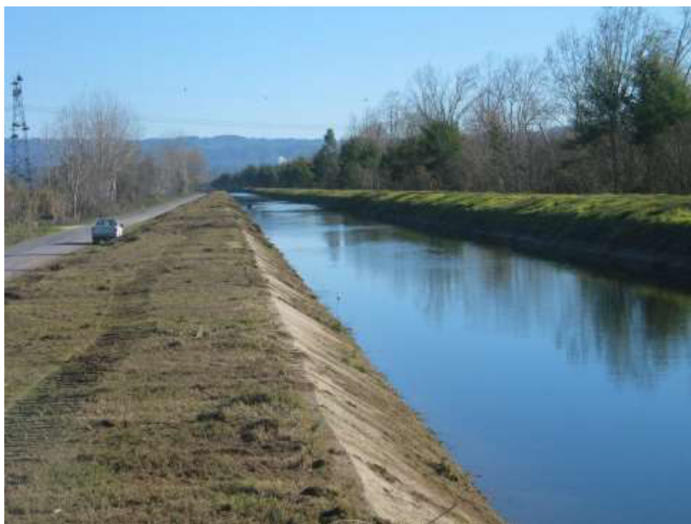
Limpeza de vegetação no coroamento do dique da margem direita a jusante do viaduto da A1 Vista para montante
