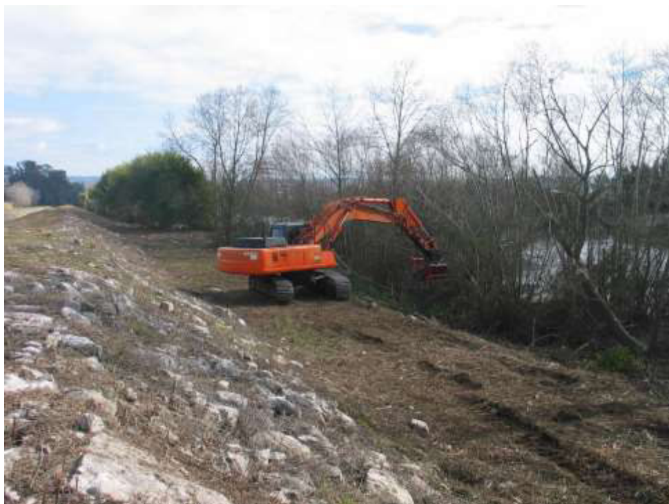
Limpeza de vegetação no talude e golena do dique da margem direita no troço a jusante do Choupal
