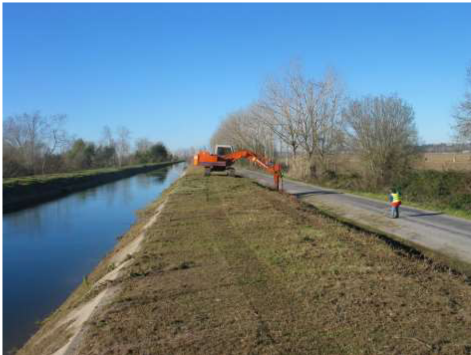
Limpeza de vegetação no coroamento do dique da margem direita a jusante do viaduto da A1 Vista para jusante
