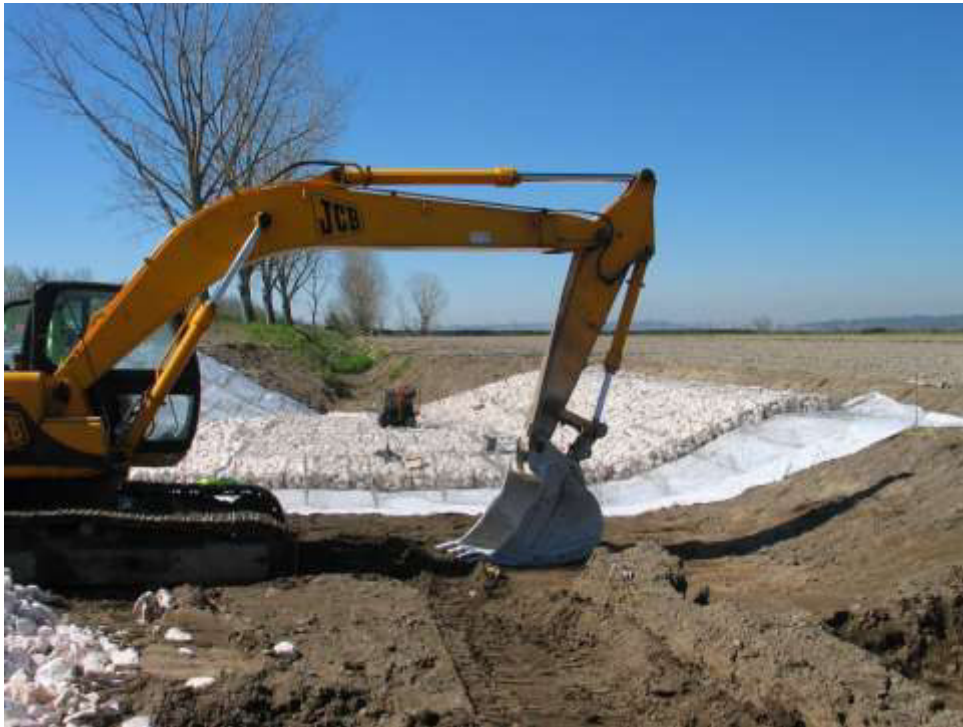
Execução do revestimento de proteção em colchão - reno da vala de enxugo integrada na estrutura de proteção do descarregador ECC1
