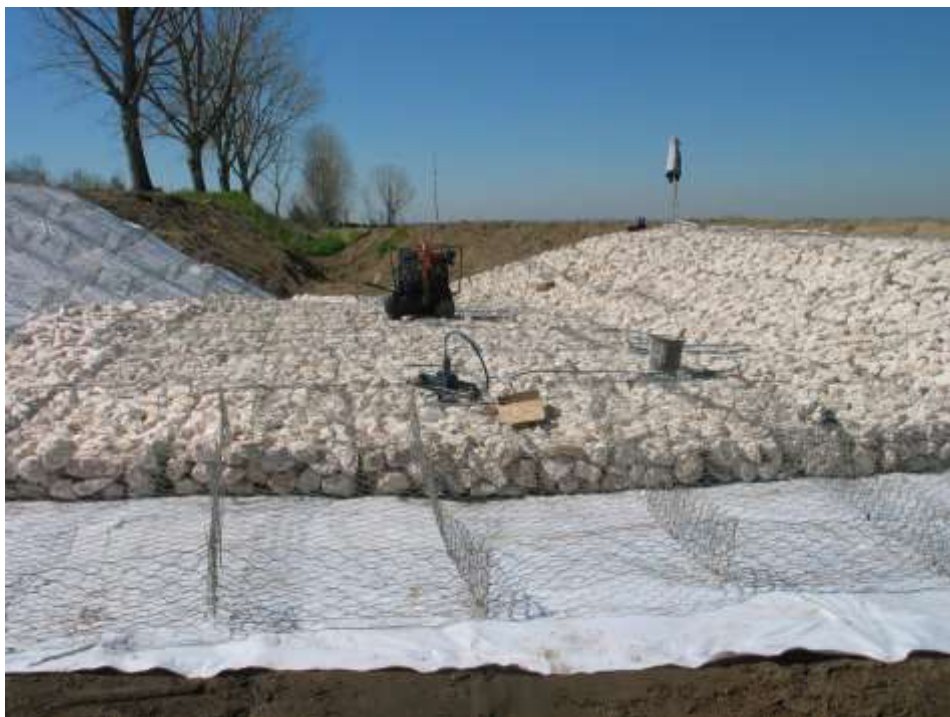
Execução do revestimento de proteção em colchão - reno da vala de enxugo integrada na estrutura de proteção do descarregador ECC1 Pormenor
