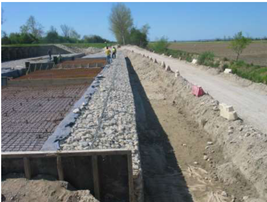
Estrutura de proteção do descarregador de cheias ECC 2 Montagem de armadura de ferro para posterior betonagem da zona da estrada de manutenção
