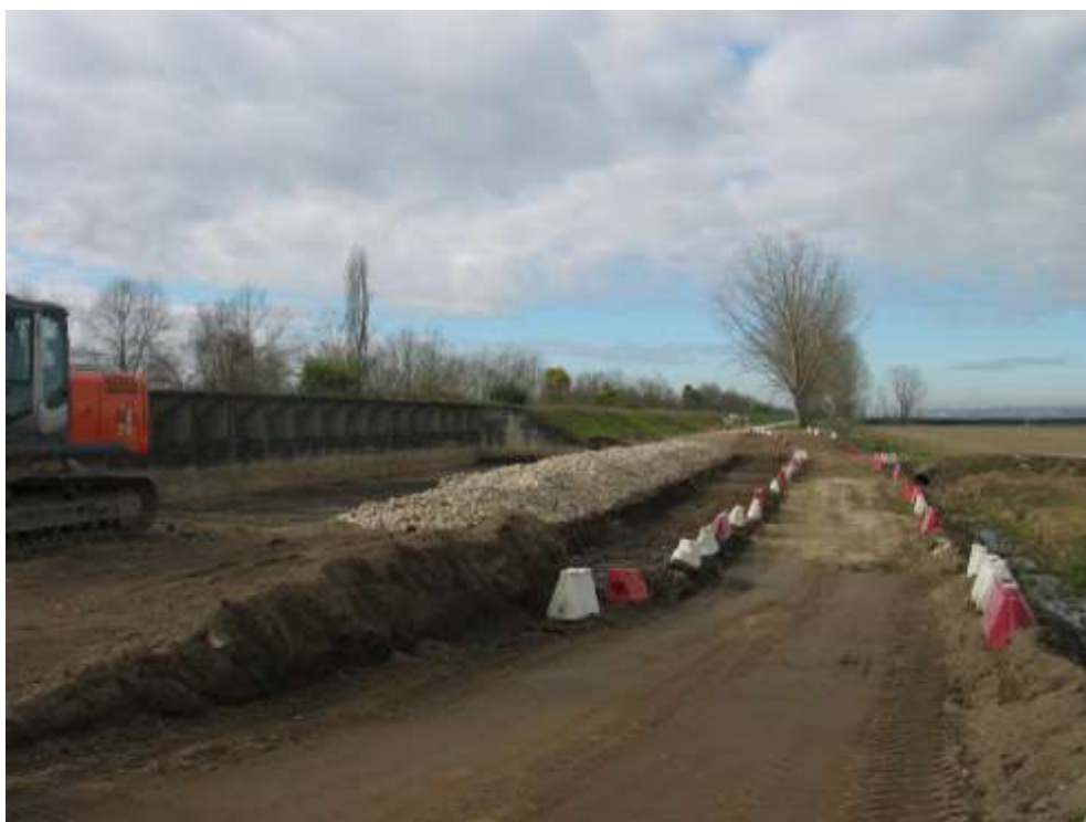
Escavação concluída e início do transporte de enrocamento para execução de gabões na estrutura da proteção do descarregador ECC1
