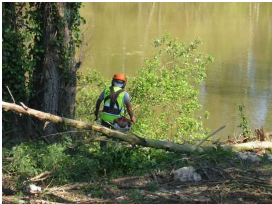
Limpeza manual de vegetação do talude do leito menor com roçadoura
