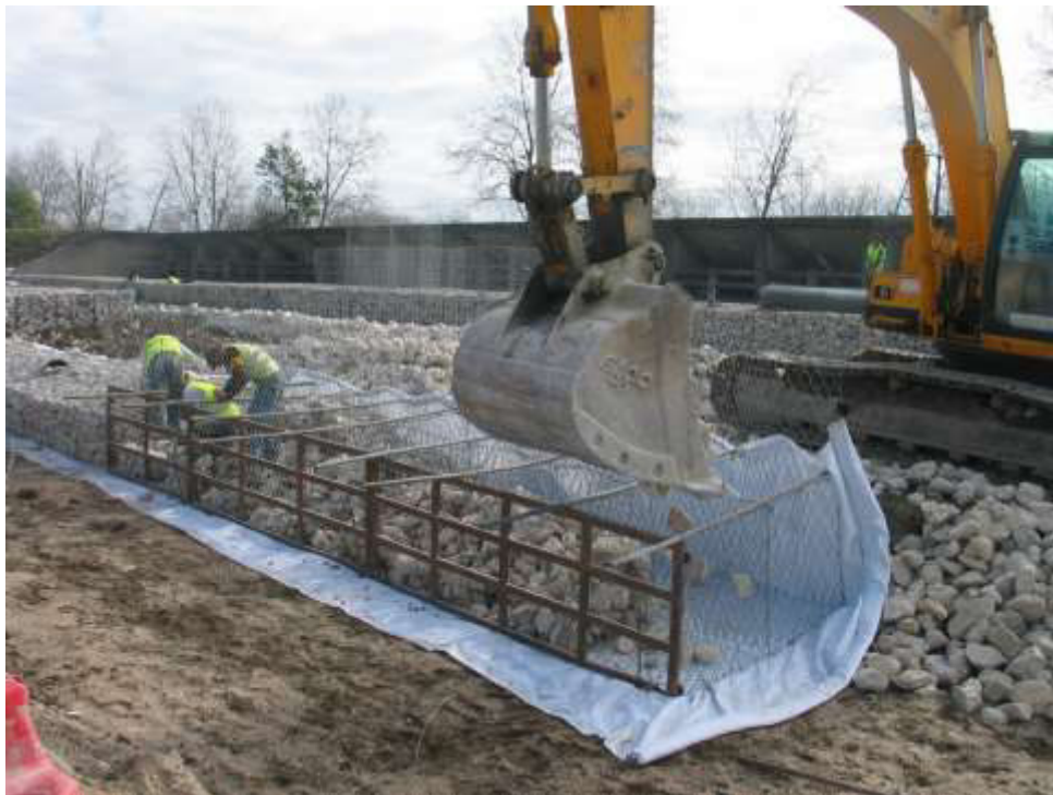
Execução dos gabiões na estrutura de proteção do descarregador de cheias ECC1
