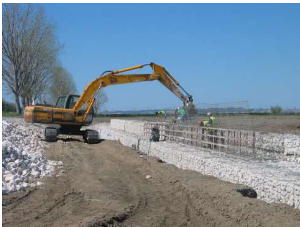
Estrutura de proteção do descarregador de cheias ECC 2 Execução dos gabiões na zona da vala de enxugo Pormenor
