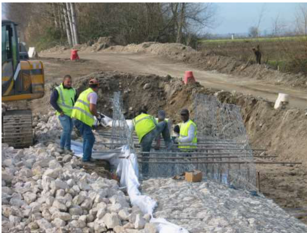
Aspecto da evolução da execução de gabiões na estrutura de dissipação de energia do descarregador ECC2 Pormenor
