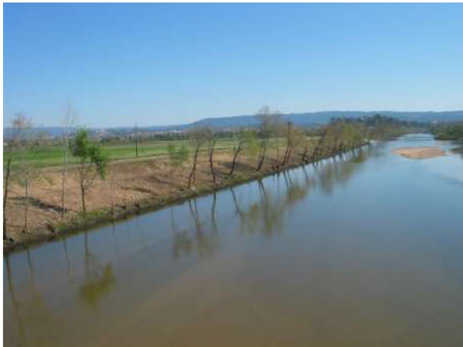
Limpeza de vegetação do dique, golena e talude do leito menor a montante da ponte de Casais concluída Vista a partir da ponte dos Casais
