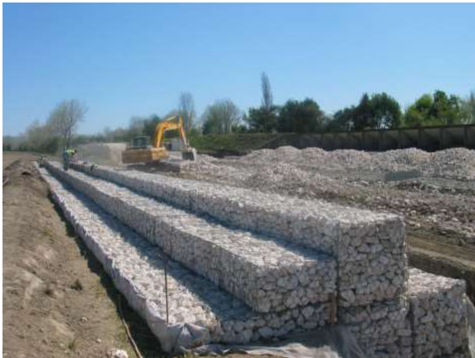
Estrutura de proteção do descarregador de cheias ECC 2 Execução dos gabiões na zona da vala de enxugo
