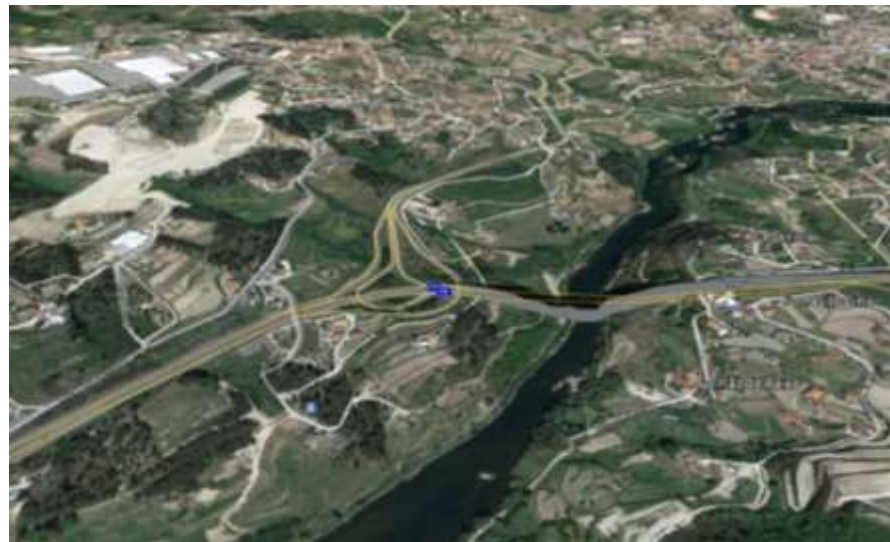
Viaduto de Amarante entre os pk 57+500 e o pk 58+000
