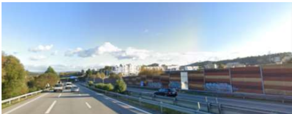
Fig. 4 Exemplos de barreiras acústicas implementadas na A4
