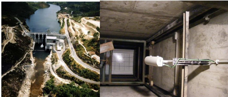
Figura 3. – Barragem do Touvedo e pormenor do ascensor para peixes (Fonte EDP, 2013)
