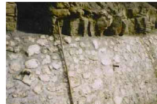
REVESTIMENTO DE PEDRA ARGAMASSADA S/ Esc.
