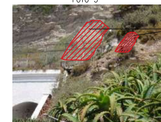
Antigo revestimento e muro de alvenaria a demolir
