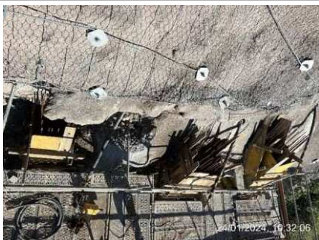
Frente de obra da plataforma Superior do Ascensor – Cofragem da terceira fase de 3 montantes;
