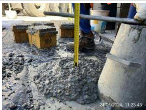
Frente de obra da plataforma Superior do Ascensor – Ensaio de Slump - 24/01/2024 - GR P518/0084724
