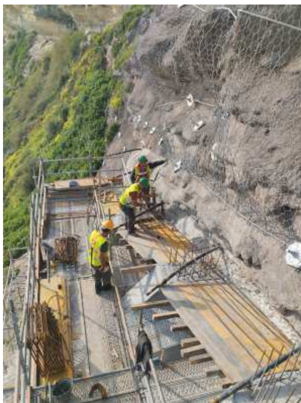
Foto 5 – Cofragem e Montagem de Armaduras da Viga Superior
