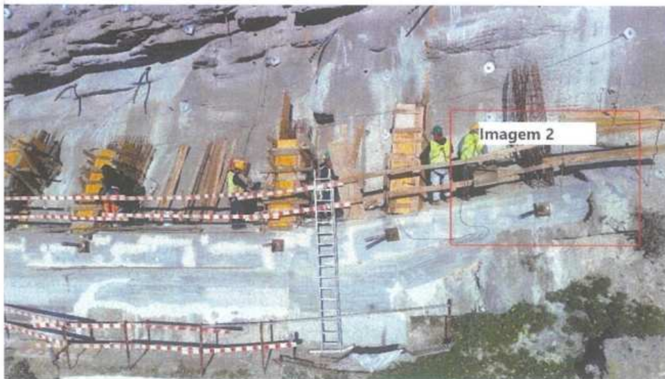
Imagem 1: Vista do Drone em 18/12/2023, pré-esforço aplicado em 14/12/2023
