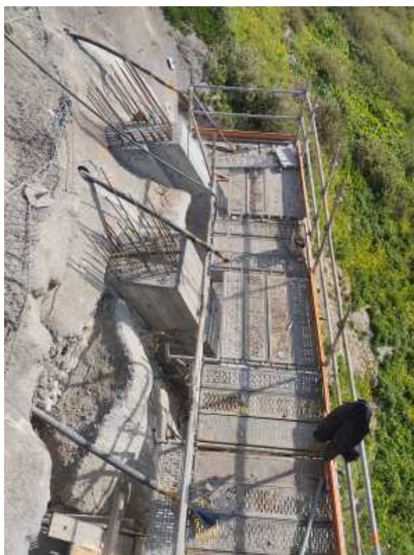
Foto 4 – Vista Geral da Frente de Trabalho (Viga Superior)
