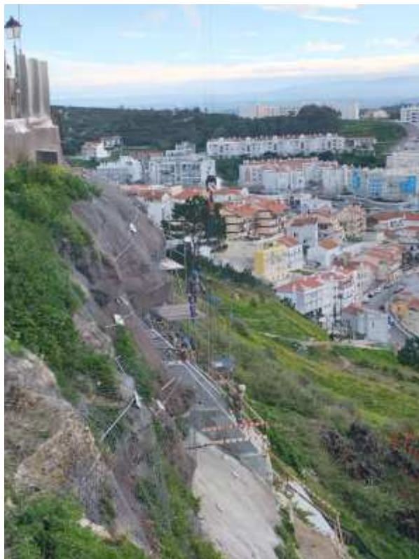
Foto 2 – Montagem de Andaime no Pano do Talude
