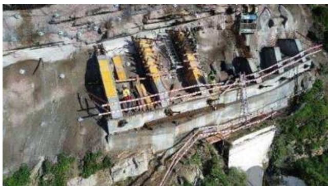
Frente de obra da plataforma Superior do Ascensor – Montagem da cofragem e armaduras para a segunda fase dos montantes;
