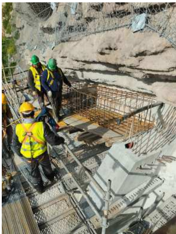
Foto 6 – Cofragem e Montagem de Armaduras da Viga Superior
