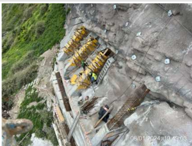
Frente de obra da plataforma Superior do Ascensor – Cofragem da segunda fase de 3 montantes;
