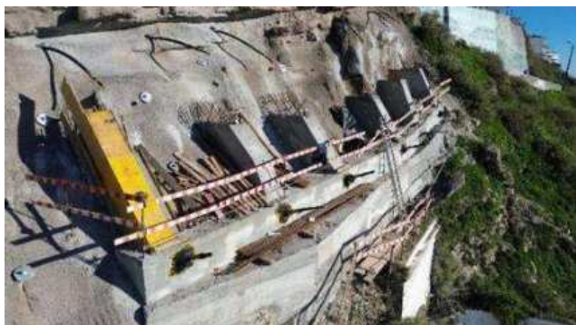
Plataforma Superior do Ascensor – Descofragem da primeira fase dos 6 montantes;
