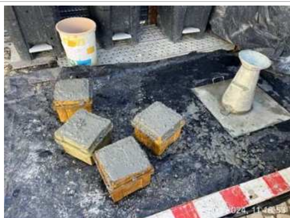
Frente de obra da plataforma Superior do Ascensor –4 Provetes para ensaio à compressão - 24/01/2024 - GR P518/0084724
