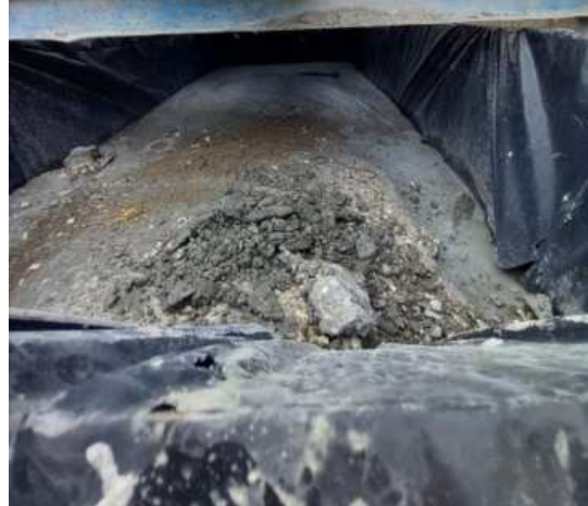
Fotografia 4 – Bacia de lavagem dos equipamentos de betão
