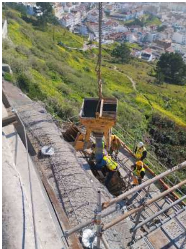
Foto 3 – Betonagem de Montantes Verticais 2ª Fase
