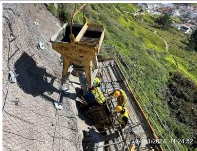
Frente de obra da plataforma Superior do Ascensor – Betonagem da terceira fase de 3 montantes;
