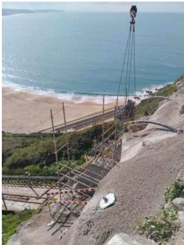
Foto 1 – Montagem de Andaime no Pano do Talude
