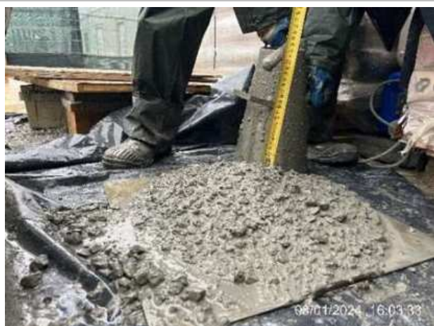
Frente de obra da plataforma Superior do Ascensor – Ensaio de Slump - 09/01/2023 - GR P518/0084248
