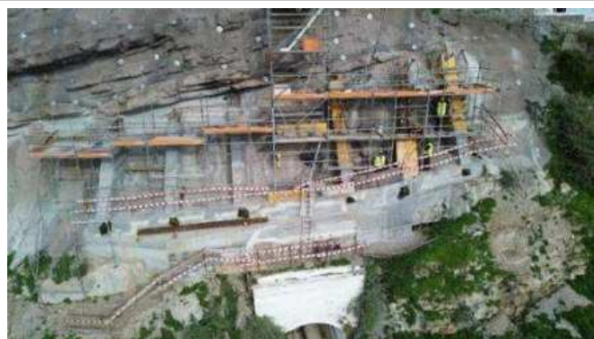
Frente de obra da plataforma Superior do Ascensor – Montagem da cofragem e armaduras para a terceira fase dos montantes;
