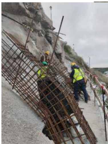
Figura 2 – Execução dos montantes
