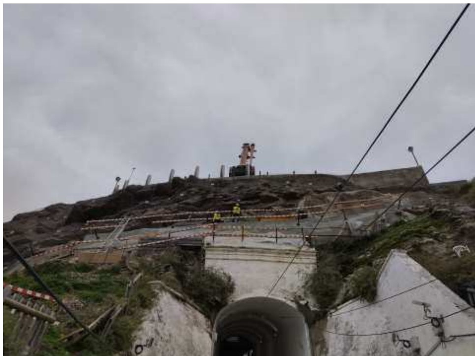
Foto 1 – Vista Geral da Frente de Trabalhos no Pano do Talude
