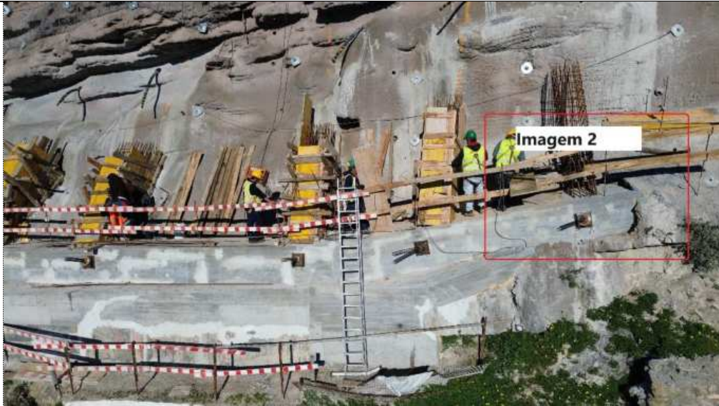
Imagem 1: Vista do Drone em 18/12/2023, pré-esforço aplicado em 14/12/2023
