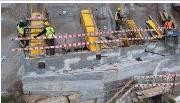
Frente de obra da plataforma Superior do Ascensor – Trabalhos de cofragens na primeira fase dos montantes.
