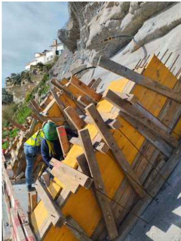
Foto 5 – Cofragem de Montantes Verticais 1ª Fase
