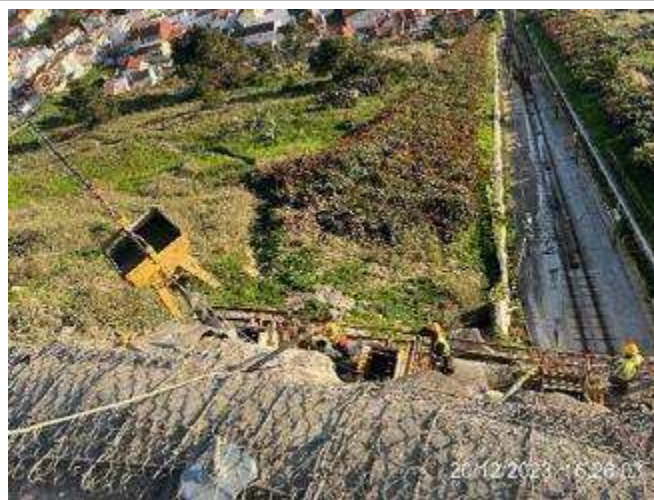
Frente de obra da plataforma Superior do Ascensor – Betonagem da primeira fase dos 6 montantes;
