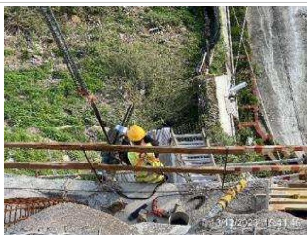
Frente de obra da plataforma Superior do Ascensor – Ensaio de pré-esforço simplificado na ancoragem A2.5
