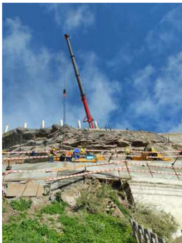
Foto 2 – Trabalhos de Aplicação de Tensionamento nas Ancoragens (Viga Inferior)
