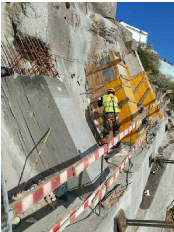
Foto 7 – Descobragem de Montantes Verticais 1ª Fase
