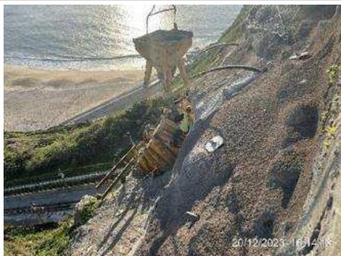
Frente de obra da plataforma Superior do Ascensor – Betonagem da primeira fase dos 6 montantes;
