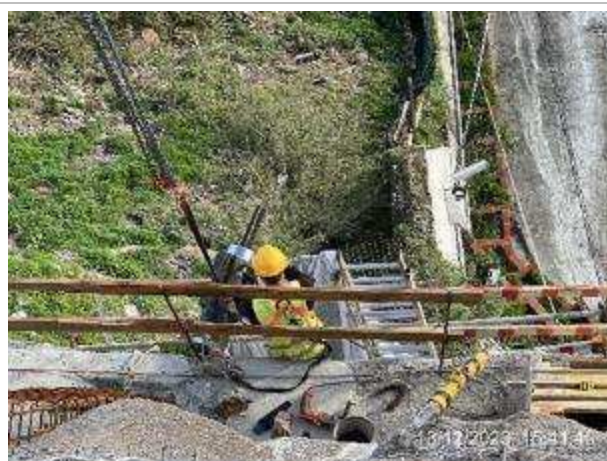
Frente de obra da plataforma Superior do Ascensor – Ensaio de pré-esforço simplificado na ancoragem A2.5
