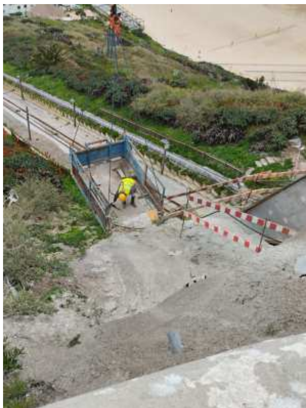
Foto 8 – Trabalhos de Remoção de Materiais Rochosos Soltos do Pano do Talude
