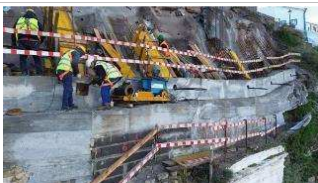
Frente de obra da plataforma Superior do Ascensor – Ensaio de pré-esforço simplificado na ancoragem A2.2
