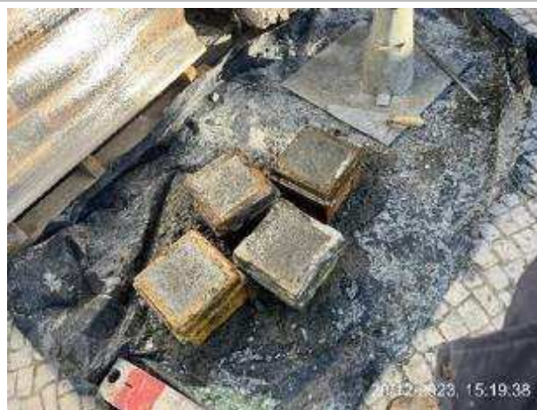
Frente de obra da plataforma Superior do Ascensor – 4 Provetes para ensaio à compressão - GR P518/0083971
