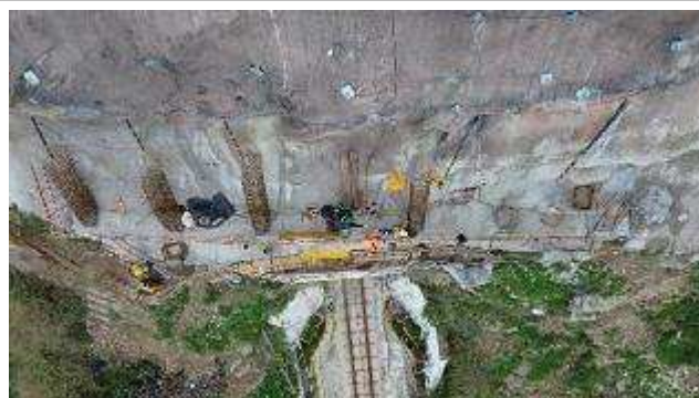
Frente de obra da plataforma Superior do Ascensor – Trabalhos de montagem das armaduras na primeira fase dos montantes;
