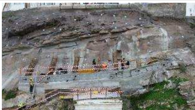
Plataforma Superior do Ascensor – Trabalhos de montagem das armaduras na primeira fase dos montantes;
