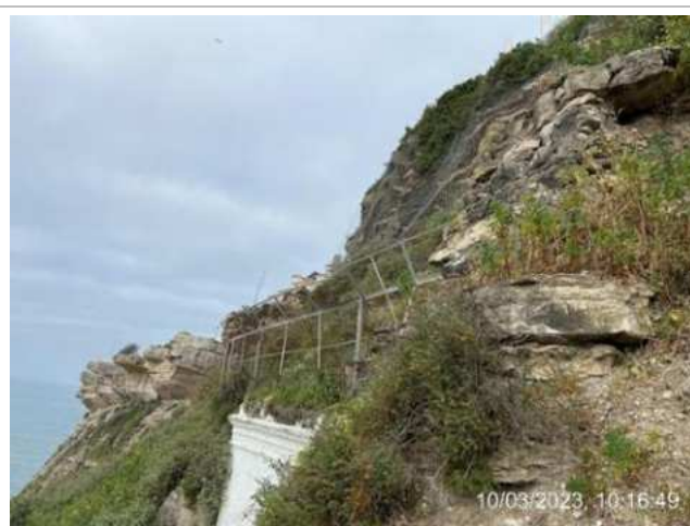
Criação de acesso pedonal à boca do túnel do ascensor para monitorização;
