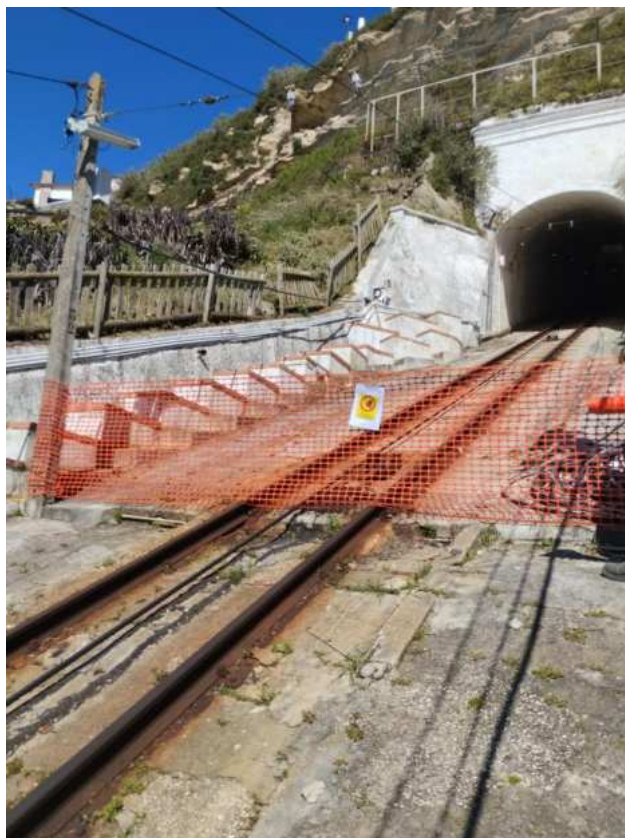
Foto 5 – Implementação de Perímetro de Segurança (Via do Ascensor)
