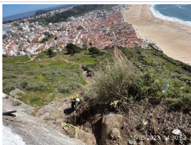
Início dos trabalhos de desmatção;
