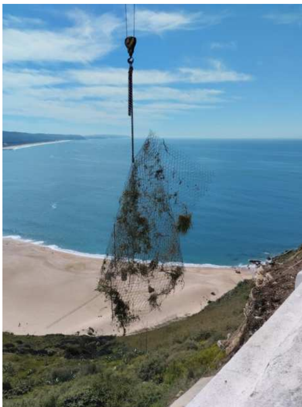
Foto 13 – Remoção de Redes Existentes no Pano do Talude
