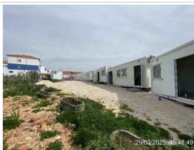
Limpeza do interior dos contentores do estaleiro;
