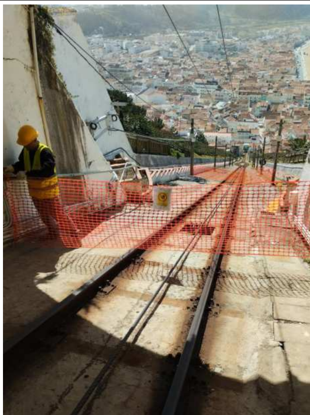
Foto 4 – Implementação de Perímetro de Segurança (Via do Ascensor)
