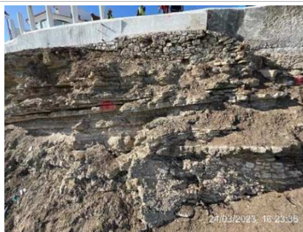
Implantação topográfica das ancoragens e vigas;
