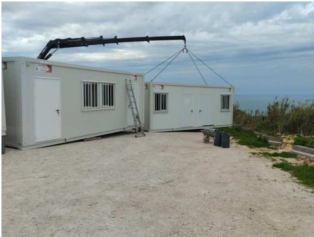
Foto 15 – Trabalhos de Colocação de Contentores no Estaleiro Social
