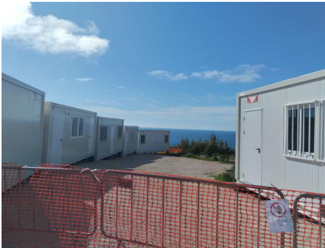
Foto 16 – Vista Geral do Estaleiro Social
