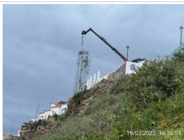
Remoção da rede de contenção ;
