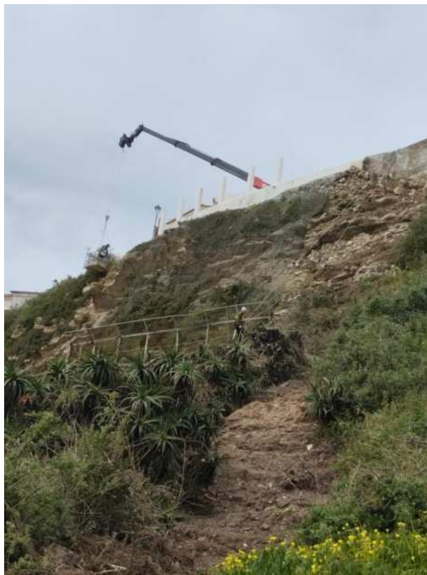
Foto 12 – Vista Geral da Frente de Trabalho após Desmatção
