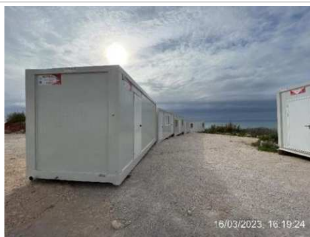
Colocação dos contentores no local definido na planta de estaleiro;
