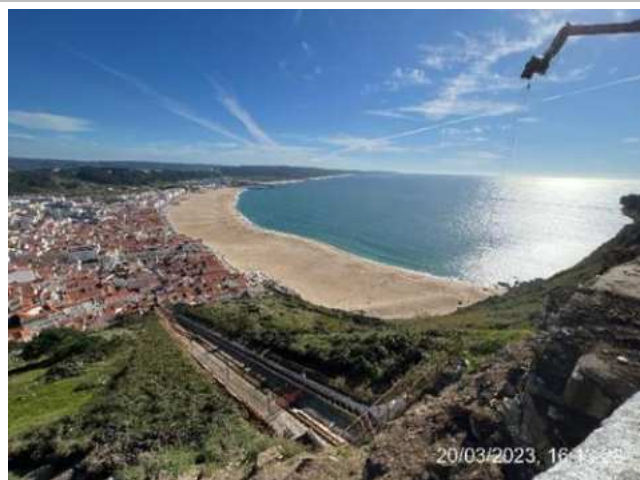
Trabalhos de desmatação;
