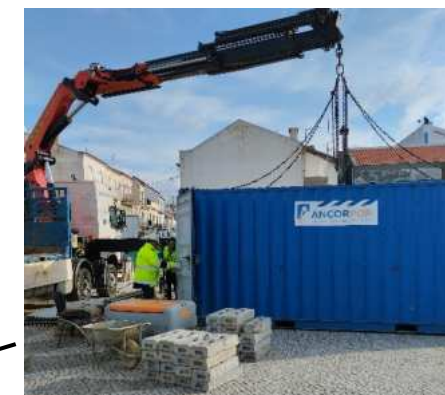
Figura 1 – Montagem do Estaleiro do Ascensor
