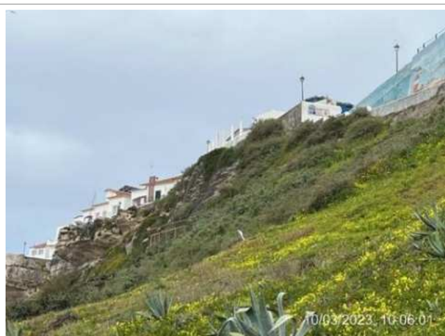
Criação de acesso pedonal à boca do túnel do ascensor para monitorização;
