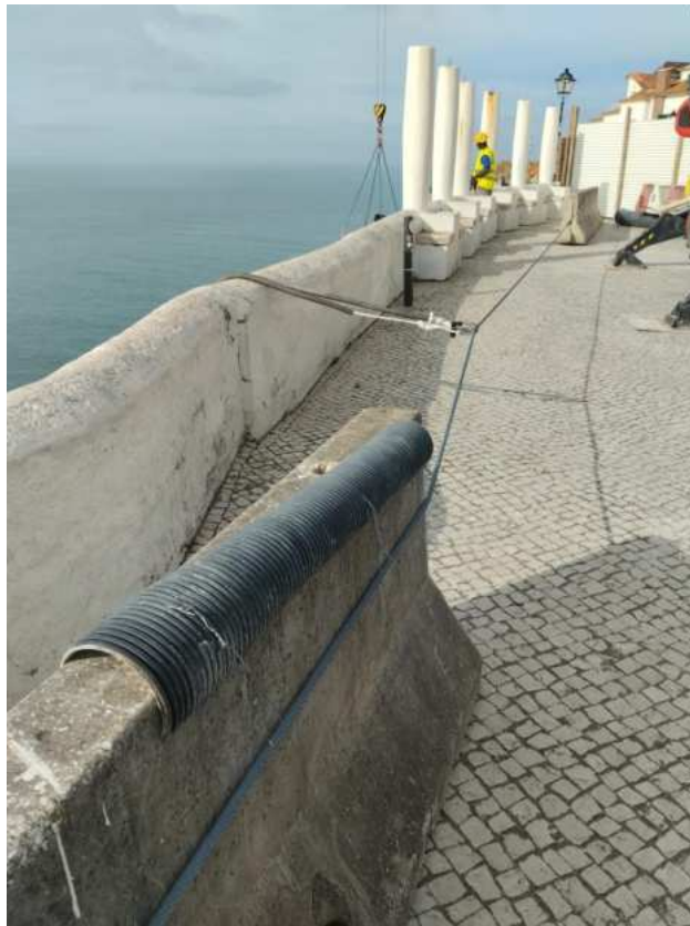
Foto 9 – Vista Geral do Sistema de Linha de Vida para Suspensão dos Alpinistas
