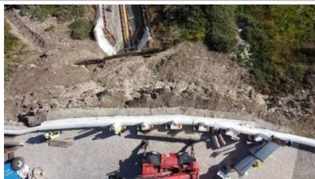
Implantação topográfica das ancoragens e vigas;
