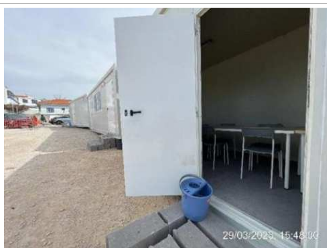
Limpeza do interior dos contentores do estaleiro;
