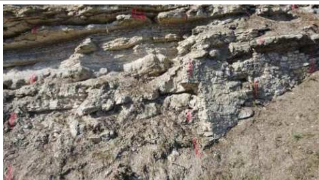
Implantação topográfica das ancoragens e vigas;
