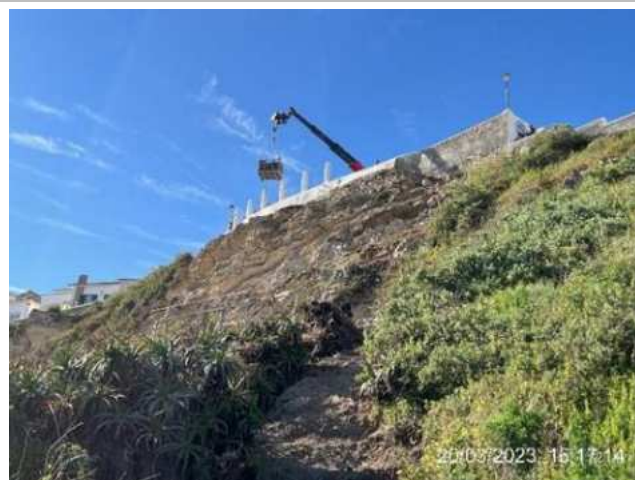
Trabalhos de desmatação;
