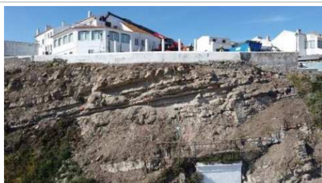
Implantação topográfica das ancoragens e vigas;
