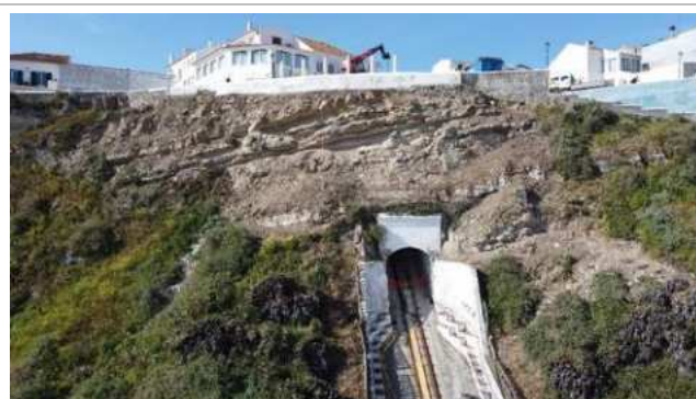
Implantação topográfica das ancoragens e vigas;
