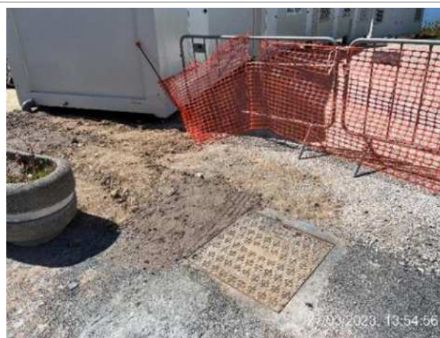
Ligação do contentor dos WC's à rede de esgoto;
