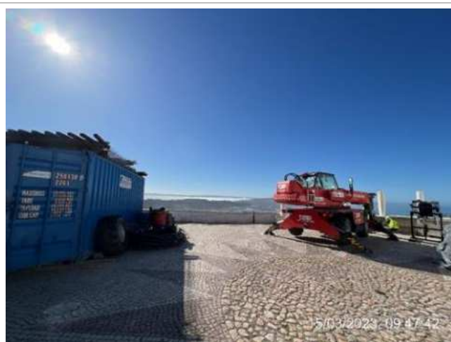
Estaleiro de obra na Plataforma Superior do Ascensor;
