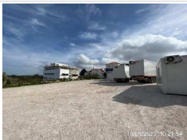
Chegada dos contentores do estaleiro;
