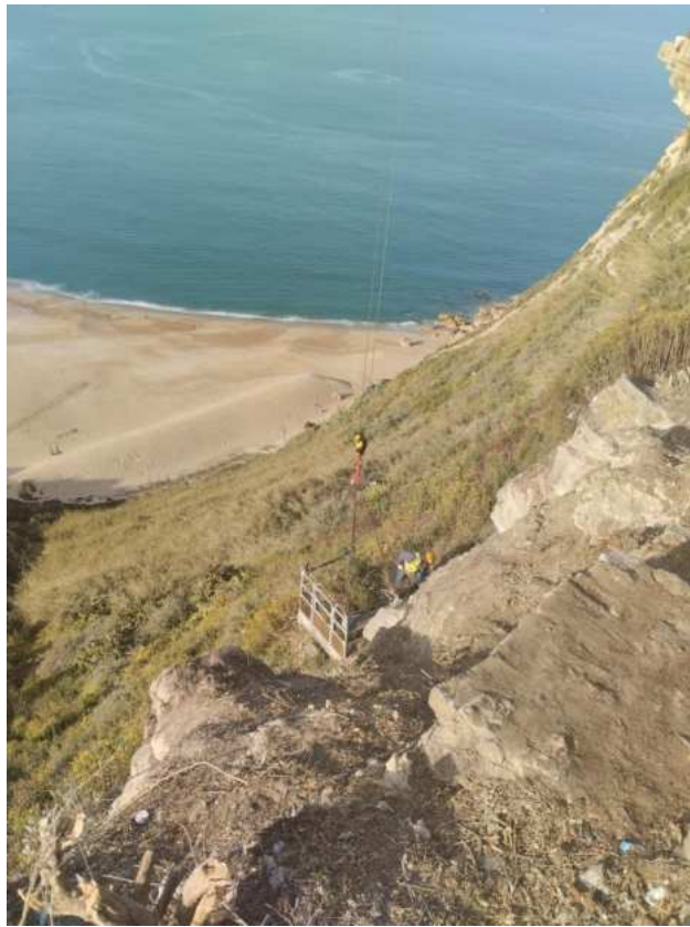
Foto 14 – Remoção de Vegetação com Recurso a Bailéu de Transporte
