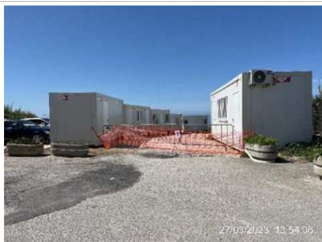
Vedação do estaleiro com rede;
