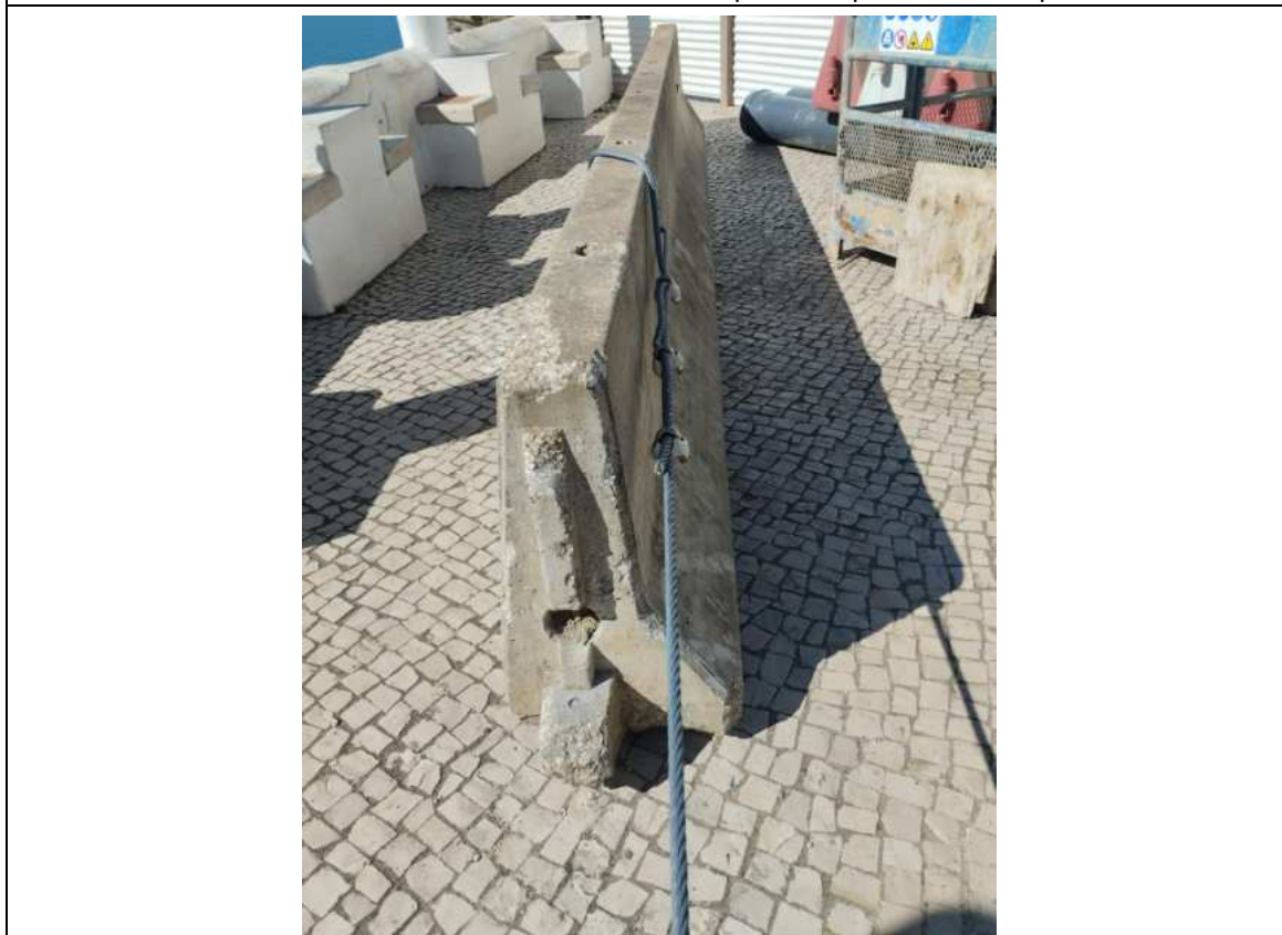
Foto 2 – Amarrações do Sistema de Linha para Suspensão dos Alpinistas
