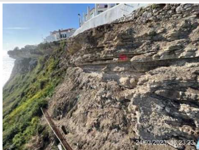
Implantação topográfica das ancoragens e vigas;
