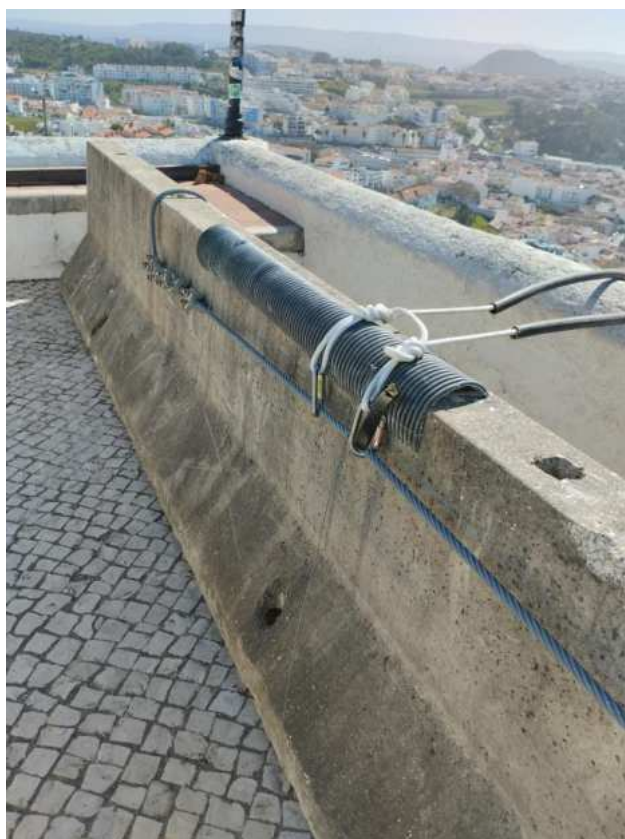
Foto 3 – Amarrações do Sistema de Linha para Suspensão dos Alpinistas
