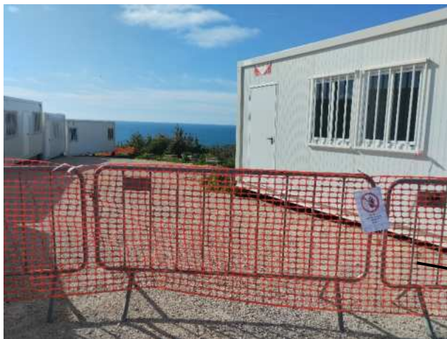
Figura 4 – Montagem do Estaleiro (Parque de Estacionamento)
