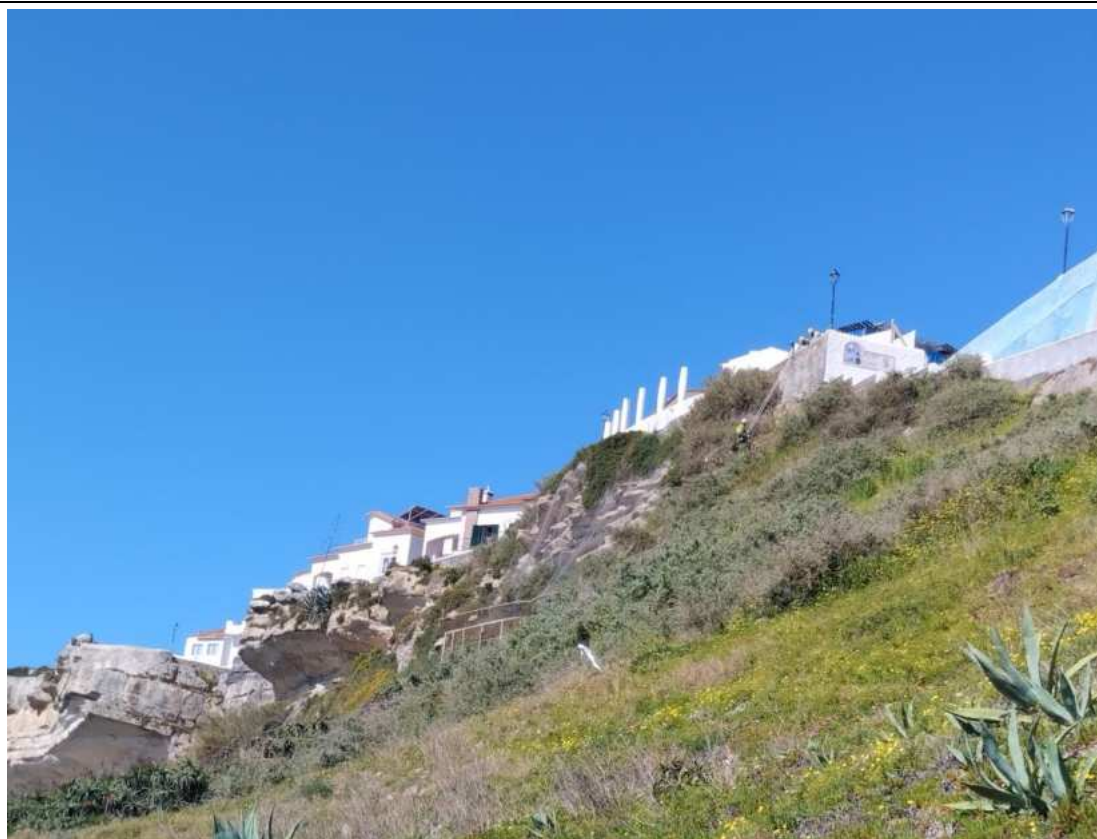
Foto 6 – Vista Geral da Frente de Trabalhos (Antes da Desmatção)
