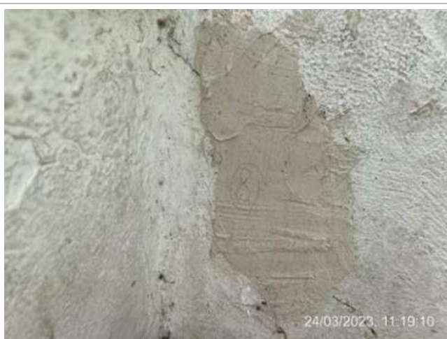
Monitorização de testemunhos em gesso no muro;
